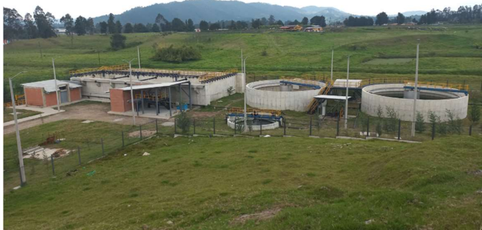
Ilustración. Vista general de la PTAR Construida – Ene 2024. Facatativá
