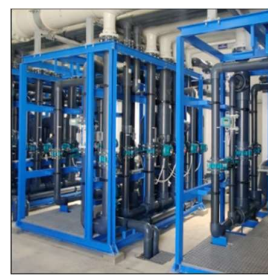
Bastidores de ósmosis inversa y ultrafiltración.
