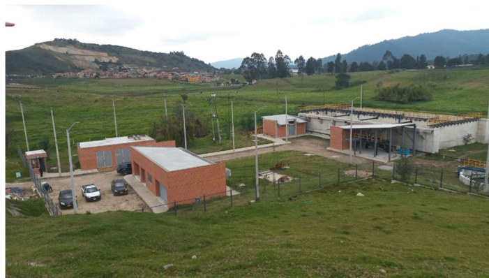
Ilustración. Vista general de la PTAR Construida – Ene 2024. Facatativá
