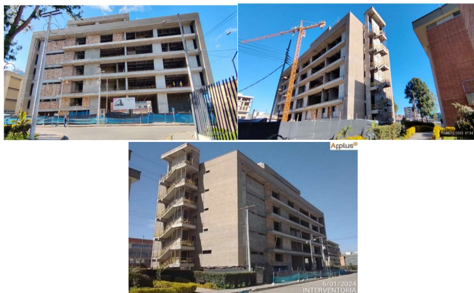
Ilustración. Edificio del Comando de la Brigada XIII del ejército, ubicado en el cantón norte de Bogotá – enero 2024
