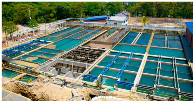
Ilustración: Modernización de la Planta de Tratamiento de Agua Potable PTAP La Esmeralda y la implementación del Plan de Recuperación de Pérdidas de Agua
