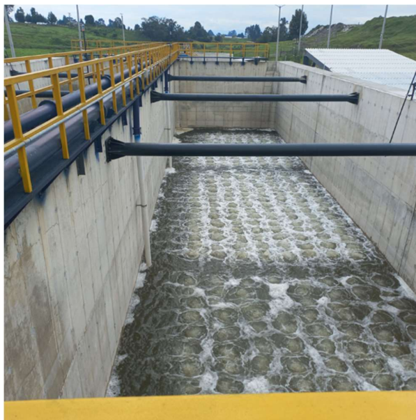
Ilustración. Prueba de funcionamiento tanque de aireación construido – Ene 2024. Facatativá
