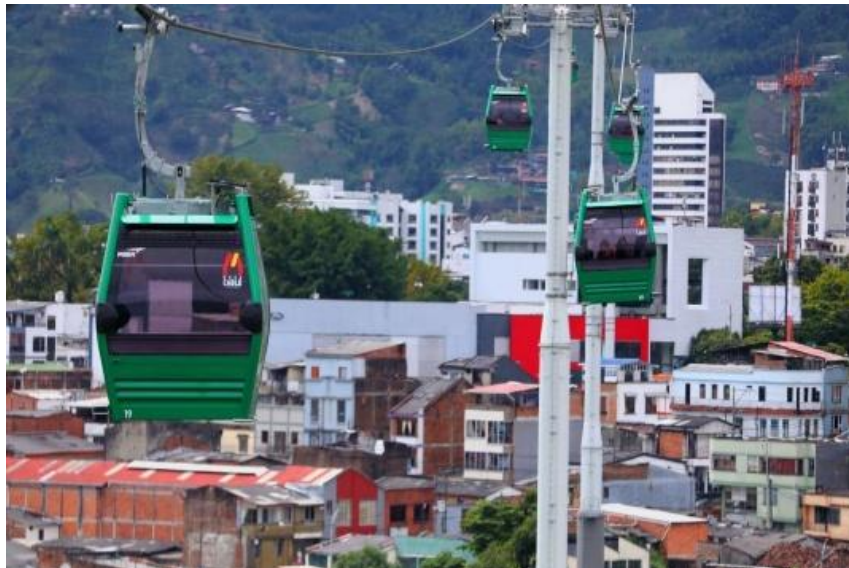
Ilustración No. 65: Cable aéreo en Pereira
