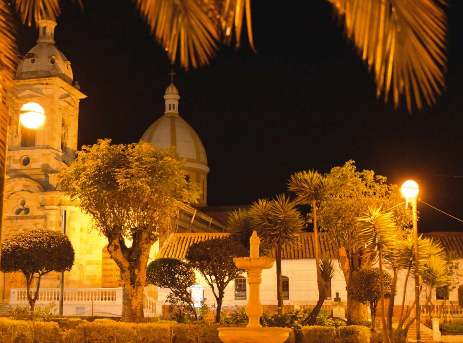
Paipa, Boyacá, tendrá la mitad del alumbrado con luminarias tipo LED a mediados de 2021, gracias al convenio de cooperación entre Findeter y BID-GEF.
