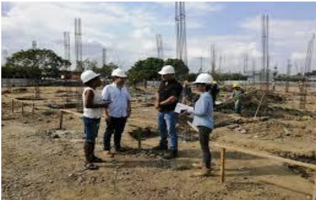
Ilustración No. 26: Construcción servicios de salud- Montería
