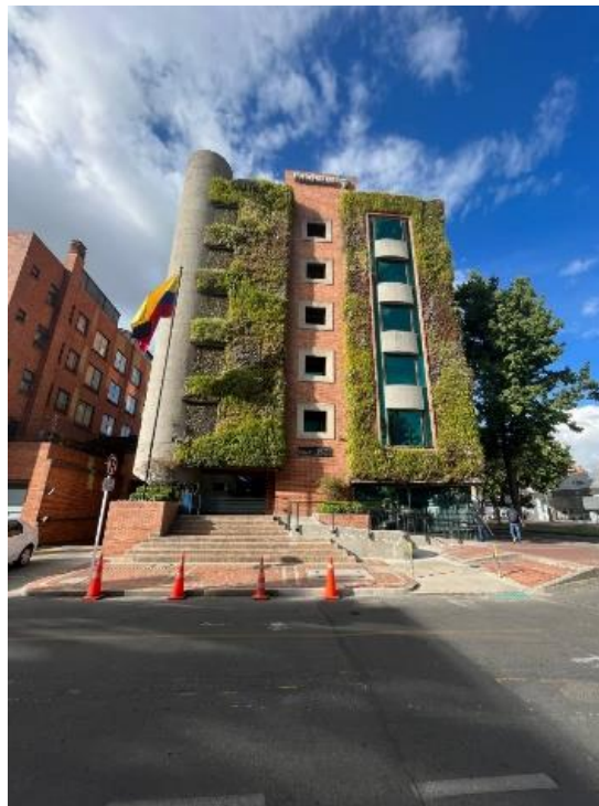
Ilustración No. 53: Jardín vertical en fachada principal Findeter
