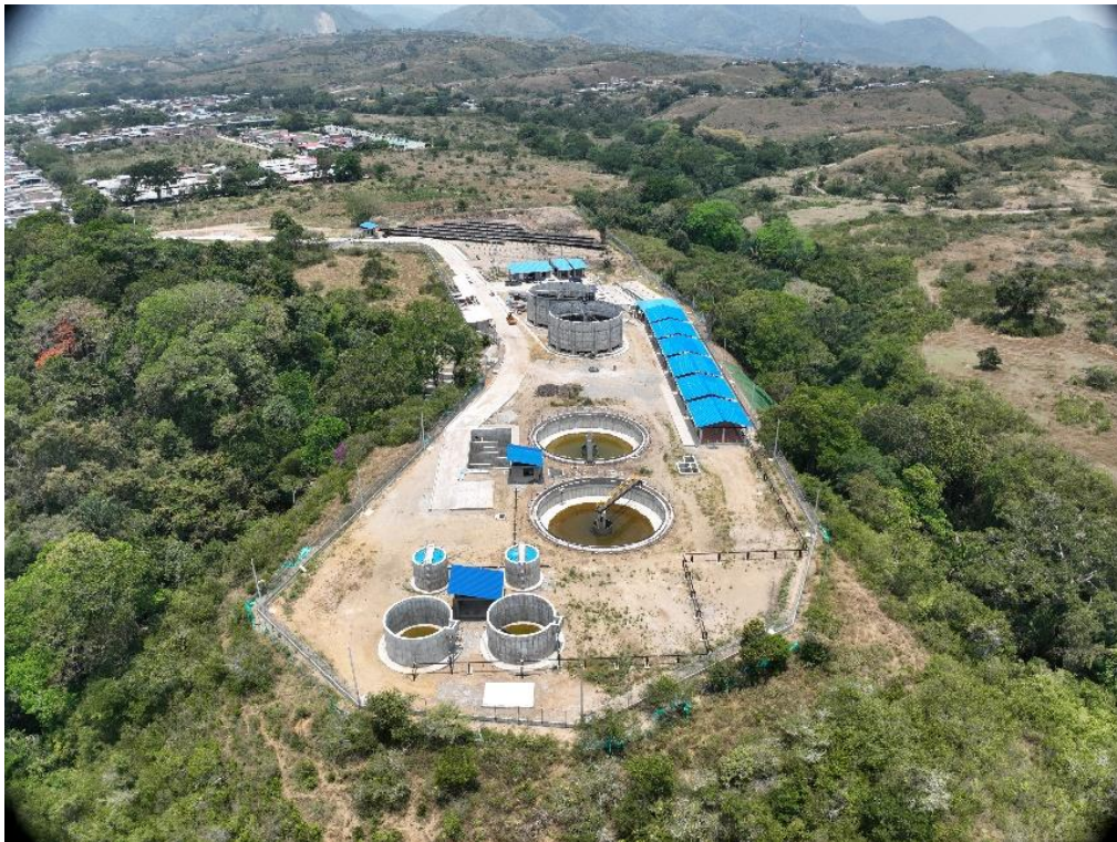
Vista de la PTAR, 08/11/2024
