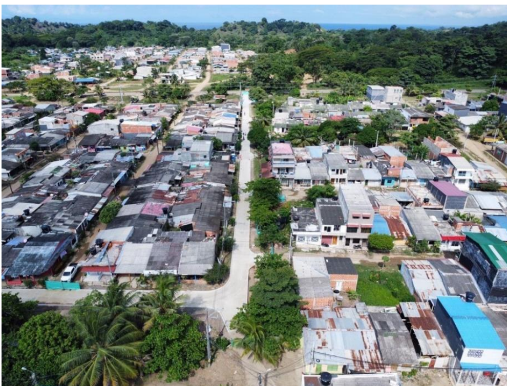
Fuente: Panorámica intervención vías – diciembre 2024
