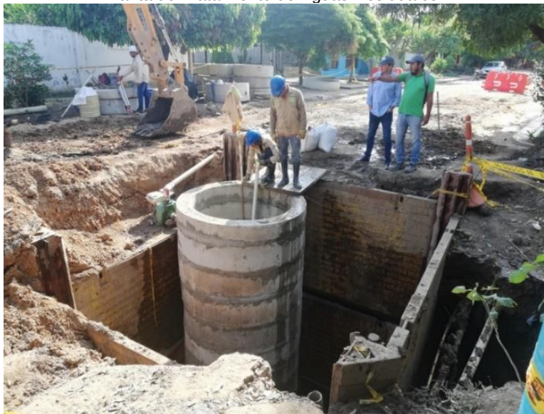
Instalación de redes de alcantarillado.
