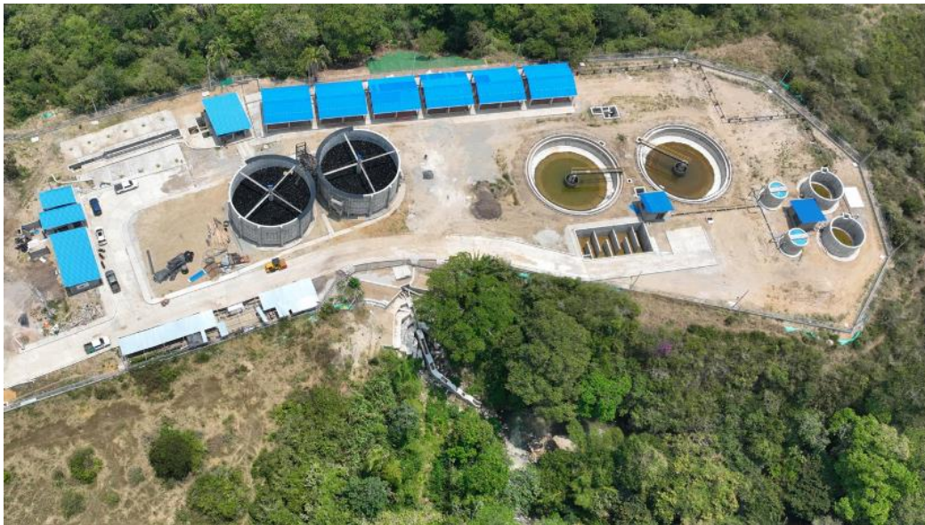
Estructuras de tratamiento que conforman la PTAR, 15/11/2024
