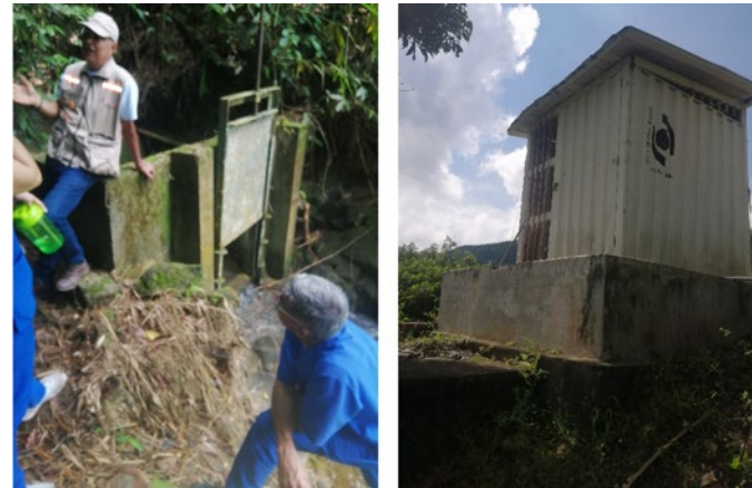
Figura 2.3 Acueducto del centro poblado Modín
