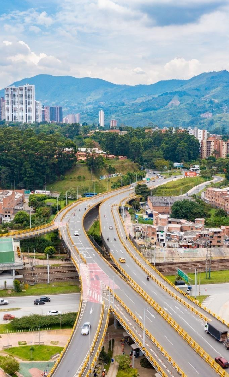
Foto: intercambiador vial, Sabaneta, Antioquia.
