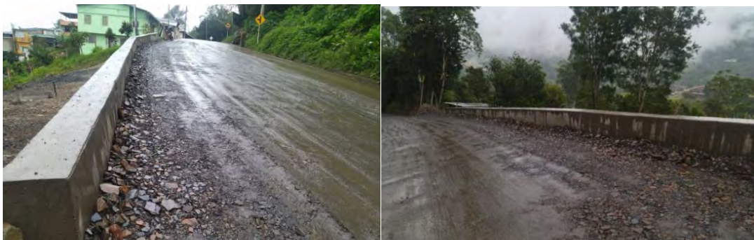
Registro Fotografico No 1 – No 2. Obra fiinalizada, Muro de contención de 30 Metros.
