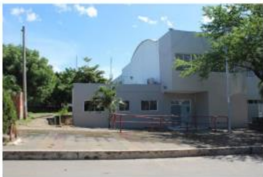
FOTO 3 – Esquina Sur-Occidental del lote
