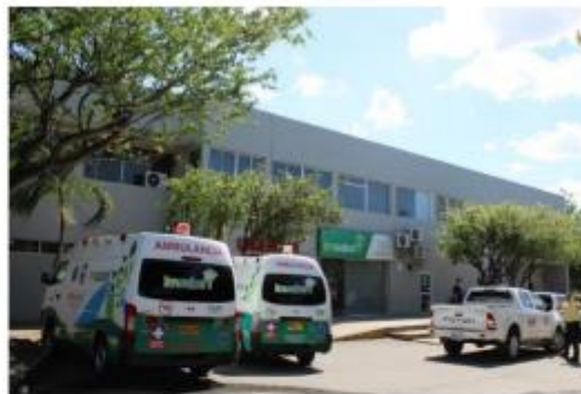
FOTO 2 – Fachada sur edificación actual
