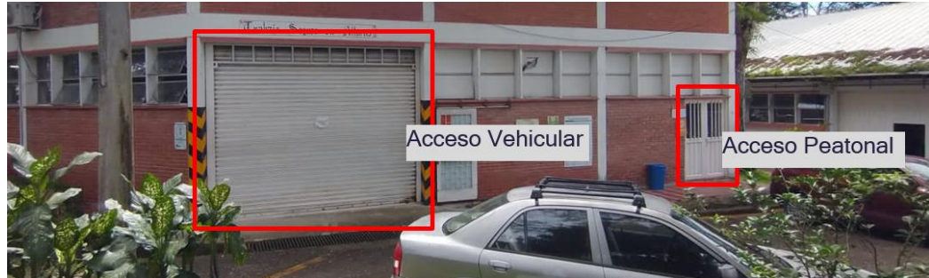
Ilustración 9 | puertas de acceso primer nivel bloque 8 – Fuente: Diagnostico arquitectónica ilustración 64.
