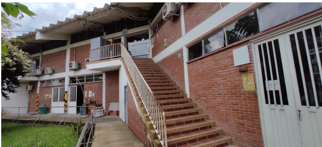
Ilustración 6 | Escalera de acceso segundo piso noreste bloque 8 - Fuente: Propia
