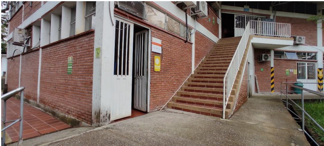
Ilustración 5 | Escaleras acceso segundo piso sureste bloque 8 - Fuente: Propia
