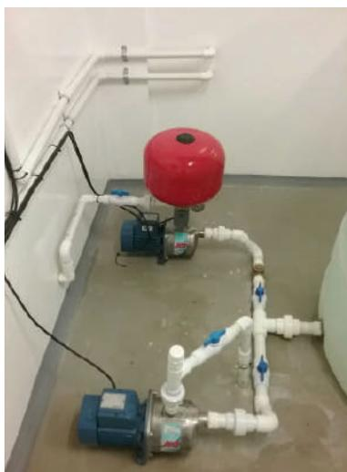
Ilustración 376. Bombas inyectoras de 1 HP. Espacio 3.
