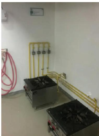
Ilustración 392. Tubería Hg de 1/2".
