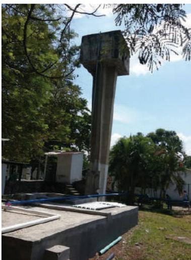
Ilustración 408. Tanque elevado en concreto de 1 m<sup>3</sup>. Espacio exterior.
