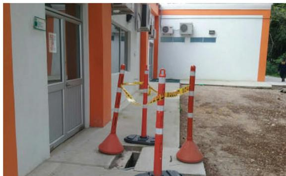
Ilustración 398. Cajas de inspección de 0,80 x 0,80 espacio exterior.
