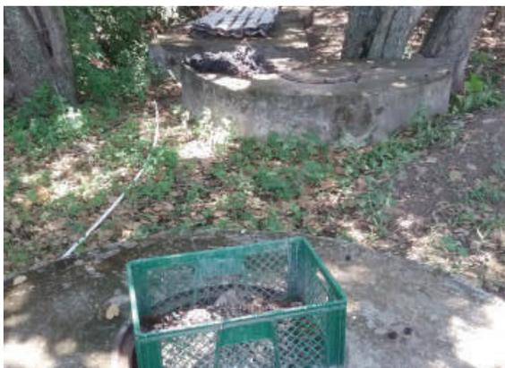
Ilustración 279. Pozos de inspección sin tapa en espacio exterior.
