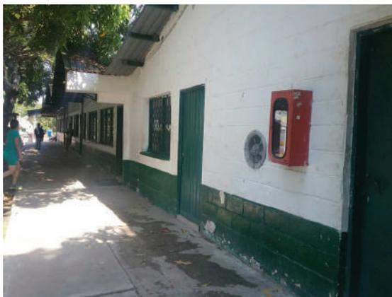
Ilustración 332. Extintor multipropósito de 10 lbs gabinete. Espacio exterior.
