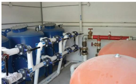
Ilustración 409. Equipo de presión agua potable. Espacio 2.
