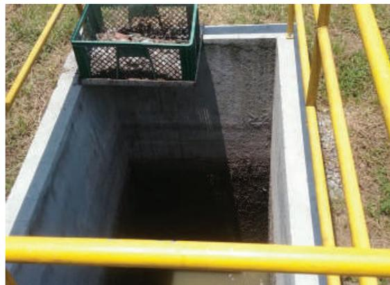
Ilustración 280. Tanque de aguas residuales de 9 m3. Espacio exterior.
