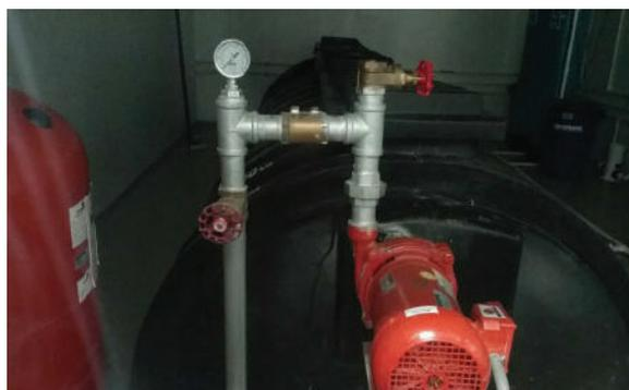
Ilustración 394. Bomba inyectora de 3 Hp. Espacio 6.
