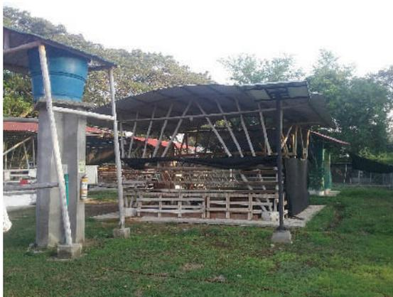
Ilustración 306. Tanque plástico de 500 lts. Espacio exterior.
