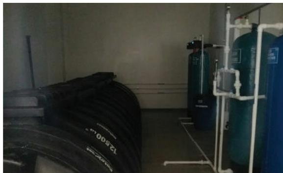
Ilustración 393. Tanque de almacenamiento de agua tratada de 12.500 lts. Espacio 6.
