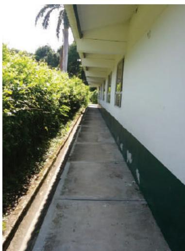
Ilustración 362. Manejo de aguas lluvias con cuneta perimetral en piso 1°.
