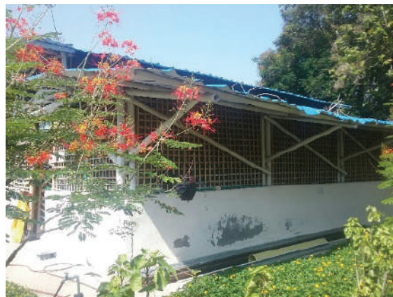
Ilustración 189 tubería PVC expuesta. Fuente. Equipo de diagnóstico.
