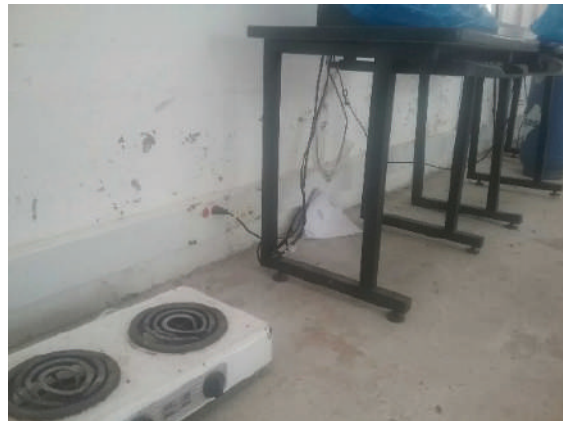
Ilustración 174 canaleta metálica. Fuente. Equipo de diagnóstico.
