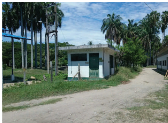
Ilustración 160. Espacio exterior Fuente equipo Diagnostico
