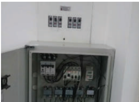
Ilustración 255 Conductores no cumplen código de colores. Fuente. Equipo de diagnóstico.
