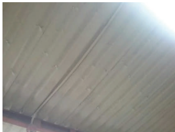
Ilustración 222 tubería PVC. Fuente. Equipo de diagnóstico.
