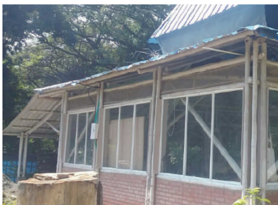
Ilustración 188 ubicación tablero de distribución. Fuente. Equipo de diagnóstico.
