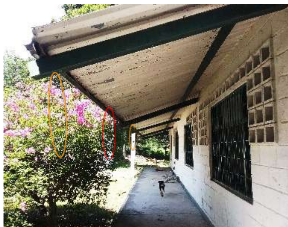
Ilustración 217. Evidencia ausencia elementos estructurales Bloque 28 Fuente. Equipo de diagnóstico
