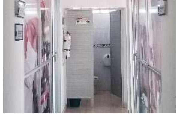
Ilustración 249. Estructura Bloque 34 Fuente. Equipo de diagnóstico
