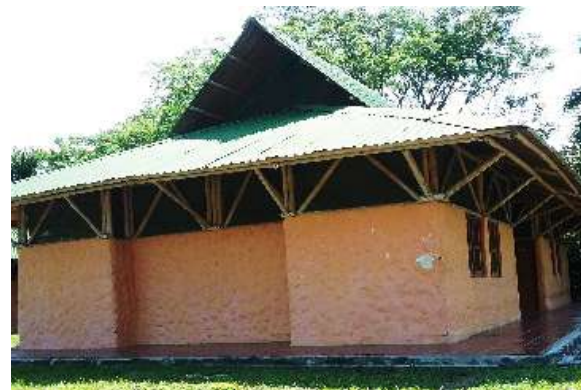
Ilustración 305. Estructura Bloques 45-46-47-48 Fuente. Equipo de diagnóstico
