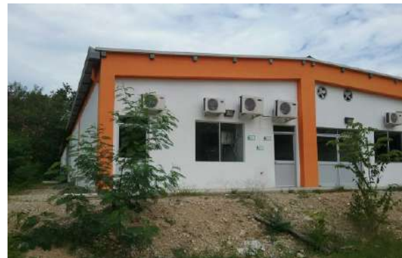
Ilustración 304. Estructura Bloque 44 Fuente. Equipo de diagnóstico
