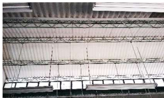
Ilustración 268. Cubierta Bloque 37 Fuente. Equipo de diagnóstico
