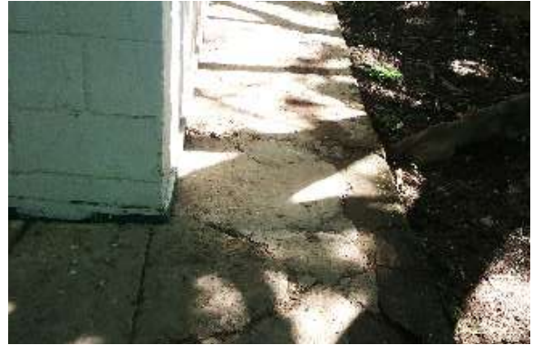
Ilustración 212. Andenes perimetrales Bloque 28 Fuente. Equipo de diagnóstico
