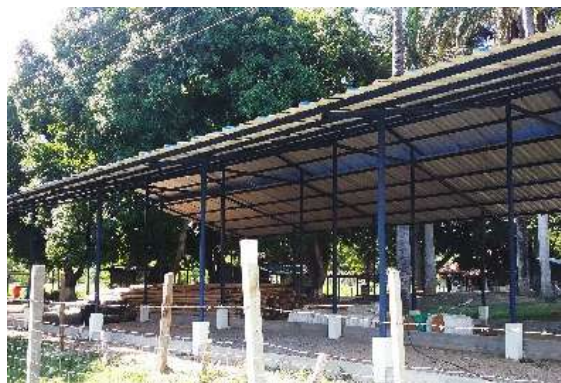
Ilustración 272. Estructura Bloque 38 Fuente. Equipo de diagnóstico
