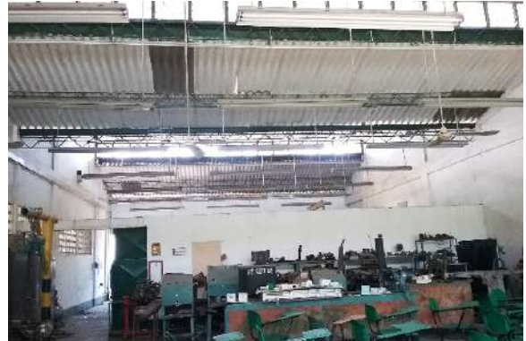
Ilustración 265. Estructura Bloque 37 Fuente. Equipo de diagnóstico
