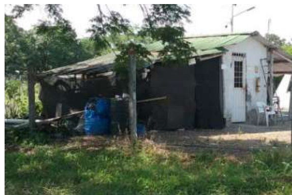
Ilustración 240. Estructura Bloque 32 Fuente: Equipo de diagnóstico
