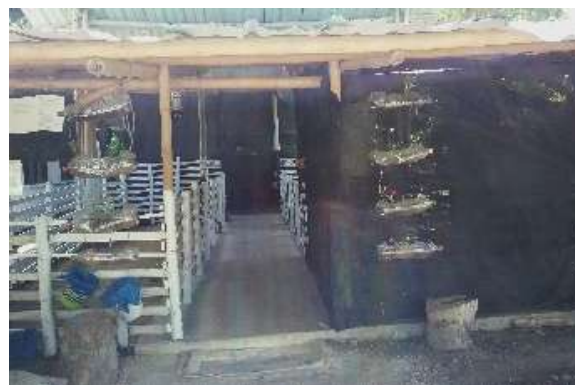
Ilustración 244. Estructura Bloque 33 Fuente: Equipo de diagnóstico
