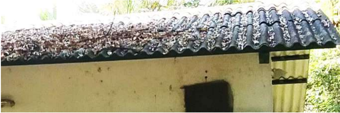
Ilustración 214. Cubierta Bloque 28 Fuente. Equipo de diagnóstico
