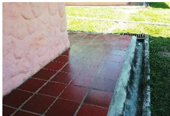
Ilustración 306. Andenes perimetrales Bloque 4 Fuente. Equipo de diagnóstico
