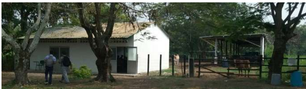
Ilustración 347. Bloque No. 5. Fuente: Equipo de diagnóstico
