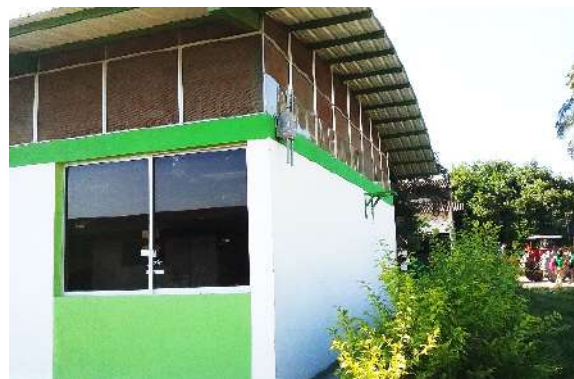
Ilustración 285. Estructura Bloque 41 Fuente. Equipo de diagnóstico
