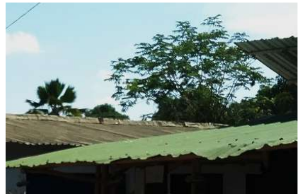
Ilustración 246. Cubierta Bloque 33 Fuente. Equipo de diagnóstico
