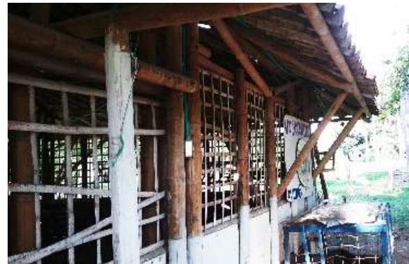
Ilustración 277. Estructura Bloque 39 Fuente: Equipo de diagnóstico
