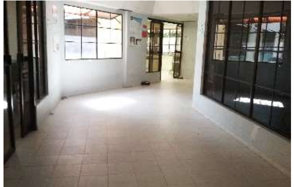
Ilustración 296. Estructura Bloque 43 Fuente. Equipo de diagnóstico
