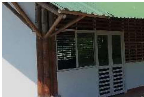
Ilustración 235. Estructura Bloque 31 Fuente. Equipo de diagnóstico
