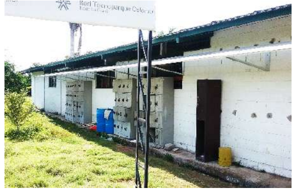
Ilustración 291. Estructura Bloque 42 Fuente. Equipo de diagnóstico
