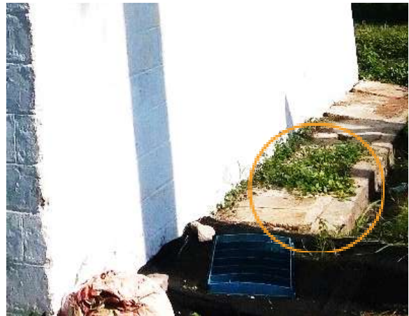
Ilustración 292. Evidencia de invasión vegetal a cunetas y andenes Bloque 42 Fuente. Equipo de diagnóstico
