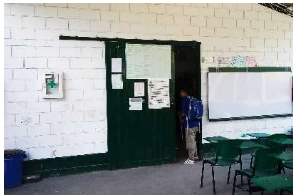
Ilustración 281. Estructura Bloque 40 Fuente. Equipo de diagnóstico
