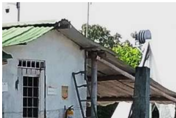
Ilustración 241. Cubierta Bloque 32 Fuente. Equipo de diagnóstico
