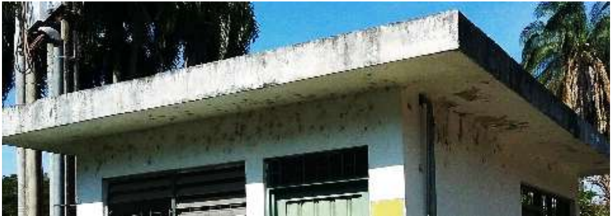
Ilustración 273. Cubierta Bloque 38 Fuente. Equipo de diagnóstico
