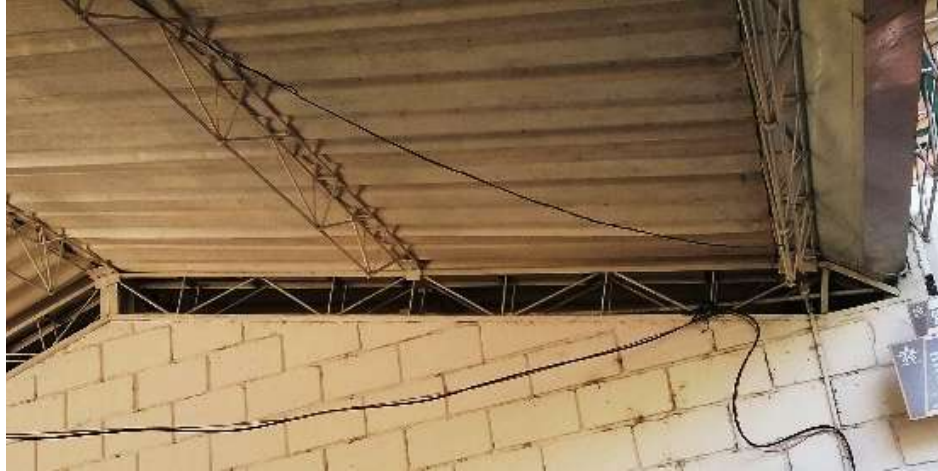
Ilustración 283. Cubierta Bloque 40 Fuente. Equipo de diagnóstico
