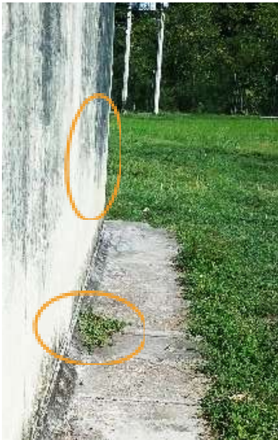
Ilustración 301. Evidencia de invasión vegetal andenes Bloque 43 Fuente. Equipo de diagnóstico
