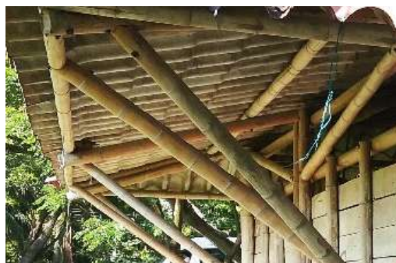
Ilustración 279. Cubierta Bloque 39 Fuente. Equipo de diagnóstico
