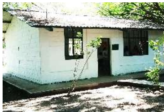
Ilustración 211. Estructura Bloque 28 Fuente: Equipo de diagnóstico
