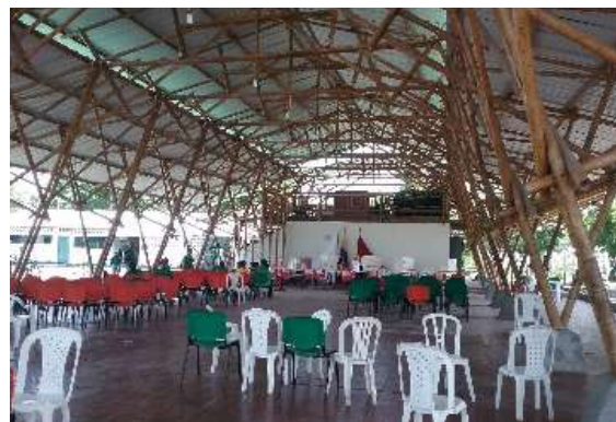
Ilustración 222. Estructura Bloque 29 Fuente: Equipo de diagnóstico
