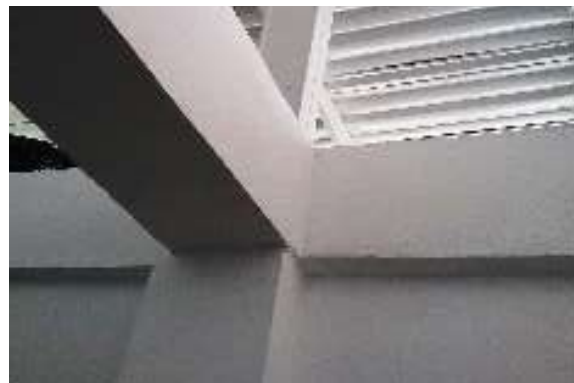
Ilustración 263. Cubierta Bloque 36 Fuente. Equipo de diagnóstico
