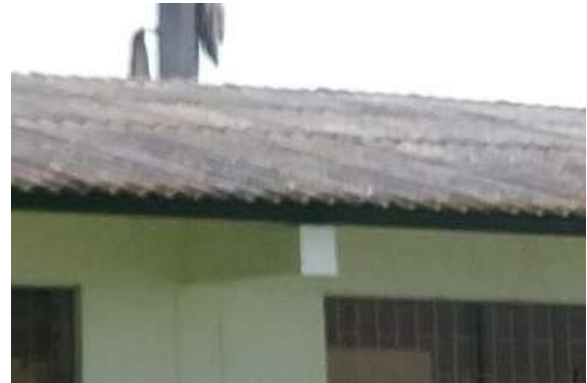
Ilustración 258. Cubierta Bloque 35 Fuente. Equipo de diagnóstico
