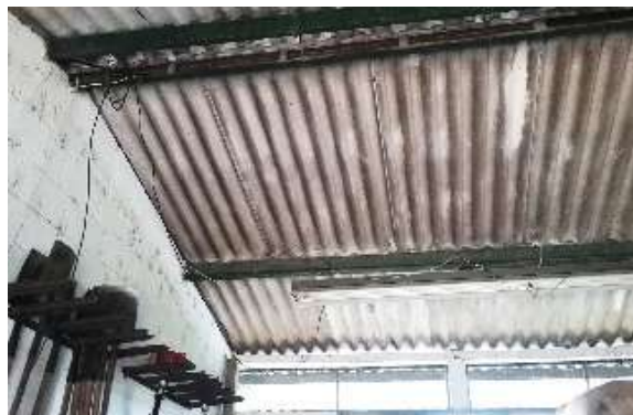
Ilustración 294. Cubierta Bloque 42 Fuente. Equipo de diagnóstico
