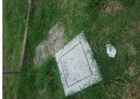
Ilustración 239 Pozos de inspección exteriores Bloque 13 Fuente: Equipo de diagnóstico
