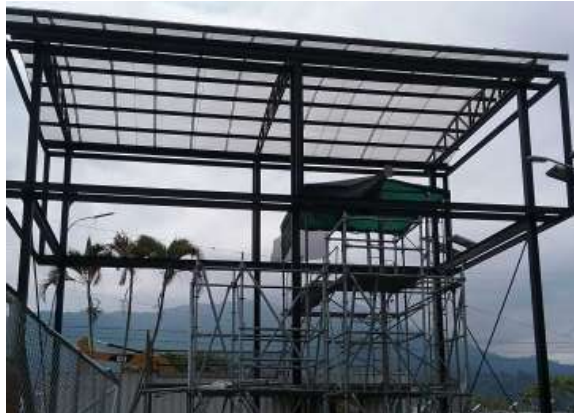
Ilustración 349 Sistema de desagües de aguas lluvias Bloque 61. Fuente: Equipo de diagnóstico
