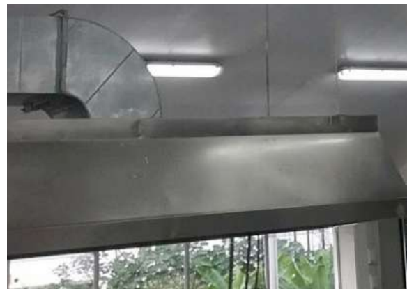
Ilustración 184. Extractor de humo bloque 51. Fuente: Equipo diagnóstico.
