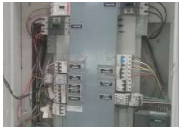
Ilustración 121. Tablero bloque 34. Fuente: Equipo diagnóstico.
