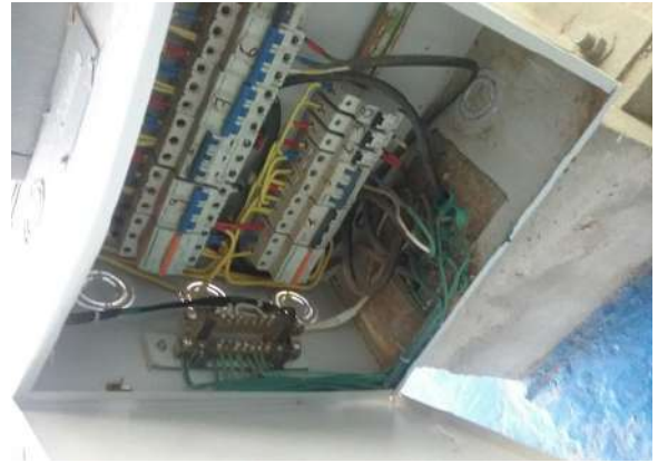
Ilustración 54. Tablero Fuente: Equipo Diagnostico
