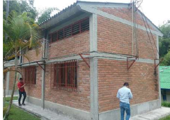
Ilustración 281 Sistema de desagües de aguas lluvias Bloque 35. Fuente: Equipo de diagnóstico
