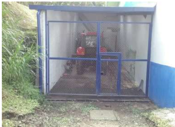
Ilustración 343 Sistema de desagües de aguas lluvias Bloque 59. Fuente: Equipo de diagnóstico
