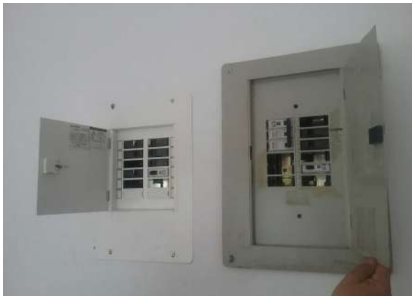
Ilustración 58. Tablero Fuente: Equipo Diagnostico
