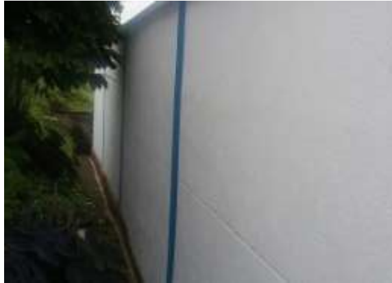
Ilustración 299 Sistema de desagües de aguas lluvias Bloque 41. Fuente: Equipo de diagnóstico
