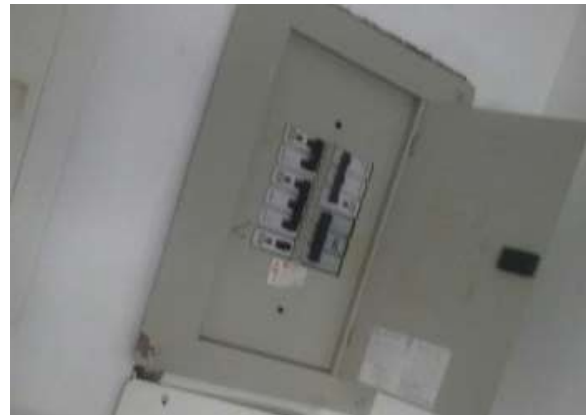
Ilustración 59. Tablero Fuente: Equipo Diagnostico
