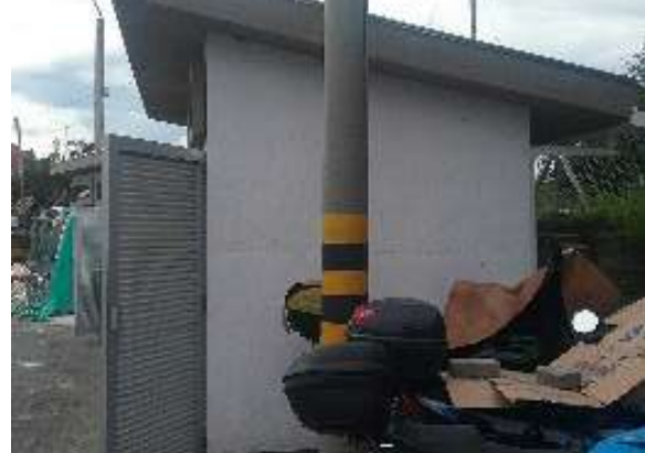
Ilustración 251 Sistema de desagües de aguas lluvias Bloque 20. Fuente: Equipo de diagnóstico
