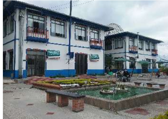
Ilustración 291 Sistema de desagües Bloque 38. Fuente: Equipo de diagnóstico
