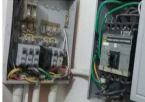
Ilustración 154. Tablero bloque 44. Fuente: Equipo diagnóstico.
