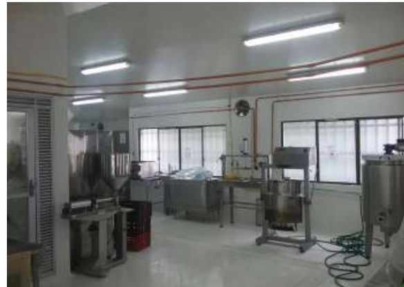
Ilustración 280 Aparatos gasodomésticos y redes de gas en Bloque 34. Fuente. Equipo de diagnóstico
