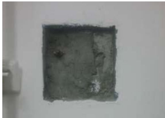
Ilustración 289 Válvulas de control de espacio Bloque 38. Fuente: Equipo de diagnóstico
