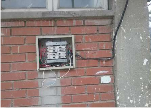
Ilustración 74. Tablero Fuente: Equipo Diagnostico
