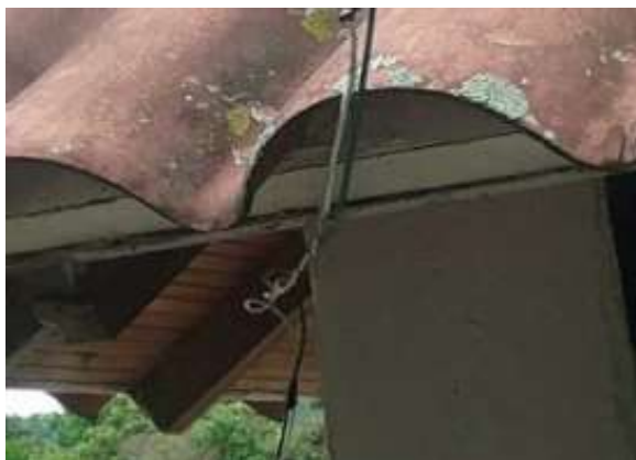
Ilustración 189. Tablero bloque 53. Fuente: Equipo diagnóstico.
