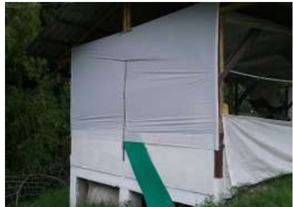
Ilustración 269 Sistema de desagües de aguas lluvias Bloque 30. Fuente: Equipo de diagnóstico
