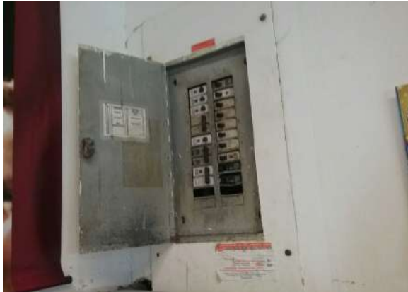
Ilustración 32. Tablero Fuente: Equipo Diagnostico
