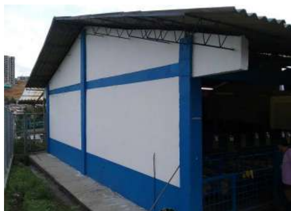
Ilustración 261 Sistema de desagües de aguas lluvias Bloque 25. Fuente: Equipo de diagnóstico
