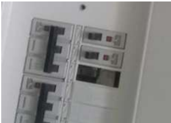
Ilustración 120. Tablero bloque 34. Fuente: Equipo diagnóstico.
