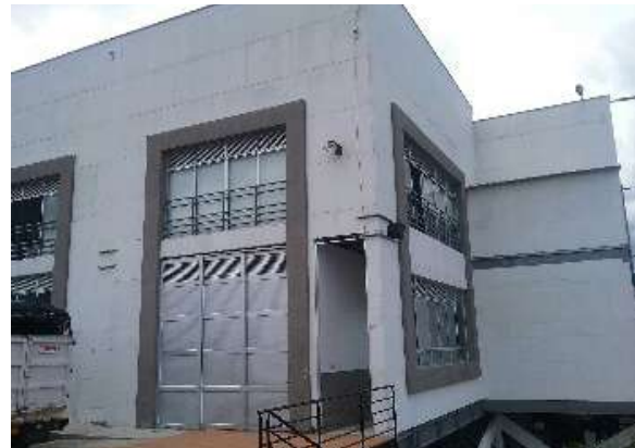
Ilustración 232. Estado de canales y bajantes de las cubiertas de Bloque 10 Fuente: Equipo de diagnóstico
