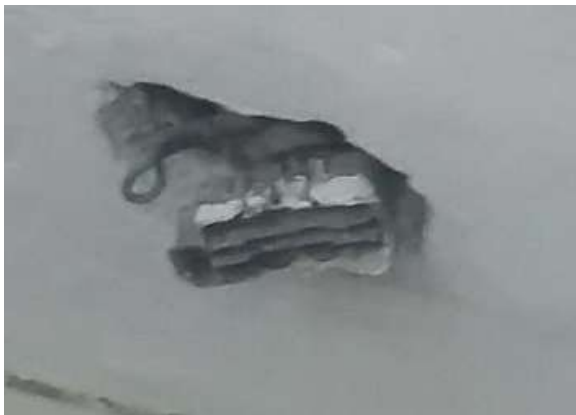
Ilustración 138. Tablero bloque 38 Fuente: Equipo diagnóstico
