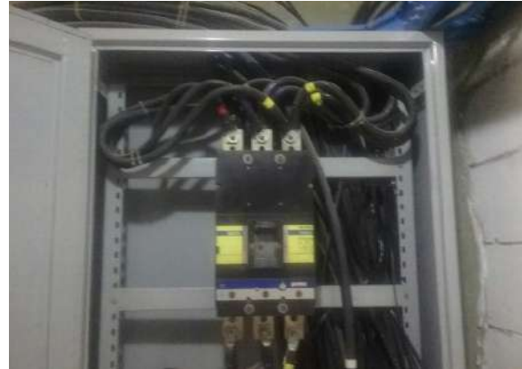
Ilustración 33. Tablero Fuente: Equipo Diagnostico
