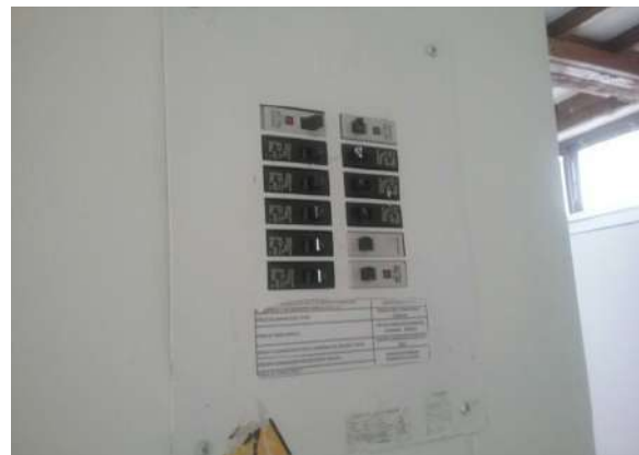
Ilustración 85. Tablero Fuente: Equipo Diagnostico
