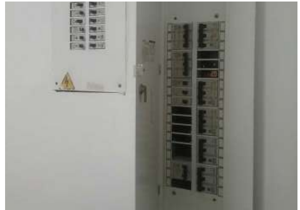
Ilustración 56. Tablero Fuente: Equipo Diagnostico
