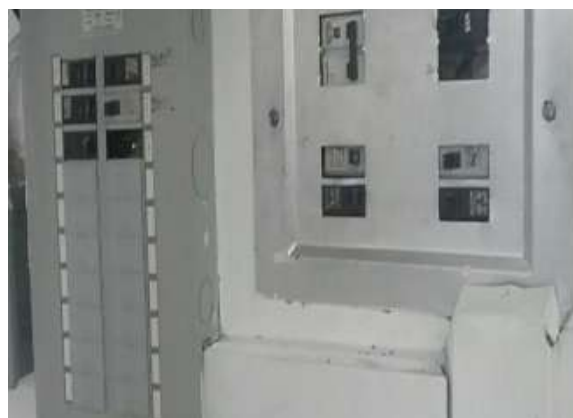
Ilustración 136. Tablero bloque 38 Fuente: Equipo diagnóstico.
