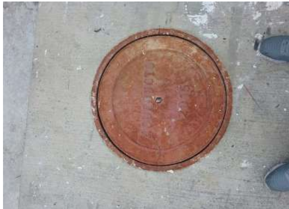
Ilustración 327 Acceso al Tanque subterráneo localizado en el bloque 54
