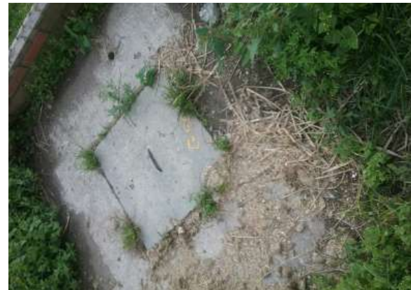
Ilustración 255 Pozos de inspección exteriores Bloque 22 Fuente: Equipo de diagnóstico
