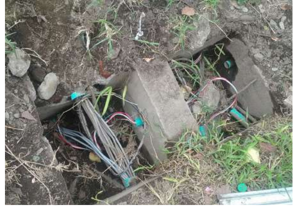
Ilustración 75. Tablero Fuente: Equipo Diagnostico
