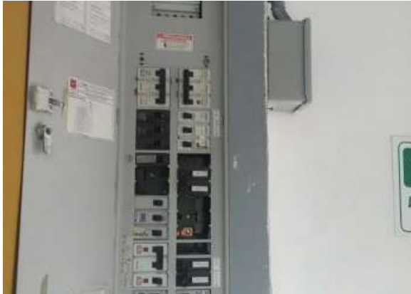
Ilustración 22. Tablero Fuente: Equipo Diagnostico
