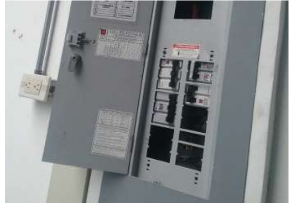
Ilustración 23. Tablero Fuente: Equipo Diagnostico
