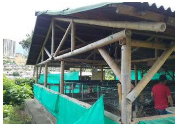
Ilustración 271 Sistema de desagües de aguas lluvias Bloque 32. Fuente: Equipo de diagnóstico
