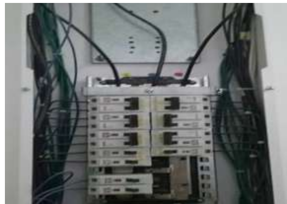
Ilustración 180. Tablero bloque 51. Fuente: Equipo diagnóstico.
