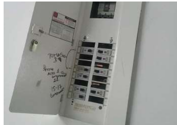
Ilustración 28. Tablero Fuente: Equipo Diagnostico
