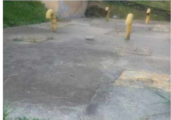
Ilustración 217. Pozo séptico Bloque 1, capacidad 120 m3 Fuente: Equipo de diagnóstico
