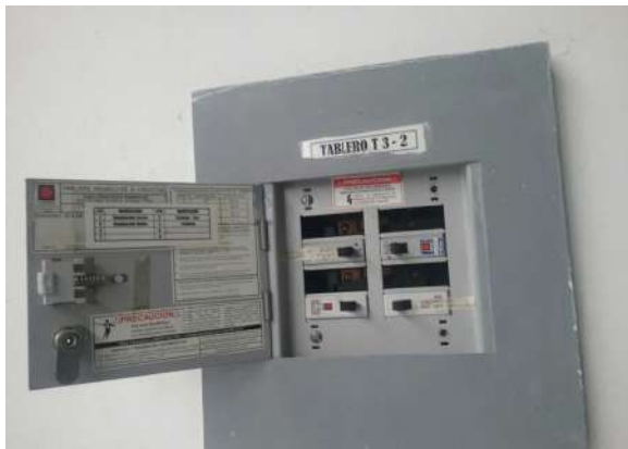
Ilustración 27. Tablero Fuente: Equipo Diagnostico
