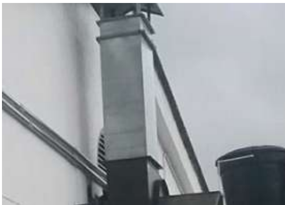
Ilustración 183. Extractor de humo bloque 51. Fuente: Equipo diagnóstico.
