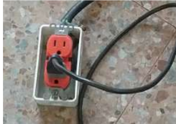
Ilustración 157. Tablero bloque 44. Fuente: Equipo diagnóstico
