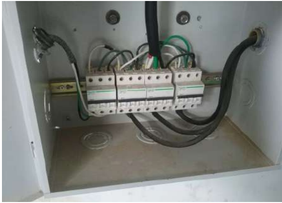
Ilustración 53. Tablero Fuente: Equipo Diagnostico
