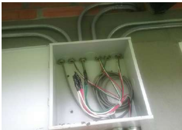
Ilustración 109. Caja de paso bloque 28 Fuente: equipo diagnóstico
