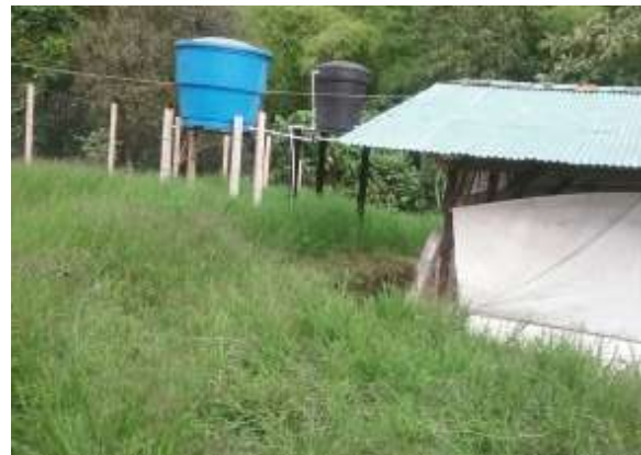
Ilustración 272. Tanque elevado Bloque 33, material plástico, volumen 2 m 3 . Fuente: Equipo de diagnóstico.
