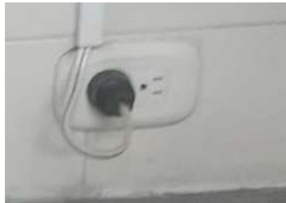
Ilustración 139. Tablero bloque 38 Fuente: Equipo diagnóstico.
