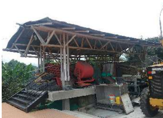
Ilustración 235 Desagües de aguas lluvias cubierta Bloque 11. Fuente: Equipo de diagnóstico
