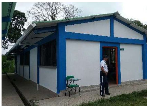
Ilustración 333 Sistema de desagües de aguas lluvias Bloque 55. Fuente: Equipo de diagnóstico
