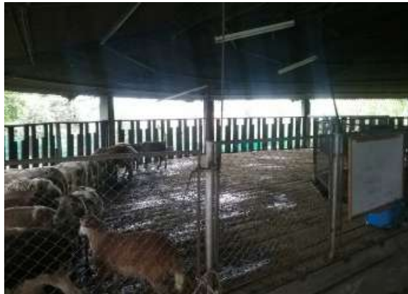
Ilustración 319 Sistema de desagües de aguas lluvias Bloque 50. Fuente: Equipo de diagnóstico
