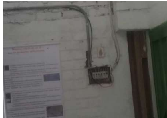
Ilustración 96. Tablero Fuente: Equipo Diagnostico
