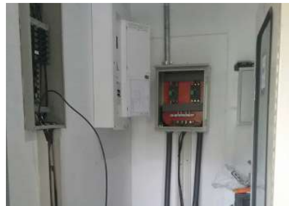
Ilustración 41. Tablero Fuente: Equipo Diagnostico
