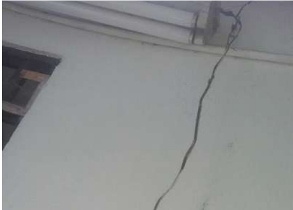
Ilustración 125. Luminarias bloque 34. Fuente: Equipo diagnóstico.
