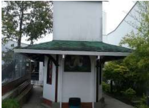
Ilustración 220. Sistema de desagües de aguas lluvias Capilla. Fuente: Equipo de diagnóstico
