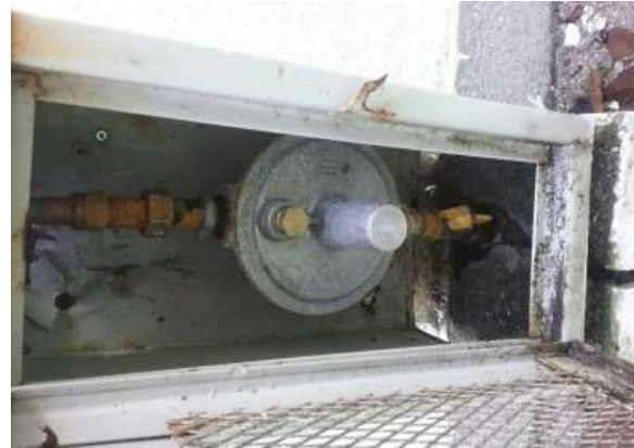
Ilustración 215. Medidores agua potable de ½" localizados en Bloque 34 y Bloque 56 Fuente: Equipo de diagnóstico.
