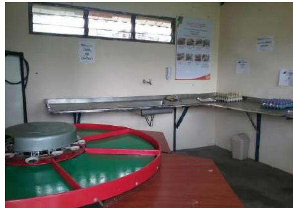
Ilustración 264 Instalaciones en lavaplatos Bloque 28 Fuente: Equipo de diagnóstico
