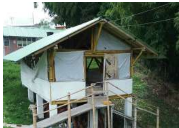
Ilustración 268 Sistema de desagües de aguas lluvias Bloque 29. Fuente: Equipo de diagnóstico
