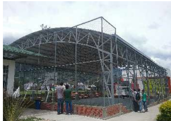
Ilustración 247 Sistema de desagües de aguas lluvias Cancha de microfútbol. Fuente: Equipo de diagnóstico
