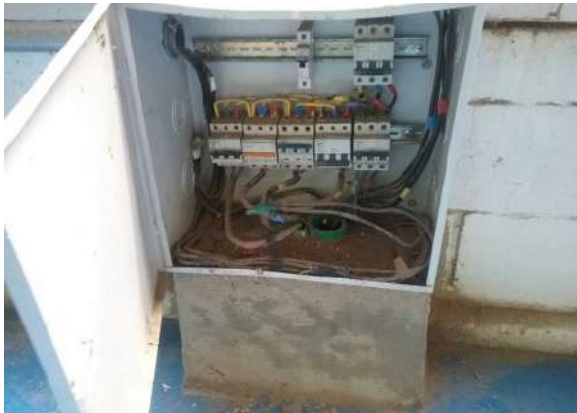
Ilustración 55. Tablero Fuente: Equipo Diagnostico
