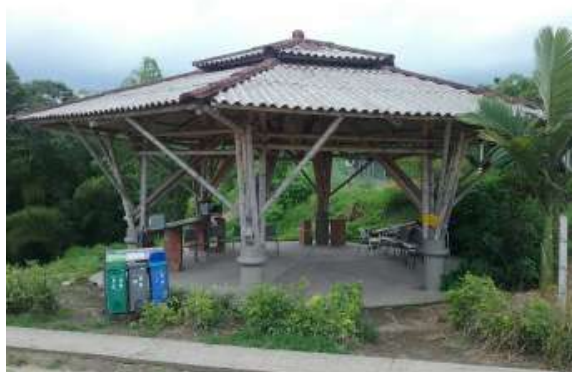
Ilustración 310 Desagües de aguas lluvias cubierta Bloque 46. Fuente: Equipo de diagnóstico
