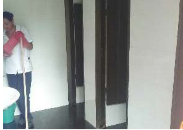
Ilustración 340 Salidas o puntos hidráulicos de conexión Bloque 57 Fuente: Equipo de diagnóstico
