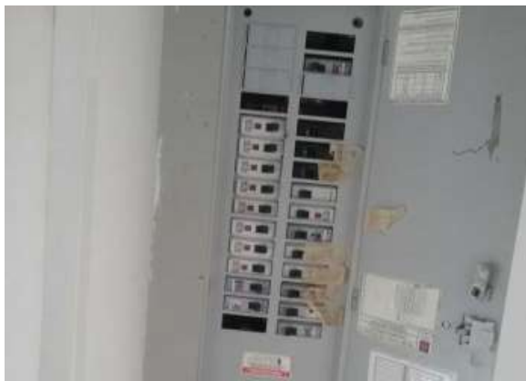
Ilustración 40. Tablero Fuente: Equipo Diagnostico
