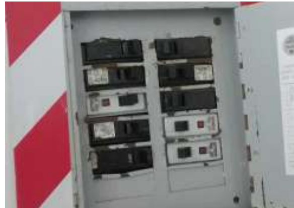
Ilustración 167. Tablero bloque 47. Fuente: Equipo diagnóstico.
