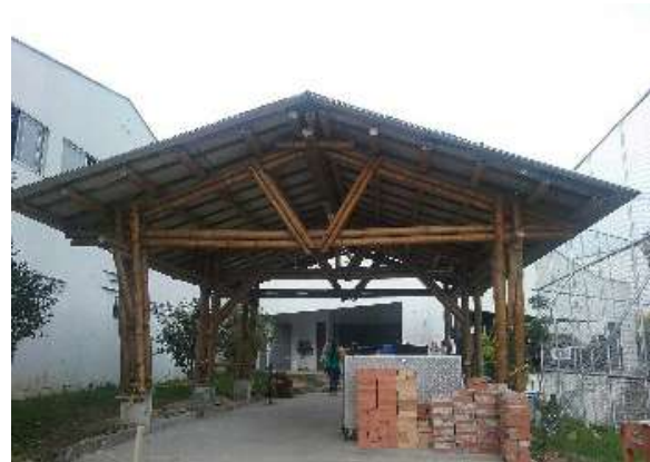
Ilustración 249 Sistema de desagües de aguas lluvias Bloque 18. Fuente: Equipo de diagnóstico
