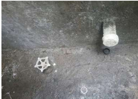
Ilustración 287 Acceso al Tanque subterráneo localizado en el bloque 38
