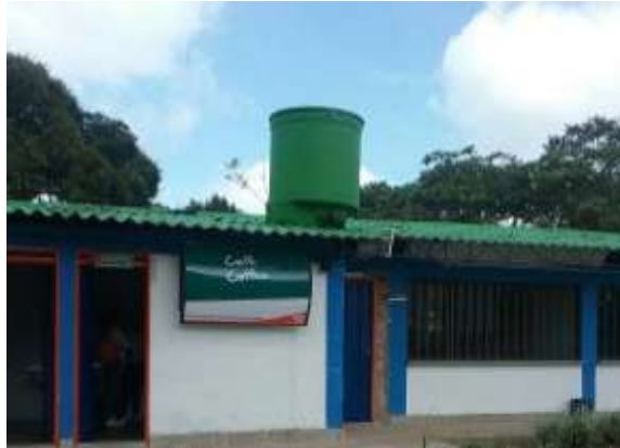
Ilustración 339. Tanques elevados de agua potable Bloque 57, material Asbesto cemento, volumen 1 m 3 . Fuente: Equipo de diagnóstico.
