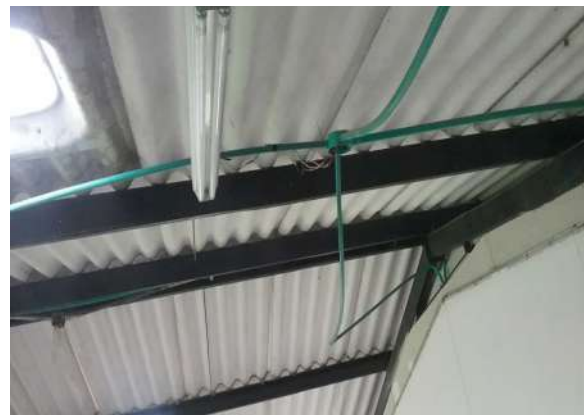
Ilustración 173. Acometida bloque 48. Fuente: Equipo diagnóstico.
