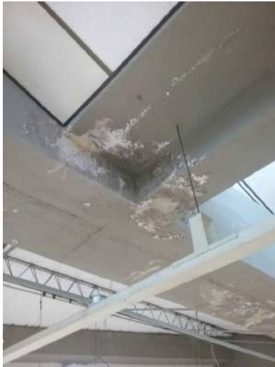
Ilustración 82. Detalle Espacio No. 26. Fuente. Equipo de diagnóstico.
