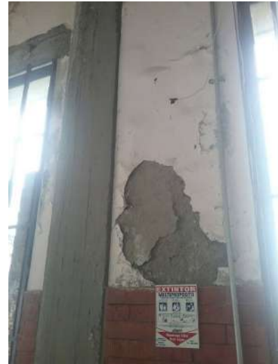
Ilustración 83. Detalle Espacio No. 36. Fuente. Equipo de diagnóstico.
