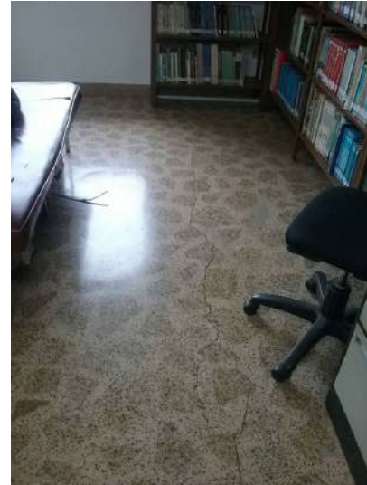
Ilustración 45. Detalle Espacio No. 78. Fuente. Equipo de diagnóstico.
