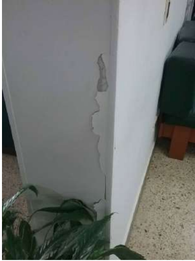
Ilustración 44. Detalle Espacio No. 79. Fuente. Equipo de diagnóstico.
