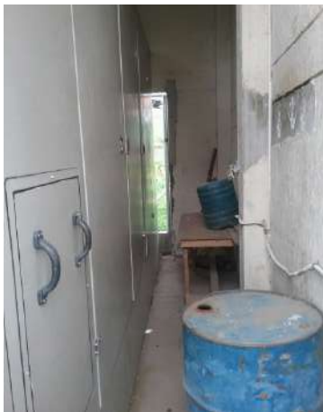
Ilustración 72. Espacio 1. Fuente. Equipo de diagnóstico.
