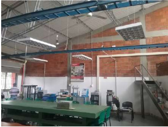
Ilustración 80. Espacio No. 48. Fuente. Equipo de diagnóstico.
