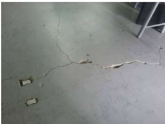
Ilustración 39. Detalle Espacio No. 46. Fuente. Equipo de diagnóstico.
