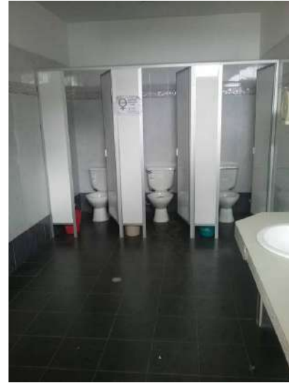
Ilustración 53. Espacio 5. Fuente. Equipo de diagnóstico.
