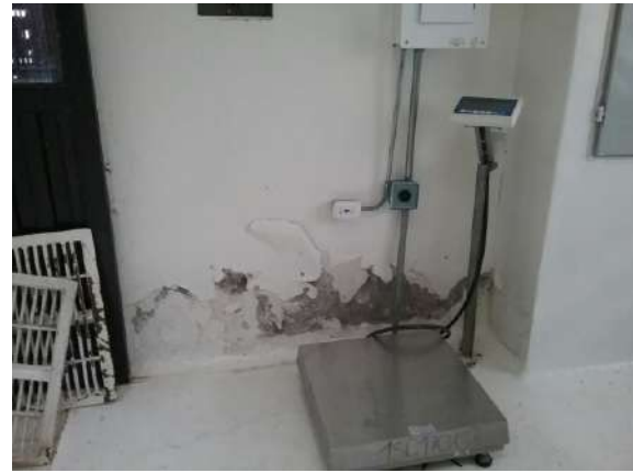
Ilustración 15. Detalle Espacio No. 4. Fuente. Equipo de diagnóstico.
