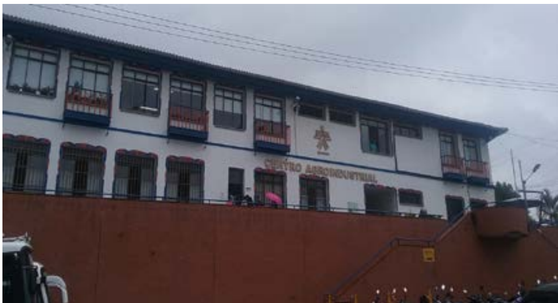
Ilustración 30. Centro agroindustrial Fuente. Equipo de Diagnóstico
