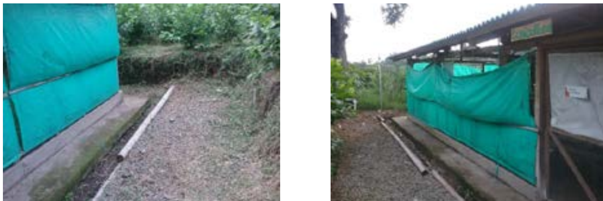
Ilustración 85. Sistema estructural y placa de contrapiso Fuente. Equipo de Diagnóstico
