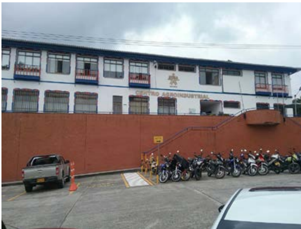
Ilustración 178. Bloque No. 1. Fuente. Equipo de diagnóstico
