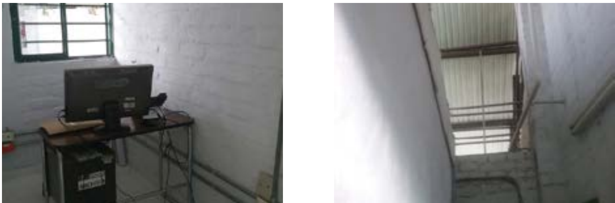
Ilustración 71. Estructura en pórticos de concreto Fuente. Equipo de Diagnóstico
