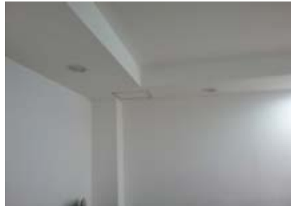
Ilustración 35. Sistema estructural de cubierta Fuente. Estudios de vulnerabilidad fase 2, Sena y Equipo de Diagnóstico
