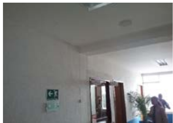
Ilustración 100. Sistema estructural bloque 38 Fuente. Equipo de Diagnóstico
