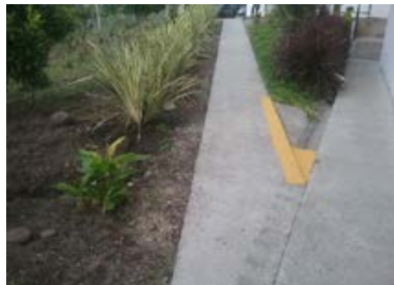
Ilustración 149. Placa de contrapiso y andén perimetral Fuente. Equipo de Diagnóstico
