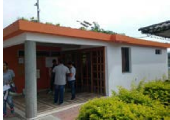
Ilustración 272. Bloque No. 14. Fuente: equipo diagnóstico.
