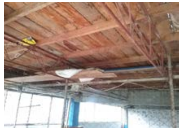
Ilustración 171. Mezzanine en madera soportada sobre cerchas metálicas Fuente. Equipo de Diagnóstico
