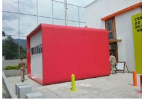
Ilustración 276. Bloque No. 15. Fuente: equipo diagnóstico.
