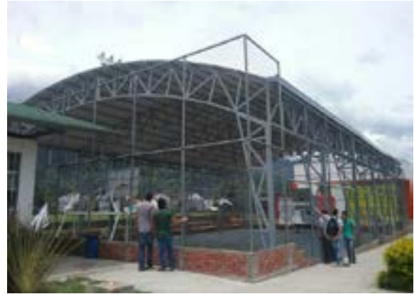
Ilustración 286. Bloque No. 16. Fuente: equipo diagnóstico.
