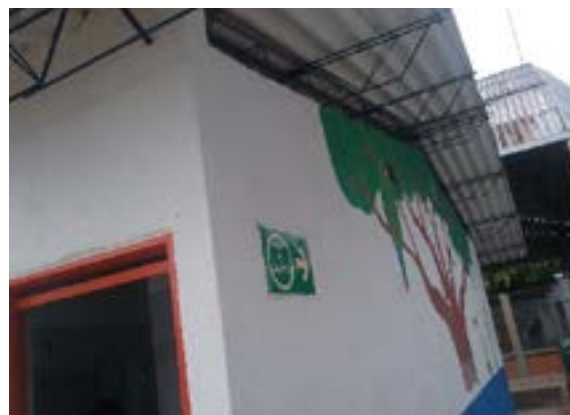
Ilustración 110. Sistema estructural de cubierta Fuente. Equipo de Diagnóstico
