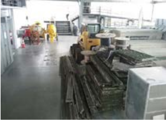
Ilustración 239. Espacio No. 3. Fuente: equipo diagnóstico.
