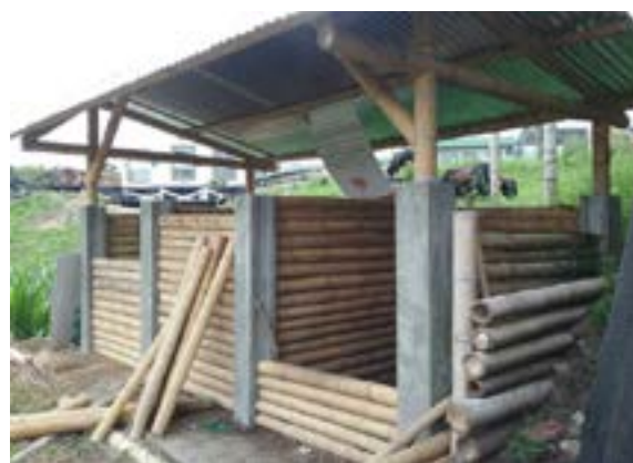
Ilustración 332. Bloque No. 26. Fuente: equipo diagnóstico.
