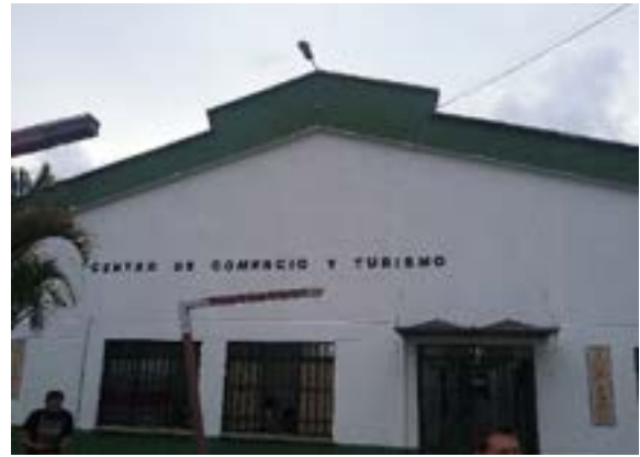
Ilustración 140. Sistema estructural bloque 47 Fuente. Equipo de Diagnóstico
