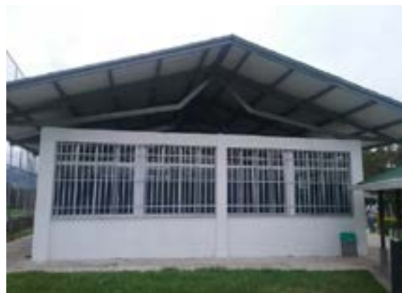
Ilustración 264. Bloque No. 12. Fuente: equipo diagnóstico.
