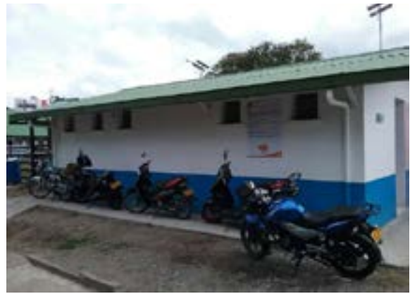
Ilustración 302. Bloque No. 21. Fuente: equipo diagnóstico.
