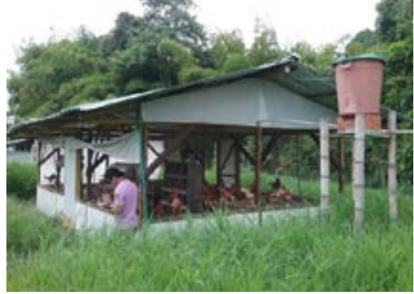
Ilustración 351. Bloque No. 31. Fuente: equipo diagnóstico.
