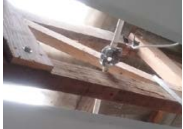
Ilustración 103. Sistema estructural de cubierta, cercha en madera Fuente. Equipo de Diagnóstico
