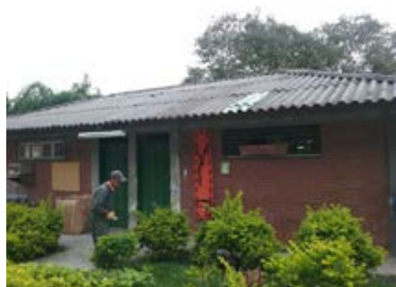
Ilustración 268. Bloque No. 13. Fuente: equipo diagnóstico.
