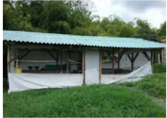
Ilustración 347. Bloque No. 30. Fuente: equipo diagnóstico.
