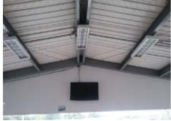
Ilustración 45. Sistema estructural de cubierta Fuente. Equipo de Diagnóstico
