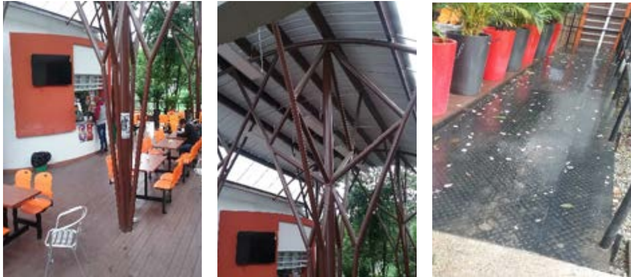
Ilustración 133. Estructura metálica en zona exterior Fuente. Equipo de Diagnóstico
