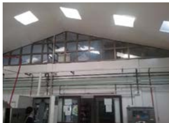
Ilustración 92. Mezzanine dentro del bloque 34 Fuente. Equipo de Diagnóstico
