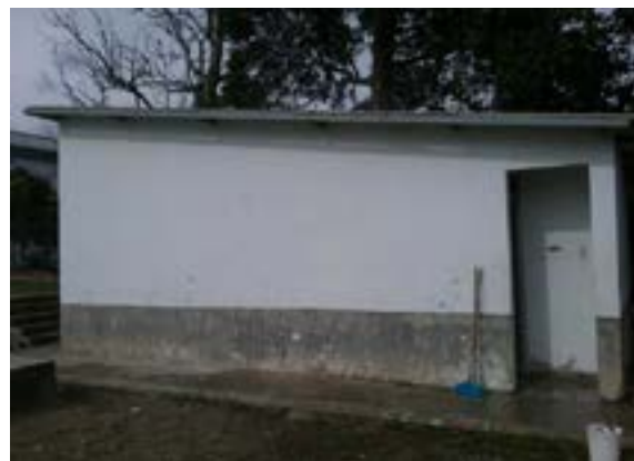
Ilustración 290. Bloque No. 17. Fuente: equipo diagnóstico.
