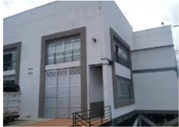
Ilustración 246. Bloque No. 10. Fuente: equipo diagnóstico.
