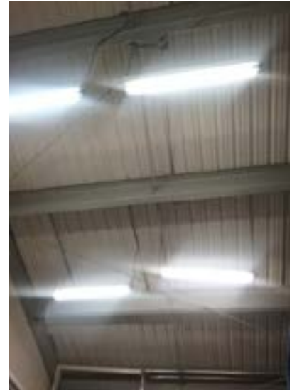
Ilustración 47. Sistema estructural de cubierta Fuente. Equipo de Diagnóstico
