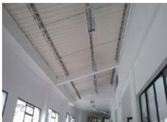
Ilustración 131. Sistema estructural de cubierta Fuente. Equipo de Diagnóstico
