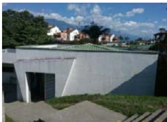
Ilustración 194. Bloque No. 2. Fuente: equipo diagnóstico.
