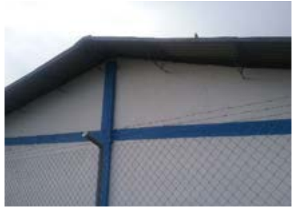
Ilustración 76. Sistema estructural bloque 25 Fuente. Equipo de Diagnóstico
