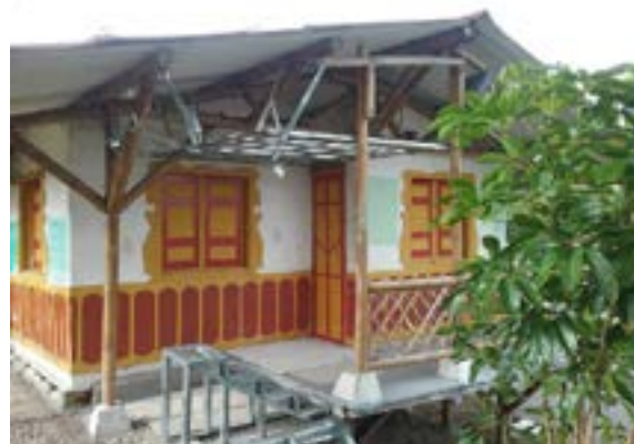
Ilustración 199. Bloque No. 3. Fuente. Equipo de diagnóstico.
