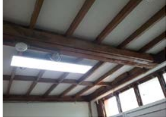
Ilustración 63. mezzanine dentro del bloque 15 Fuente. Equipo de Diagnóstico
