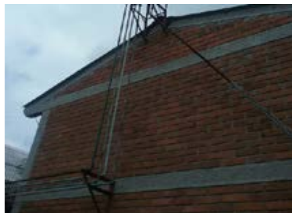
Ilustración 95. Sistema estructural bloque 35 Fuente. Equipo de Diagnóstico
