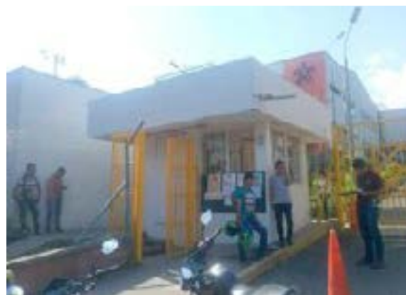
Ilustración 190. Bloque No. 1. Fuente: Equipo de diagnóstico.
