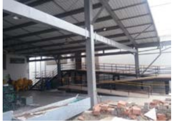
Ilustración 49. Sistema estructural metálico bloque 9 Fuente. Equipo de Diagnóstico
