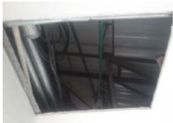
Ilustración 147. Sistema estructural de cubierta Fuente. Equipo de Diagnóstico
