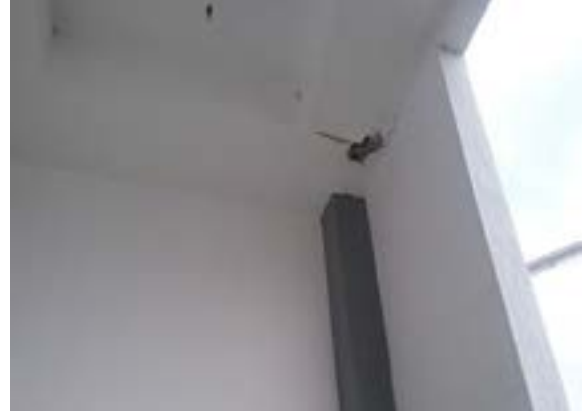
Ilustración 46. Sistema estructural bloque 8 Fuente. Equipo de Diagnóstico
