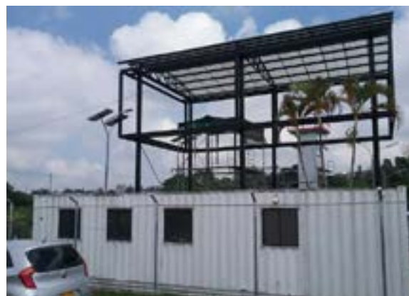
Ilustración 175. Sistema estructural bloque 61 Fuente. Equipo de Diagnóstico
