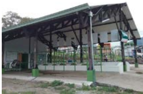
Ilustración 307. Bloque No. 22. Fuente: equipo diagnóstico.
