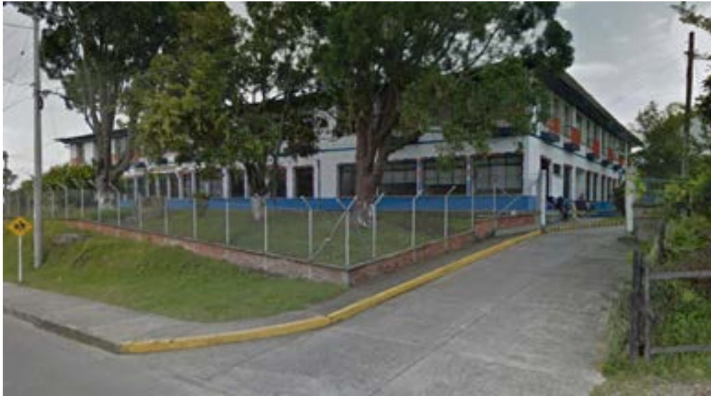
Ilustración 186. Acceso vehicular del Centro Agroindustrial. Fuente. Equipo de diagnóstico
