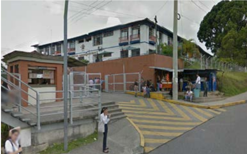
Ilustración 182. Acceso Centro Agroindustrial. Fuente. Equipo de diagnóstico
