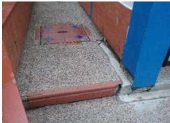
Ilustración 115. Zona exterior bloque 41 Fuente. Equipo de Diagnóstico
