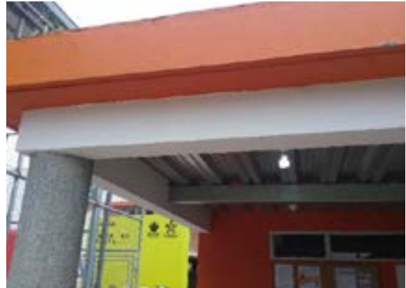
Ilustración 59. Sistema estructural bloque 14 Fuente. Equipo de Diagnóstico
