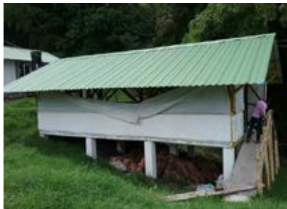
Ilustración 343. Bloque No. 29. Fuente: equipo diagnóstico.
