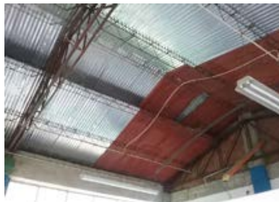
Ilustración 172. Sistema estructural de cubierta Fuente. Equipo de Diagnóstico
