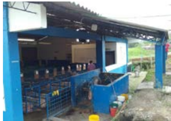
Ilustración 327. Bloque No. 25. Fuente: equipo diagnóstico.
