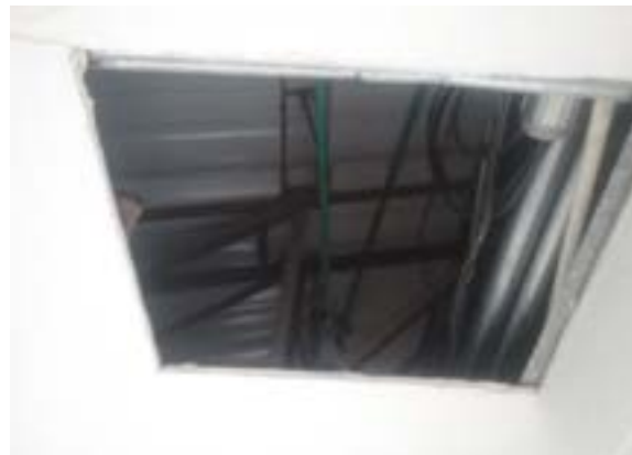
Ilustración 174. Sistema estructural de cubierta Fuente. Equipo de Diagnóstico
