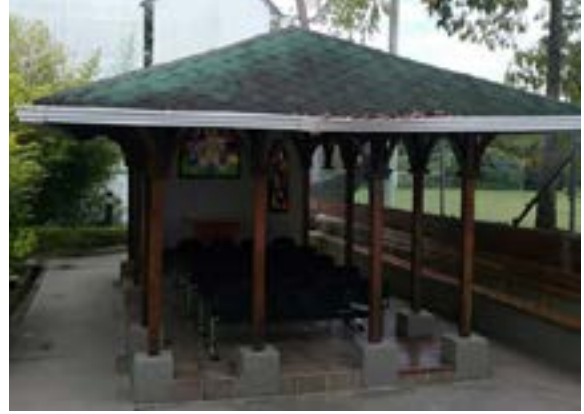
Ilustración 217. Bloque No. 5. Fuente: equipo diagnóstico.
