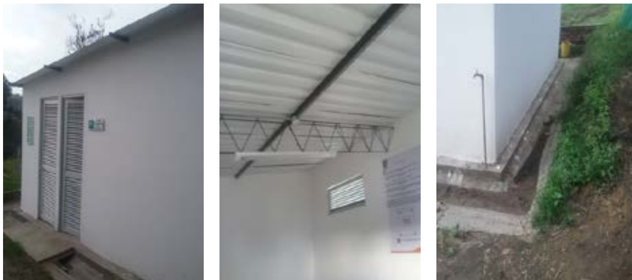
Ilustración 73. Sistema estructural bloque 23 Fuente. Equipo de Diagnóstico
