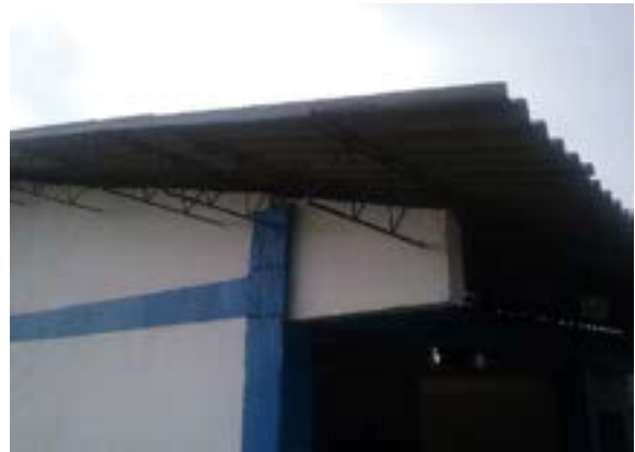
Ilustración 77. Sistema estructural de cubierta Fuente. Equipo de Diagnóstico
