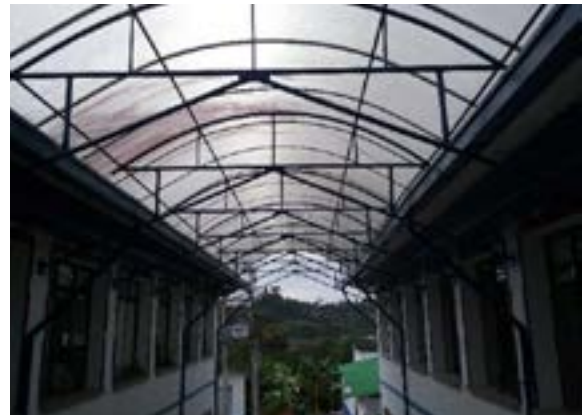
Ilustración 104. Sistema estructural en zona exterior Fuente. Equipo de Diagnóstico
