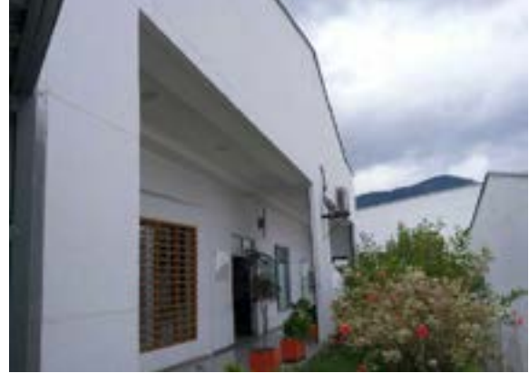
Ilustración 233. Bloque No. 8. Fuente: equipo diagnóstico.
