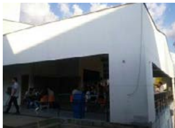
Ilustración 229. Bloque No. 7. Fuente: equipo diagnóstico.
