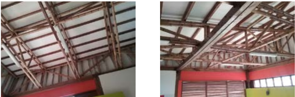
Ilustración 62. Cercha en guadua Fuente. Equipo de Diagnóstico
