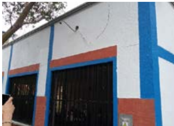
Ilustración 116. Sistema estructural bloque 42 Fuente. Equipo de Diagnóstico
