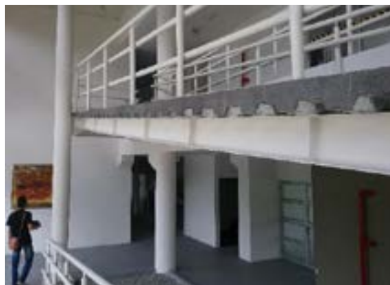
Ilustración 155. Rampa bloque 54 Fuente. Equipo de Diagnóstico
