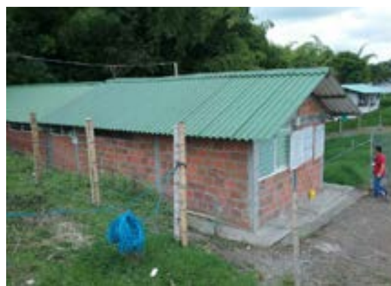
Ilustración 335. Bloque No. 28. Fuente: equipo diagnóstico.
