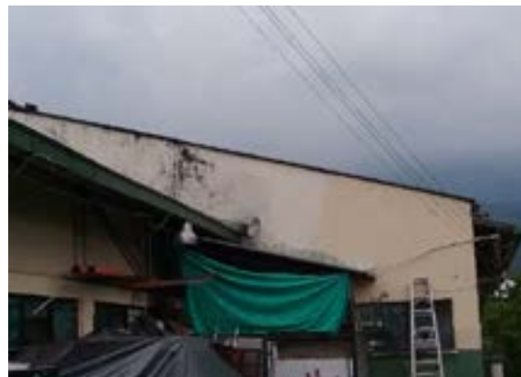
Ilustración 142. Sistema estructural de cubierta Fuente. Equipo de Diagnóstico
