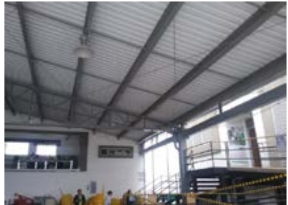
Ilustración 50. Sistema estructural de cubierta Fuente. Equipo de Diagnóstico
