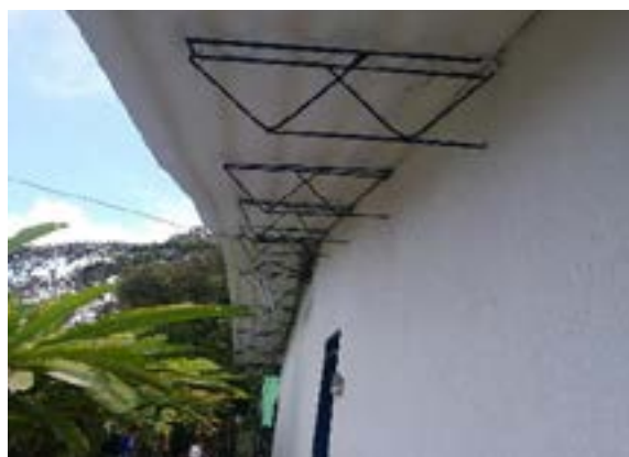
Ilustración 164. Sistema estructural de cubierta y teja Fuente. Equipo de Diagnóstico
