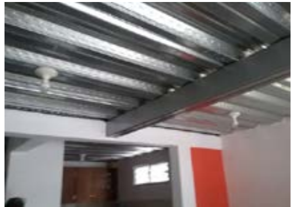
Ilustración 60. Sistema estructural de cubierta Fuente. Equipo de Diagnóstico
