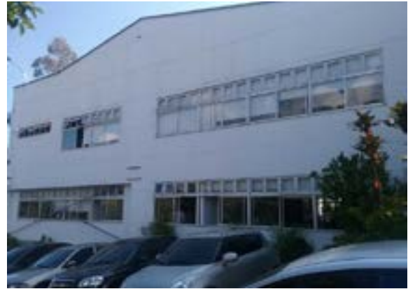
Ilustración 205. Bloque No. 4. Fuente: Equipo de diagnóstico.
