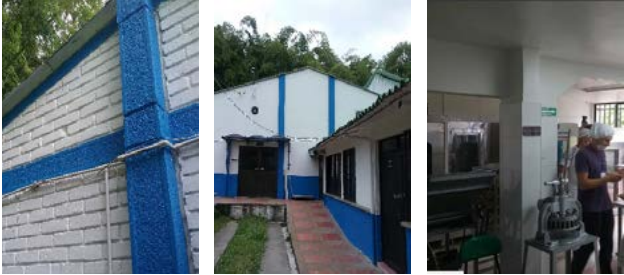
Ilustración 88. Sistema estructural bloque 34 Fuente. Equipo de Diagnóstico
