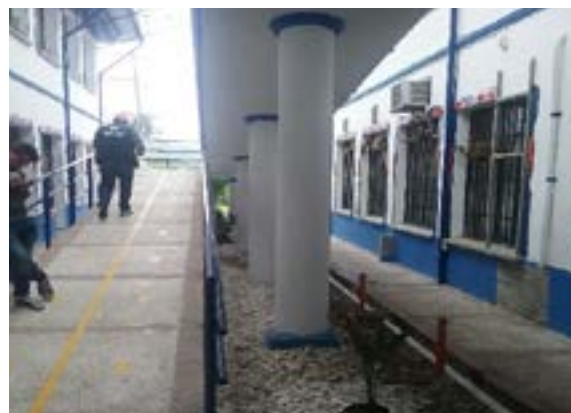
Ilustración 102. Rampa Bloque 38 Fuente. Equipo de Diagnóstico
