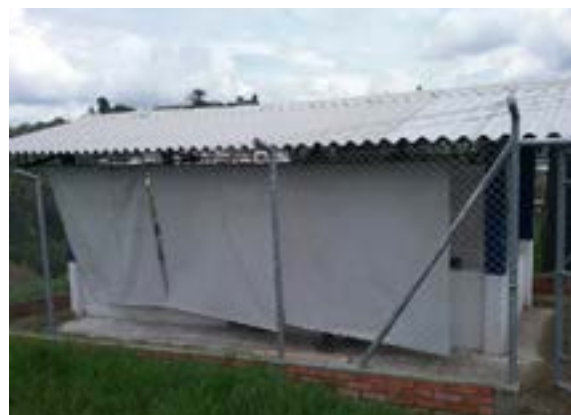
Ilustración 311. Bloque No. 27. Fuente: equipo diagnóstico.
