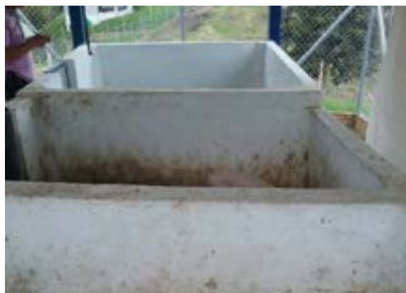
Ilustración 310. Espacio No. 1. Fuente: equipo diagnóstico.
