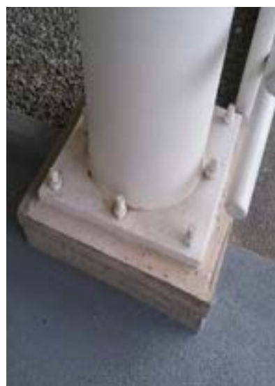
Ilustración 156. Sistema estructural de cubierta Fuente. Equipo de Diagnóstico
