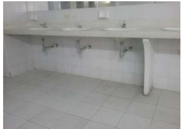
Ilustración 394 Sifón de lavamanos en PVC de 2". Fuente: equipo de diagnóstico.
