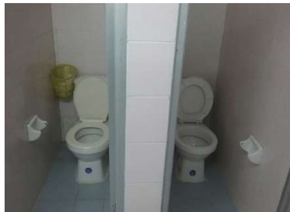
Ilustración 400 Retrete tipo tanque. Fuente: equipo de diagnóstico.
