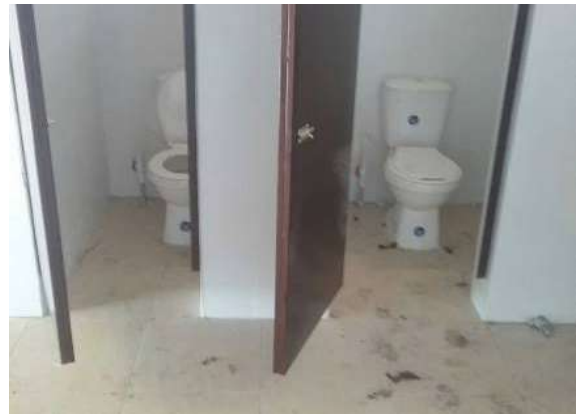
Ilustración 484 Retrete tipo tanque. Fuente: equipo de diagnóstico.
