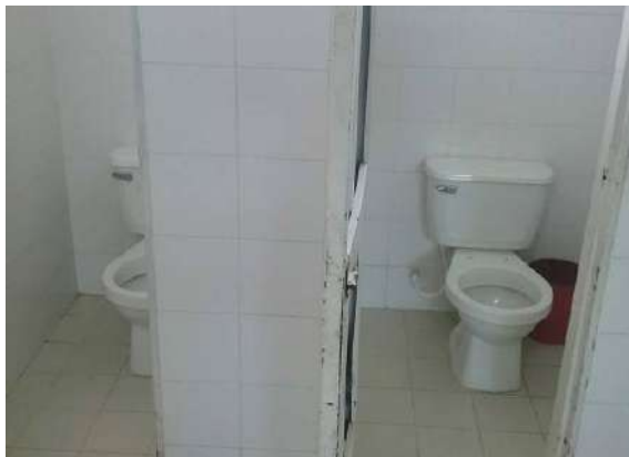
Ilustración 420 Retrete tipo tanque. Fuente: equipo de diagnóstico.
