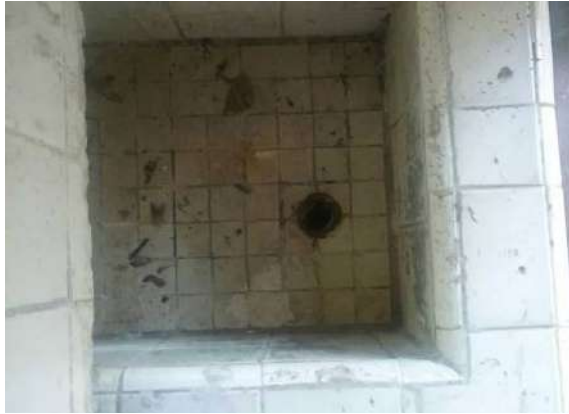
Ilustración 374 Sifón de piso en 2" sin rejilla. Fuente: equipo de diagnóstico.
