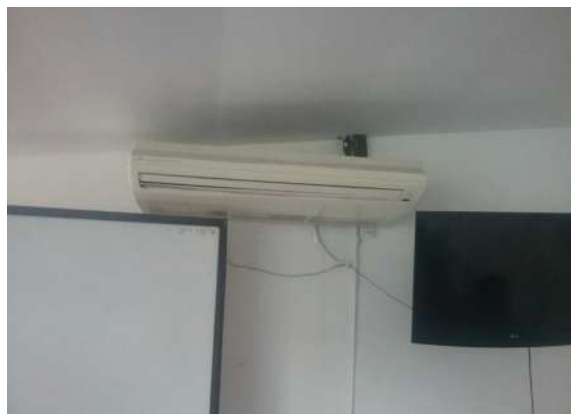
Ilustración 173. Mini Split. Fuente: Equipo diagnóstico
