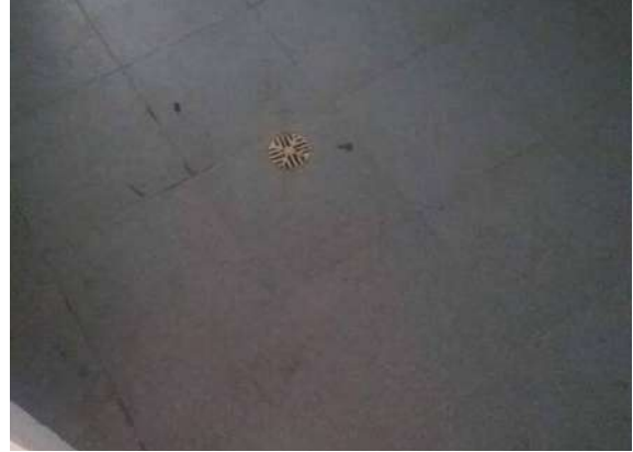
Ilustración 351 Sifón de piso plástico de 2". Fuente: equipo de diagnóstico.
