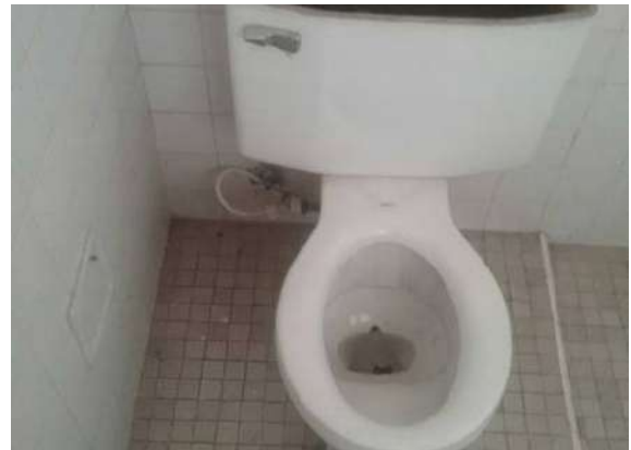
Ilustración 371 Retrete tipo tanque. Fuente: equipo de diagnóstico.
