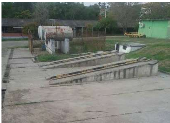
Ilustración 164. Sin instalaciones eléctricas. Fuente: Equipo diagnóstico
