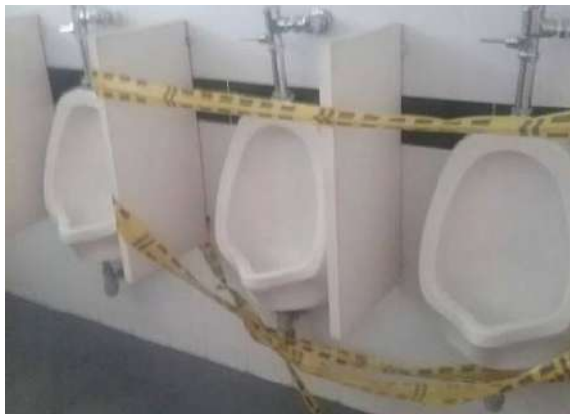
Ilustración 345 Orinales tipo push. Fuente: equipo de diagnóstico.
