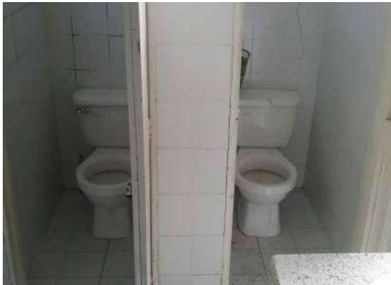
Ilustración 457 Retrete tipo tanque. Fuente. Equipo de diagnóstico.
