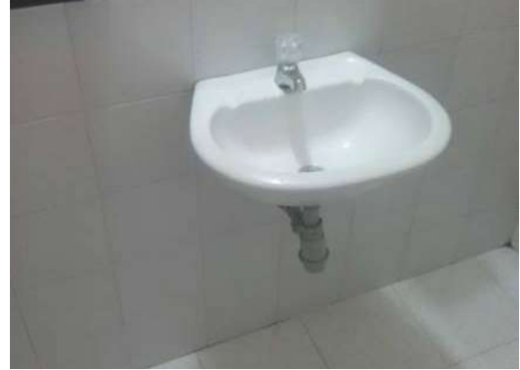
Ilustración 414 Sifón de lavamanos en PVC de 2". Fuente: equipo de diagnóstico.
