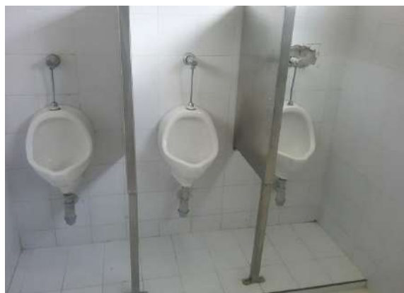
Ilustración 435 Orinal tipo push. Fuente: equipo de diagnóstico.
