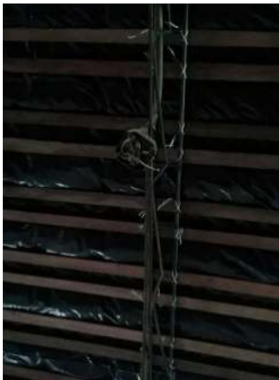
Ilustración 243. Luminarias. Fuente: Equipo diagnóstico.
