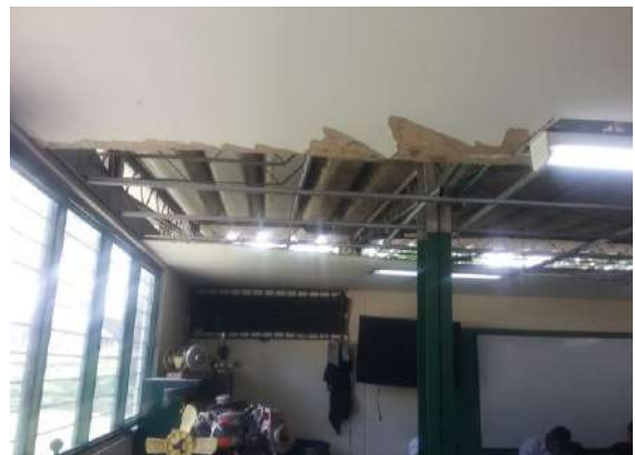
Ilustración 187. Luminarias. Fuente: Equipo diagnóstico
