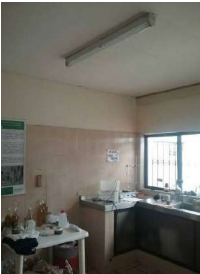
Ilustración 41. Tomacorriente. Fuente: equipo de diagnóstico.
