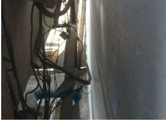
Ilustración 188. Tablero. Fuente: Equipo diagnostico
