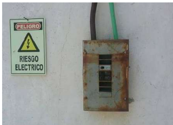
Ilustración 238. Tablero. Fuente: Equipo diagnostico
