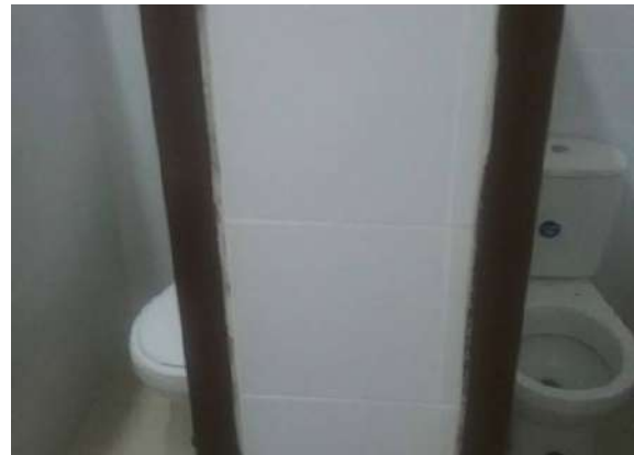
Ilustración 467 Retrete tipo tanque. Fuente: equipo de diagnóstico.
