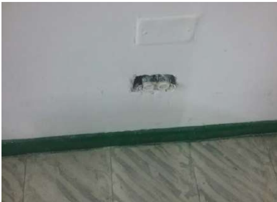
Ilustración 231. Tablero. Fuente: Equipo diagnóstico
