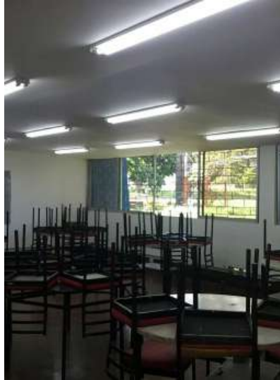
Ilustración 93. Elementos deshabilitados. Fuente: equipo de diagnóstico.
