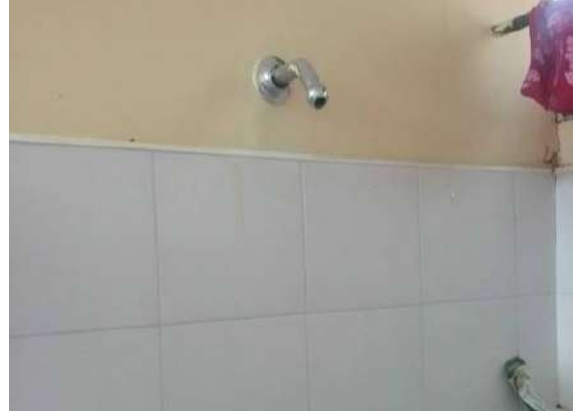
Ilustración 411 Ducha tipo llave. Fuente: equipo de diagnóstico.
