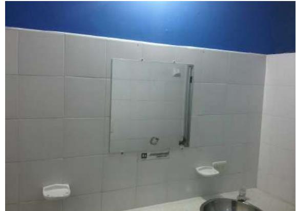
Ilustración 119. Tomacorriente. Fuente: equipo de diagnóstico.
