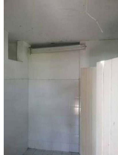
Ilustración 206. Luminarias. Fuente: Equipo diagnóstico.
