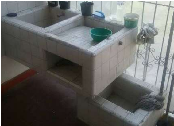
Ilustración 363 Lavadero enchapado. Fuente: equipo de diagnóstico.
