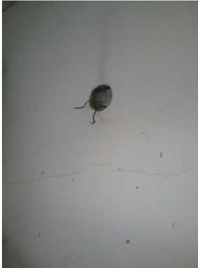
Ilustración 50. Salida para iluminación. Fuente: equipo de diagnóstico.
