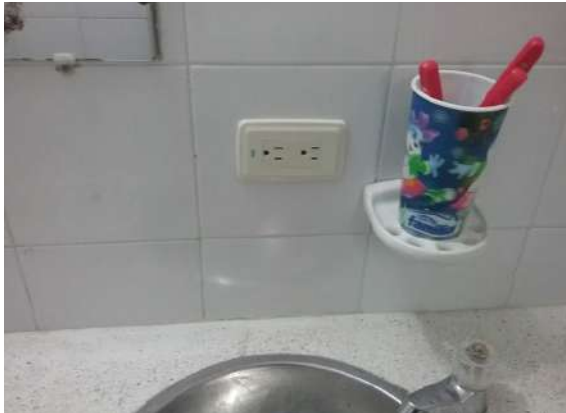
Ilustración 118. Tomacorriente. Fuente: equipo de diagnóstico.
