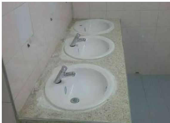
Ilustración 399 Lavamanos tipo push. Fuente: equipo de diagnóstico
