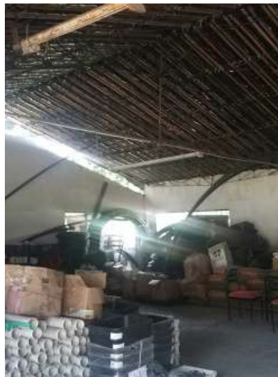
Ilustración 244. Luminarias. Fuente: Equipo diagnóstico.
