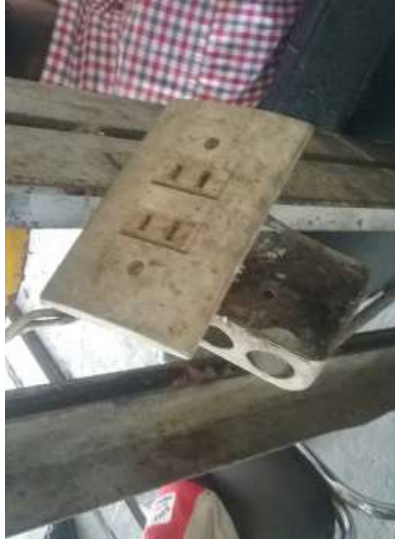
Ilustración 193. Tomacorriente. Fuente: Equipo diagnóstico
