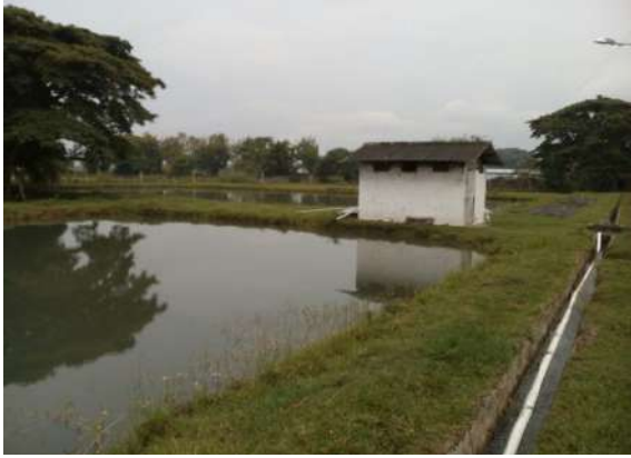
Ilustración 529. Tubería 2". Fuente: equipo de diagnóstico.
