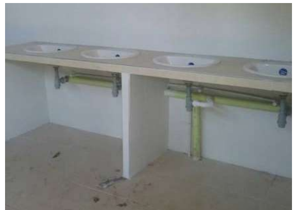
Ilustración 487 Sifón de lavamanos en PVC de 2". Fuente: equipo de diagnóstico.
