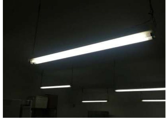
Ilustración 259. Luminarias. Fuente: Equipo diagnóstico
