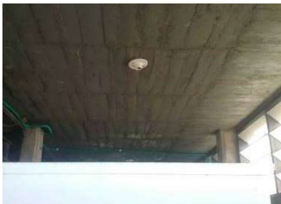
Ilustración 208. Luminarias. Fuente: Equipo diagnóstico.
