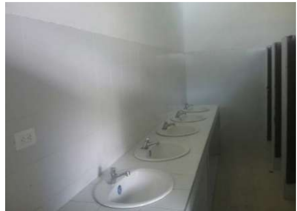
Ilustración 216. Tomacorriente. Fuente:Equipo diagnostico
