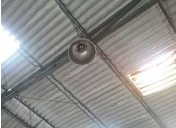
Ilustración 150. Iluminación (Lama para no instalada). Fuente: equipo de diagnóstico.
