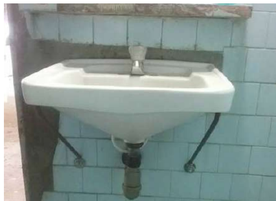
Ilustración 455 Sifón de lavamanos en PVC de 2". Fuente: equipo de diagnóstico.
