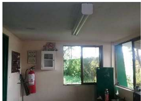
Ilustración 327. Bloque 70. Iluminación. Fuente: equipo de diagnóstico.
