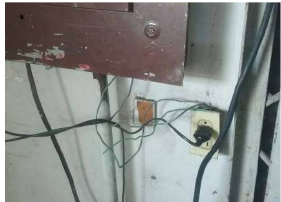
Ilustración 191. Tubería. Fuente: Equipo diagnostico
