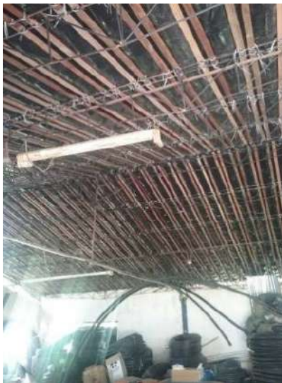
Ilustración 242. Luminarias. Fuente: Equipo diagnóstico.
