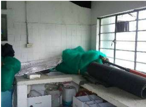
Ilustración 277. Tomacorriente bloque 50. Fuente: equipo de diagnóstico.
