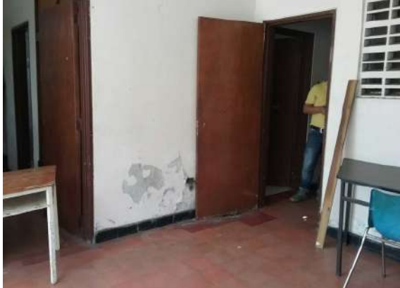
Ilustración 64. Salida para tomacorriente. Fuente: equipo de diagnóstico.
