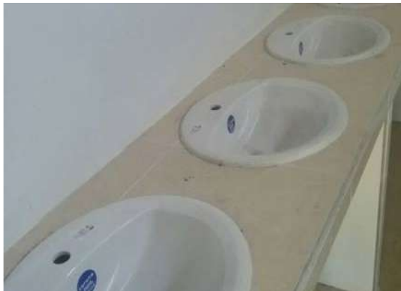
Ilustración 483 Lavamanos en instalación. Fuente: equipo de diagnóstico.
