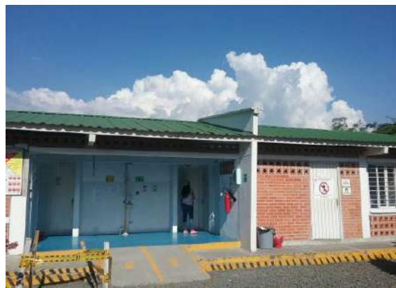
Ilustración 264. Tablero. Equipo diagnóstico
