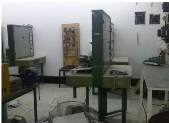
Ilustración 223. Tablero. Fuente equipo diagnóstico.
