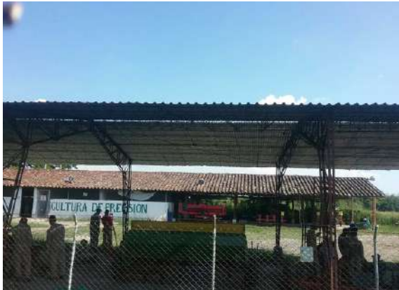
Ilustración 198. Tablero. Fuente:Equipo diagnóstico.
