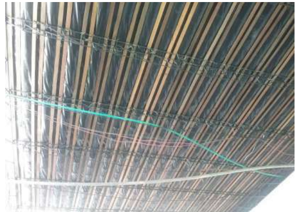
Ilustración 251. Luminarias. Fuente: Equipo diagnóstico.
