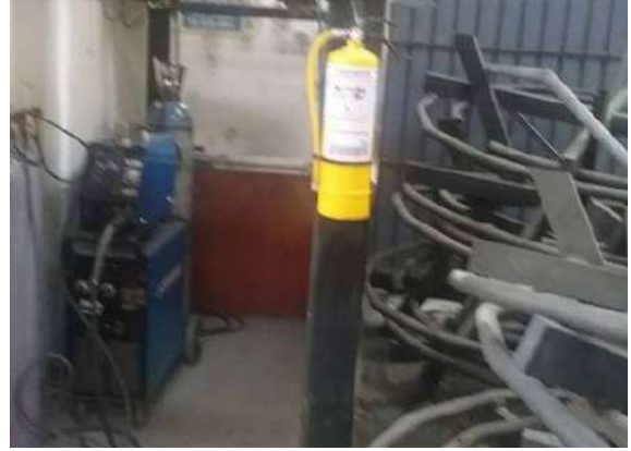
Ilustración 432 Extintor tipo multipropósito. Fuente: equipo de diagnóstico.
