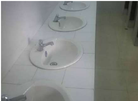
Ilustración 466 Lavamanos tipo push. Fuente: equipo de diagnóstico.
