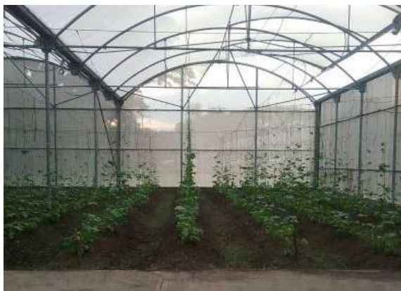
Ilustración 210. Invernadero sin instalaciones eléctricas. Fuente: Equipo diagnóstico.
