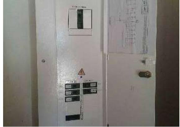
Ilustración 276. Tablero bloque 50. Fuente: equipo de diagnóstico.
