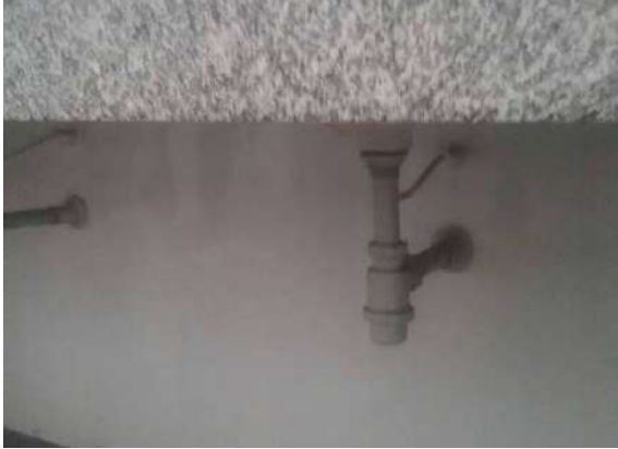
Ilustración 350 Sifón de lavamanos en PVC de 2". Fuente: equipo de diagnóstico.
