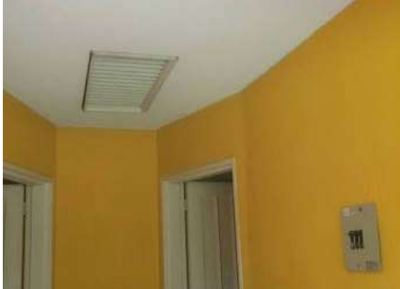
Ilustración 123. Tablero de distribución. Fuente: equipo de diagnóstico.
