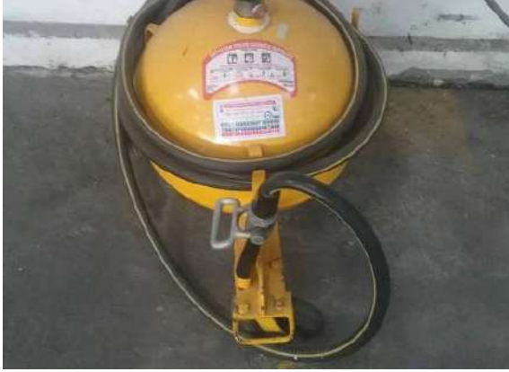
Ilustración 431 Extintor tipo multipropósito. Fuente: equipo de diagnóstico.
