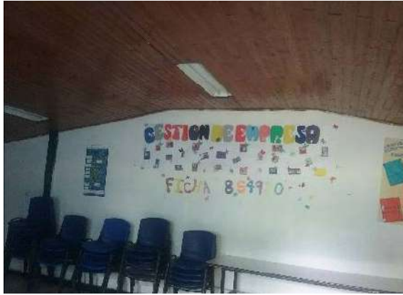
Ilustración 306. Iluminación. Bloque 63. Fuente: equipo de diagnóstico.
