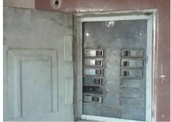
Ilustración 189. Tablero. Fuente: Equipo diagnostico
