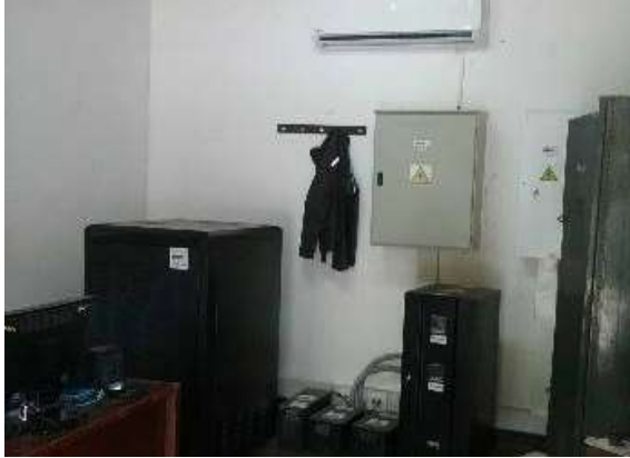
Ilustración 275. Tablero bloque 50. Fuente: equipo de diagnóstico.
