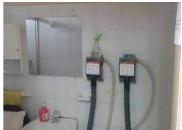
Ilustración 126. Tomacorriente. Fuente: equipo de diagnóstico
