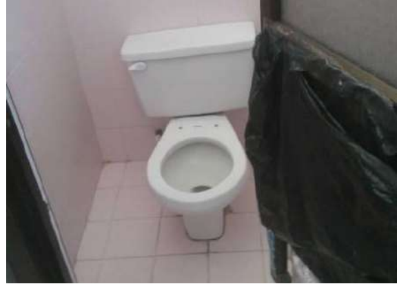
Ilustración 355 Retrete tipo tanque. Fuente: equipo de diagnóstico.
