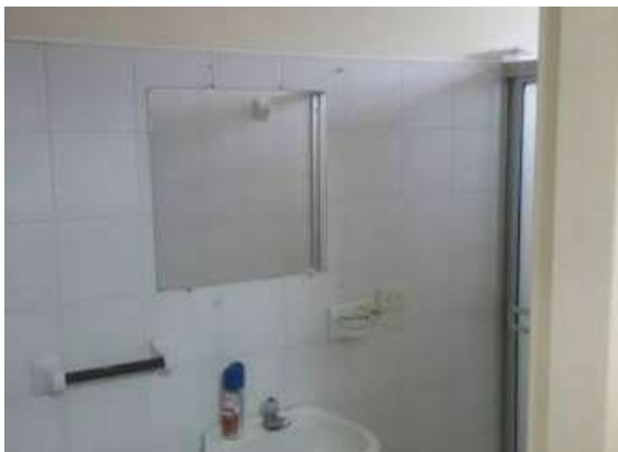
Ilustración 125. Tomacorriente. Fuente: equipo de diagnóstico
