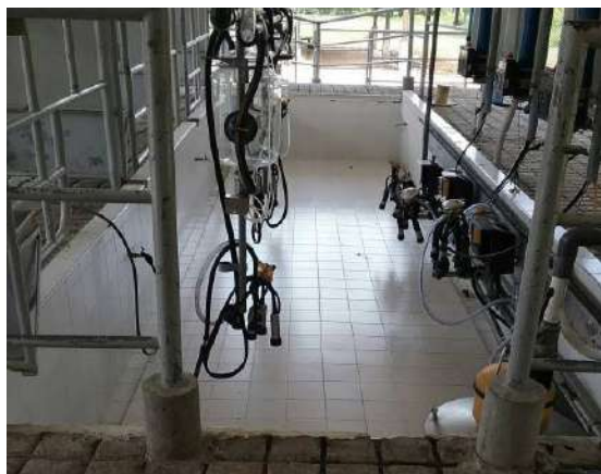
Ilustración 345. Espacio No. 1. Fuente. Equipo de diagnóstico.
