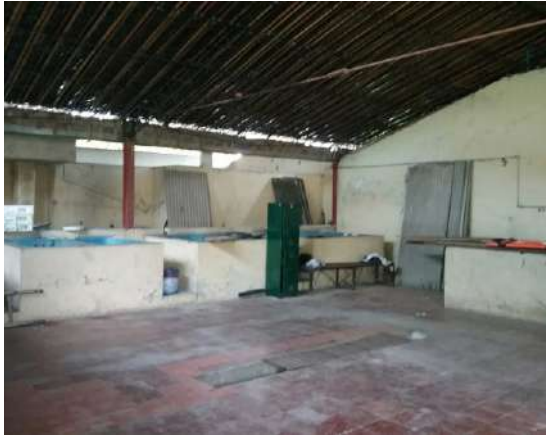
Ilustración 268. Espacio 1. Fuente. Equipo de diagnóstico.
