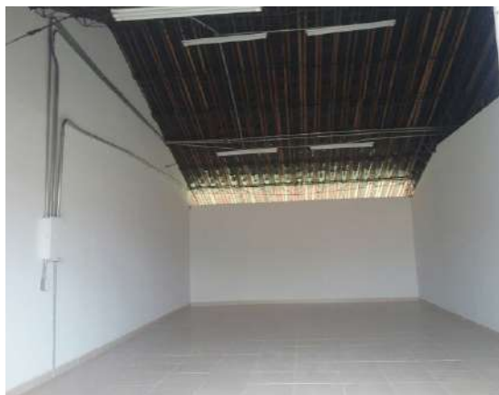
Ilustración 319. Espacio 1. Fuente: Equipo de diagnóstico.
