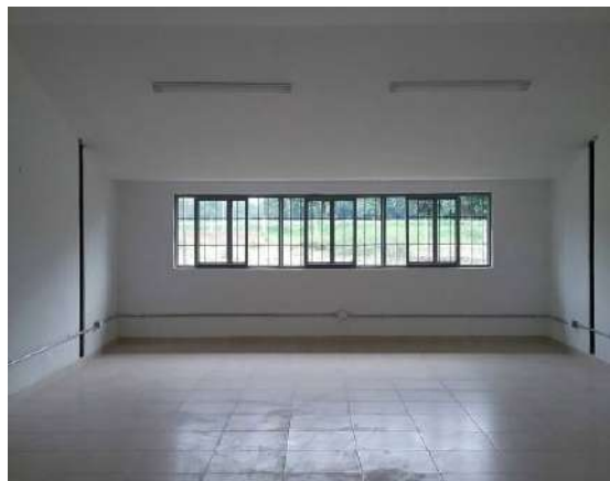
Ilustración 325. Espacio No. 7. Fuente. Equipo de diagnóstico.
