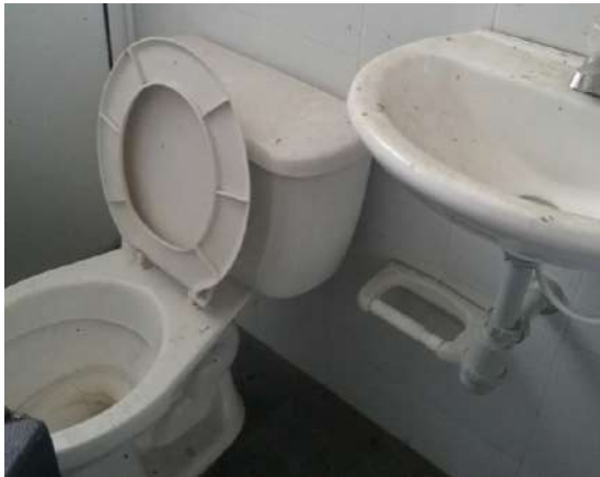
Ilustración 23. Espacio N° 14. Fuente: Equipo de diagnóstico.
