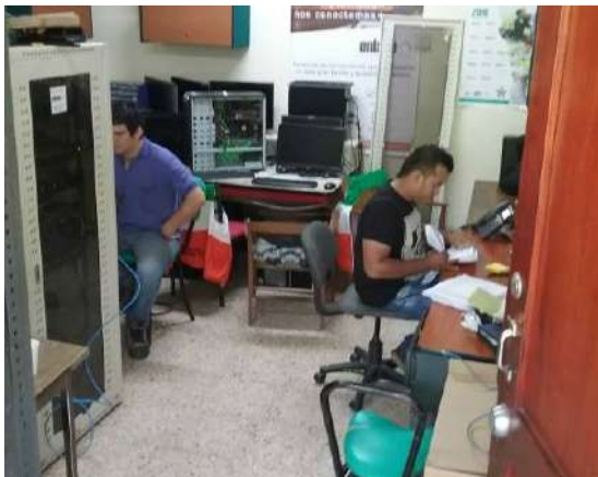
Ilustración 15. Espacio No.24. Fuente. Equipo de diagnóstico.
