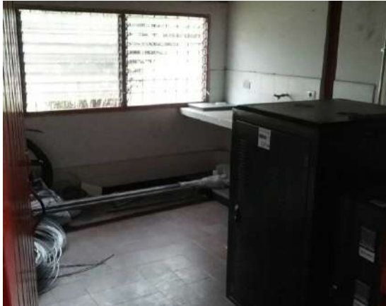
Ilustración 383. Espacio 6. Fuente. Equipo de diagnóstico.
