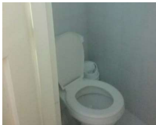
Ilustración 126. Espacio 30. Fuente: Equipo diagnóstico.
