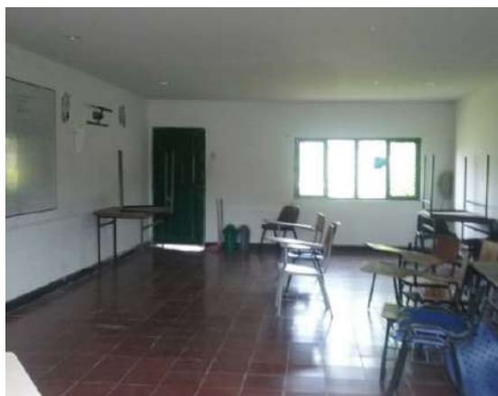
Ilustración 278. Espacio 2. Fuente: Equipo de diagnóstico.
