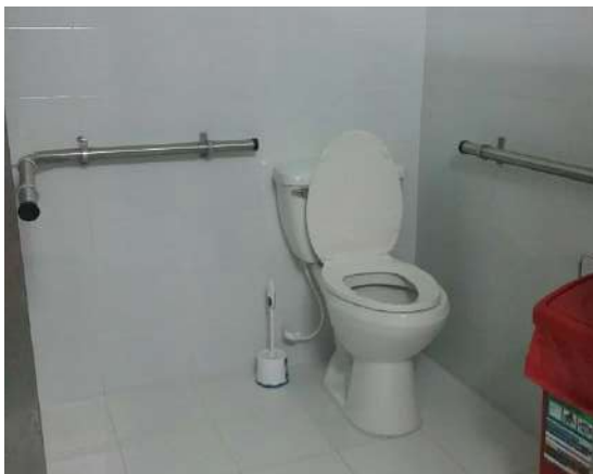
Ilustración 140. Espacio 7. Fuente: Equipo de diagnóstico.
