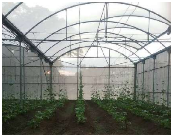
Ilustración 228. Espacio No.1. Fuente: Equipo de diagnóstico.
