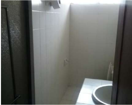
Ilustración 56. Espacio N° 5. Fuente. Equipo de diagnóstico.
