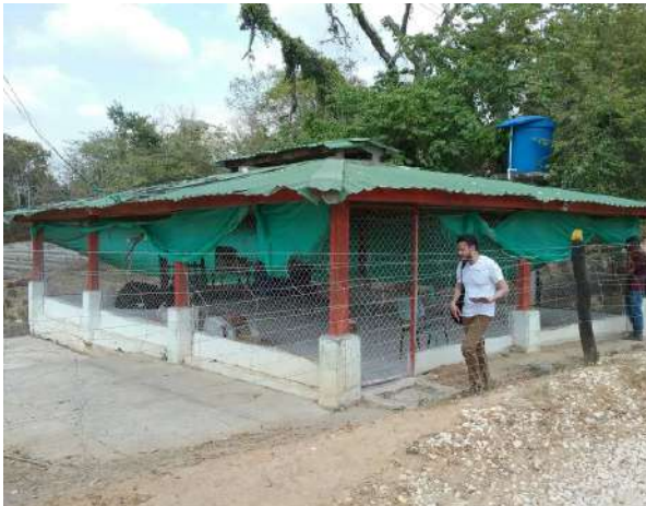
Ilustración 314. Fachada Bloque 21. Fuente: Equipo Diagnóstico
