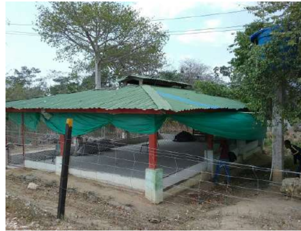
Ilustración 313. Fachada Bloque 21. Fuente: Equipo Diagnóstico
