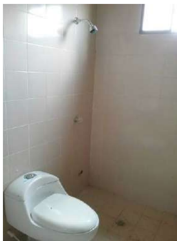
Ilustración 267. Espacio 10. Fuente: Equipo Diagnostico
