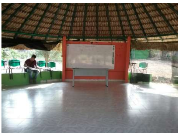
Ilustración 249. Espacio 1-Bloque 11. Fuente: Equipo Diagnóstico
