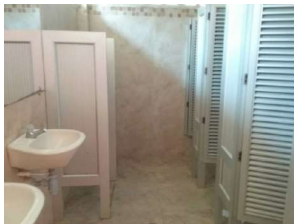
Ilustración 221. Espacio 4. Fuente: Equipo Diagnostico
