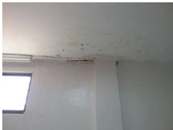
Ilustración 275. Espacio 4. Fuente: Equipo Diagnostico
