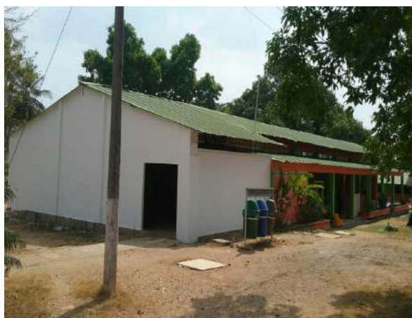
Ilustración 217. Fachada Bloque 4. Fuente: Equipo Diagnóstico
