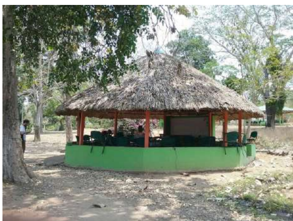
Ilustración 243. Fachada Bloque 13. Fuente: Equipo Diagnostico
