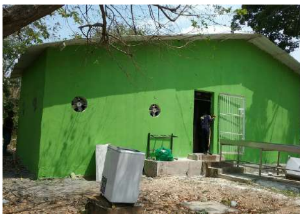
Ilustración 305. Fachada Bloque 15. Fuente: Equipo Diagnostico
