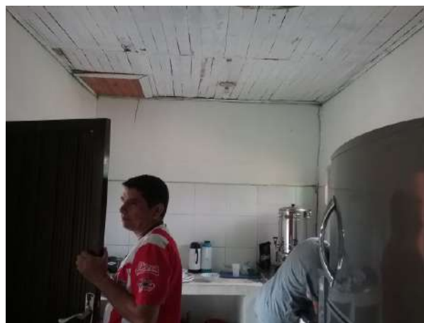
Ilustración 229. Imagen interior espacio 3. Fuente: Equipo de Diagnóstico
