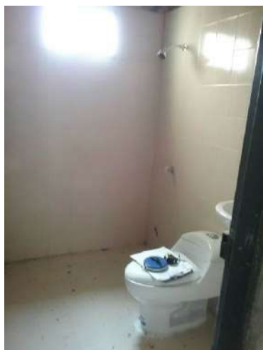
Ilustración 266. Espacio 11. Fuente: Equipo Diagnostico
