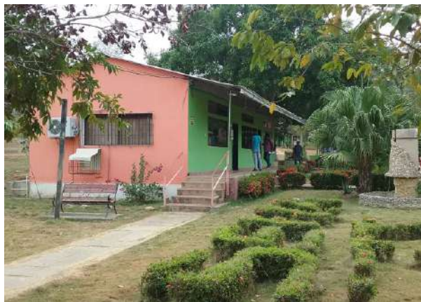
Ilustración 226. Fachada Bloque 5 Fuente: Equipo de diagnóstico
