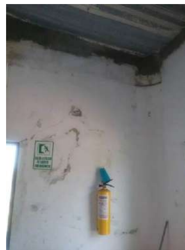
Ilustración 269. Espacio 14. Fuente: Equipo Diagnostico
