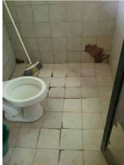
Ilustración 329. Imagen interior espacio 2. Fuente: Equipo de Diagnóstico
