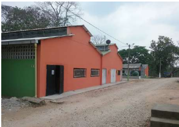
Ilustración 380. Fachadas Bloque 35. Fuente: Equipo de diagnóstico
