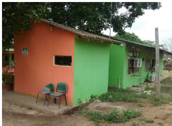
Ilustración 225. Fachada Bloque 5 Fuente: Equipo de diagnóstico
