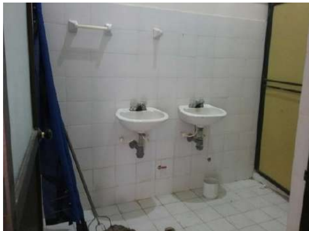
Ilustración 264. Espacio 15. Fuente: Equipo Diagnostico
