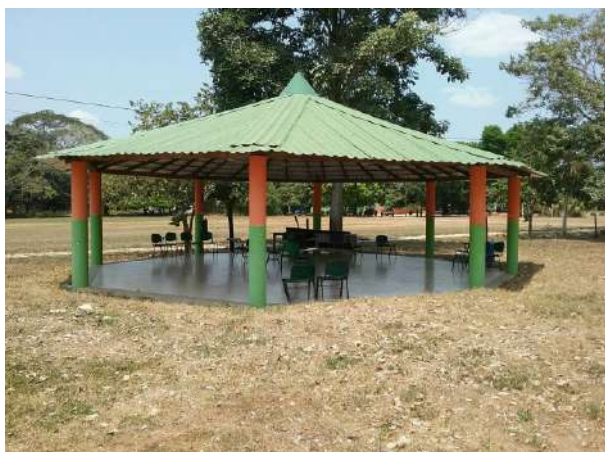
Ilustración 253. Fachada Bloque 14. Fuente: Equipo Diagnostico
