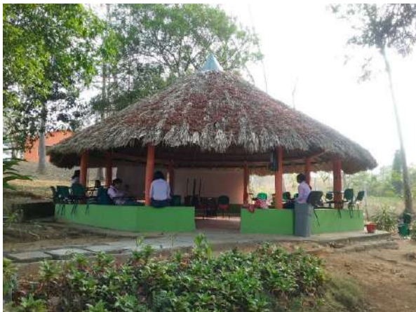
Ilustración 239. Fachada Bloque 9. Fuente: Equipo Diagnostico
