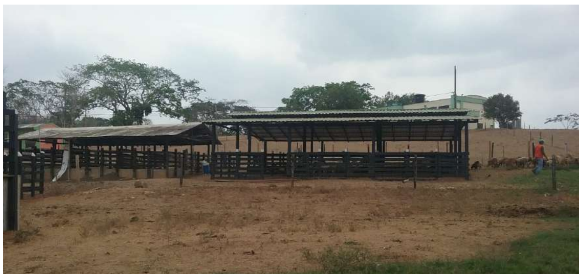
Ilustración 397. Fachadas Bloque 40 Fuente: Equipo de diagnóstico
