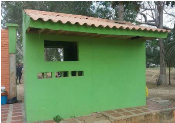
Ilustración 387. Fachadas Bloque 37 Fuente: Equipo de diagnóstico
