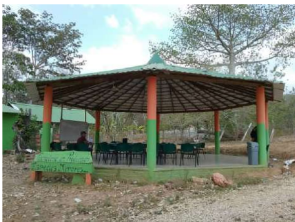
Ilustración 255. Fachada Bloque 39. Fuente: Equipo Diagnostico
