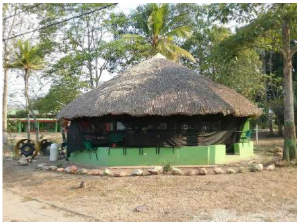
Ilustración 241. Fachada Bloque 11. Fuente: Equipo Diagnostico
