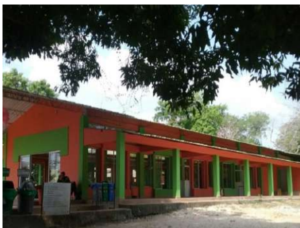
Ilustración 216. Fachada Bloque 4. Fuente: Equipo Diagnóstico
