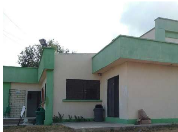
Ilustración 262. Fachada Bloque 15. Fuente: Equipo Diagnóstico
