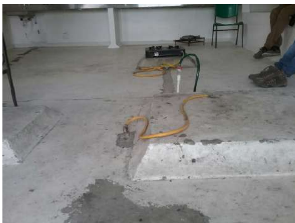
Ilustración 274. Espacio 18. Fuente: Equipo Diagnostico
