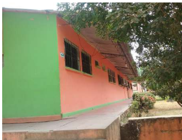
Ilustración 207. Fachadas Bloque 3 Fuente: Equipo de diagnóstico
