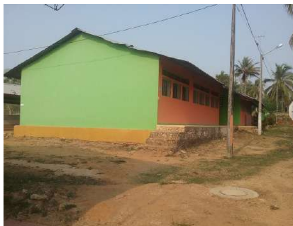
Ilustración 197. Fachadas Bloque 1. Fuente: Equipo de diagnóstico
