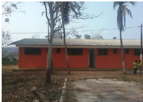
Ilustración 326. Fachadas Bloque 24. Fuente: Equipo de diagnóstico
