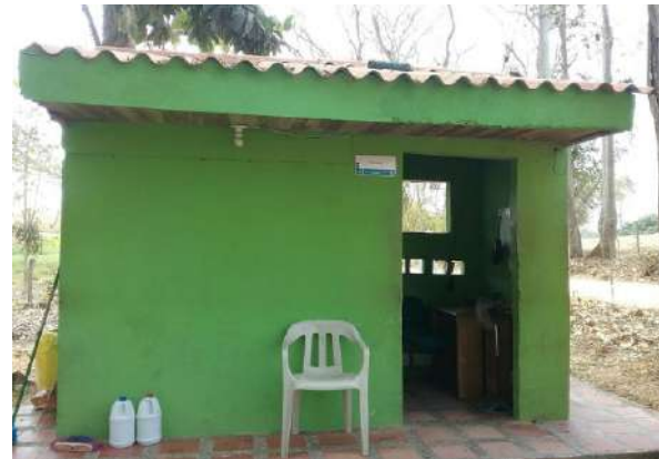
Ilustración 388. Fachadas Bloque 37 Fuente: Equipo de diagnóstico
