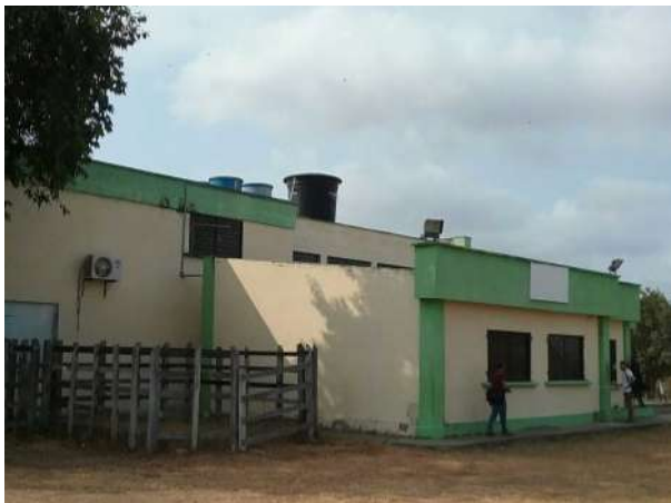
Ilustración 261. Fachada Bloque 15. Fuente: Equipo Diagnóstico
