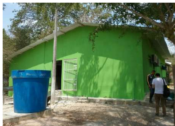
Ilustración 306. Fachada Bloque 15. Fuente: Equipo Diagnostico
