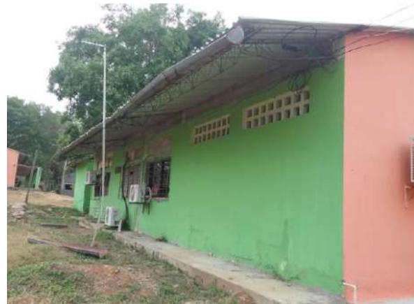
Ilustración 45. Estructura fachada mampostería simple Bloque 5.
