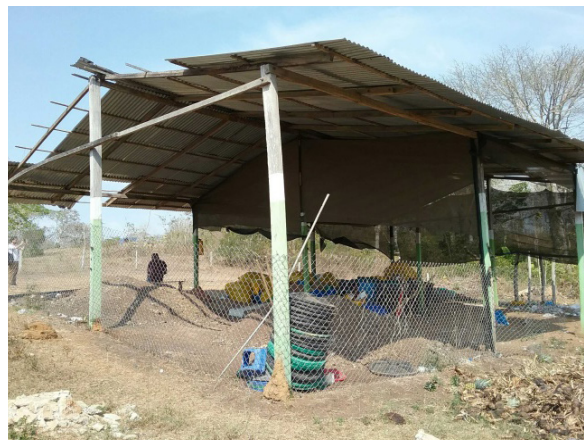
Ilustración 158. Interior y fachada. Bloque 30. Fuente: Equipo de diagnóstico
