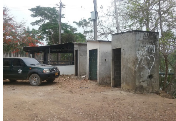
Ilustración 164. Fachada. Bloque 36. Fuente: Equipo de diagnóstico
