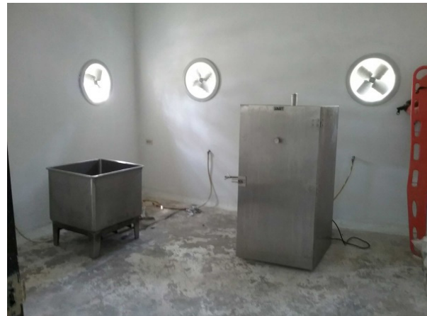
Ilustración 138. Válvulas y aparatos gas domésticos. Bloque 20. Fuente: Equipo de diagnóstico
