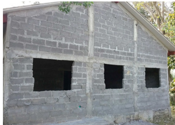
Ilustración 167. Fachada. Bloque 38. Fuente: Equipo de diagnóstico
