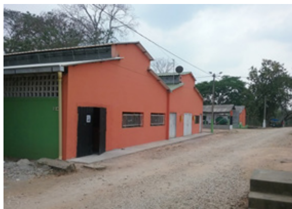
Ilustración 163. Manejo de aguas lluvias. Bloque 35. Fuente: Equipo de diagnóstico
