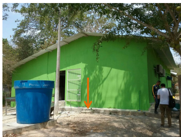
Ilustración 137. Cajas de aguas negras. Bloque 20. Fuente: Equipo de diagnóstico
