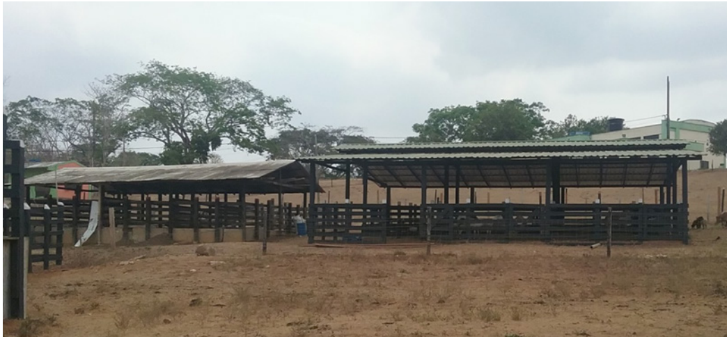
Ilustración 168. Fachada. Bloque 40. Fuente: Equipo de diagnóstico
