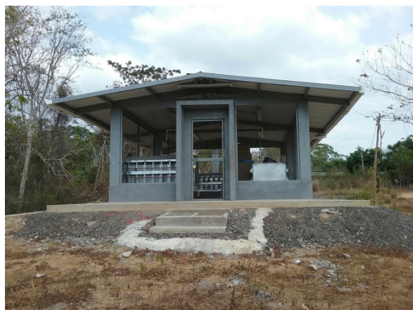
Ilustración 143. Desagües laterales y Poceta para lavado de pies. Bloque 23. Fuente: Equipo de diagnóstico
