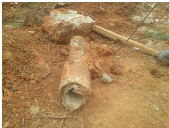
Ilustración 99. Reparación y cambio de tubería antigua en Asbesto. Fuente: Equipo de diagnóstico
