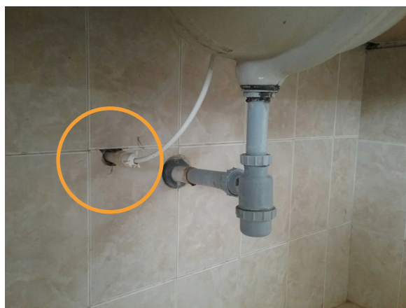
Ilustración 102. Puntos hidráulicos. Bloque 1. Fuente: Equipo de diagnóstico
