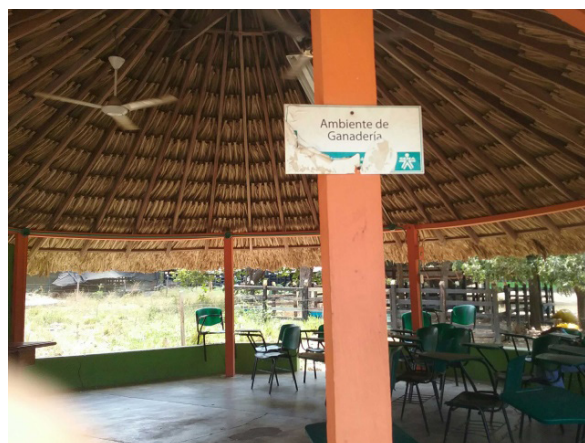
Ilustración 120 . Fachada kiosco. Bloque 13. Fuente: Equipo de diagnóstico
