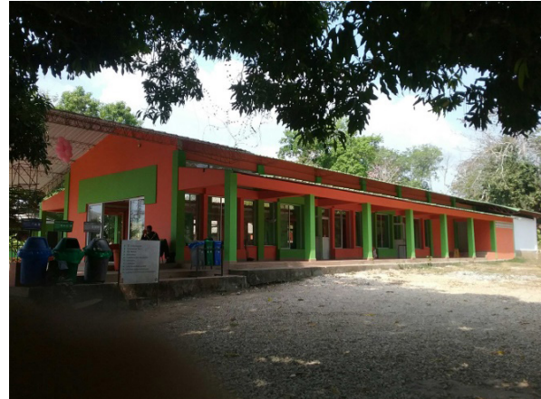
Ilustración 109. Cubierta. Bloque 4 Fuente: Equipo de diagnóstico
