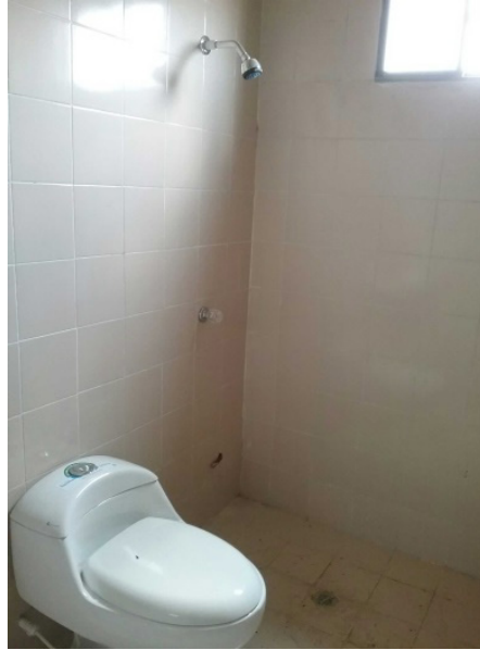
Ilustración 122. Válvula de control de espacio sin cajilla. Bloque 15. Fuente: Equipo de diagnóstico
