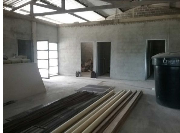
Ilustración 128. Interior y fachada en construcción. Bloque 16. Fuente: Equipo de diagnóstico
