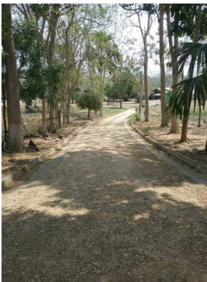
Ilustración 93. Manejo de aguas lluvias con cunetas para vías al interior del centro. Fuente: Equipo de diagnóstico
