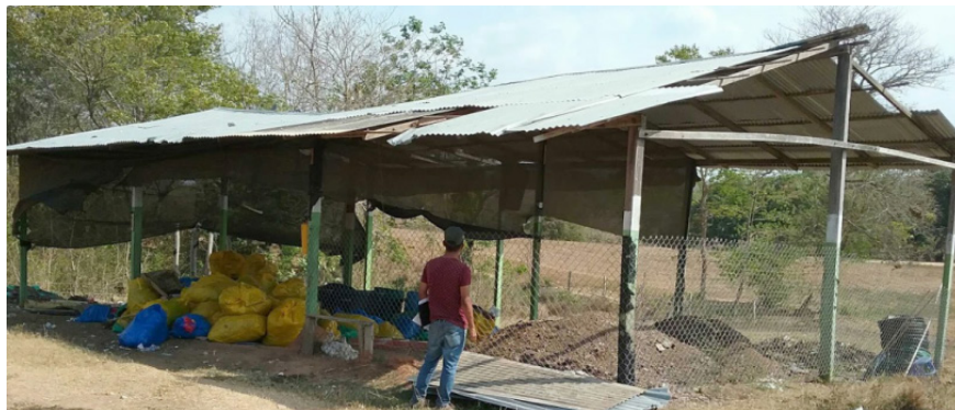
Ilustración 72. Hangar Bloque 30. Fuente: equipo diagnóstico.
