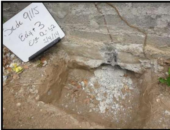
MUROS EN MUY MAL ESTADO, FISURADOS EN SU TOTALIDAD JUNTO CON LAS COLUMNETAS Y VIGAS.
