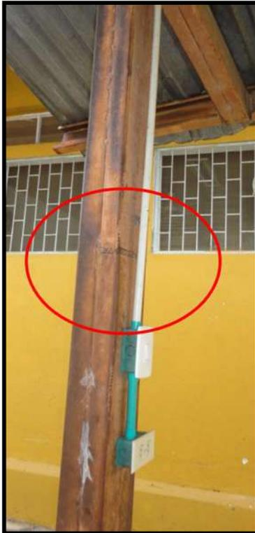
LA CUBIERTA ESTA UNIDA A LAS COLUMNAS POR MEDIO DE UNA PLATINA NO DEFINIDA POR MEDIO DE SOLDADURA, LA CUAL ESTA OXIDADA Y ALGO DETERIORADA. LOS ELEMENTOS DE LA CUBIERTA ESTÁN UNIDOS POR MEDIO DE SOLDADURAS UN POCO DEFICIENTE
