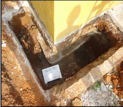
MUROS EN MAMPOSTERÍA SIMPLE, SIN NINGÚN TIPO DE REFUERZO, QUE EN ALGUNAS ZONAS NO VAN DE CIMENTACIÓN A CUBIERTA Y SE ENCUENTRAN SUELTOS DE SU BASE.
