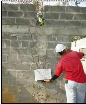
VIGAS Y COLUMNETAS CON HORMIGUEO DEBIDO AL MAL VACIADO DEL CONCRETO, MUROS TOTALMENTE DESPLOMADOS JUNTO CON LOS ELEMENTOS ESTRUCTURALES. LAS COLUMNETAS NO ESTÁN TERMINADAS EN SU TOTALIDAD
