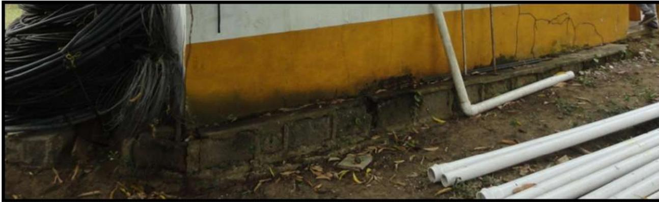
MAMPOSTERÍA SIMPLE DE 0.10M DE ESPESOR, EN MUY MAL ESTADO, FISURADOS EN SU TOTALIDAD.
