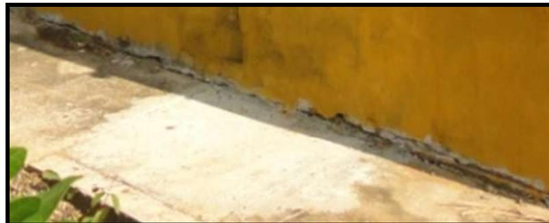
ESTOS MUROS CUENTAN CON UNA VIGA AÉREA PERIMETRAL EN CONCRETO REFORZADO, DE NINGUNA MANERA ESTA ANCLADA A LOS MUROS Y SU BASE ES DEFICIENTE.
