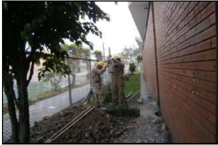
Ejecución del Sondeo No. 9
