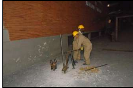
Ejecución del Sondeo No. 2
