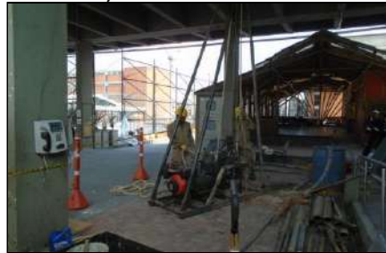
Ejecución del Sondeo No. 6
