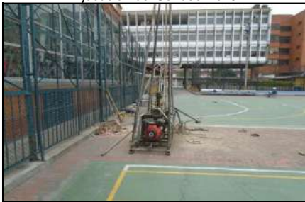
Ejecución del Sondeo No. 7
