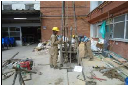
Ejecución del Sondeo No. 11
