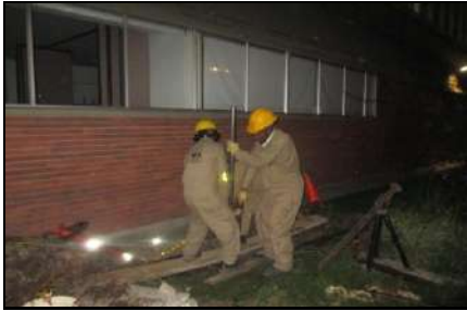
Ejecución del Sondeo No. 1
