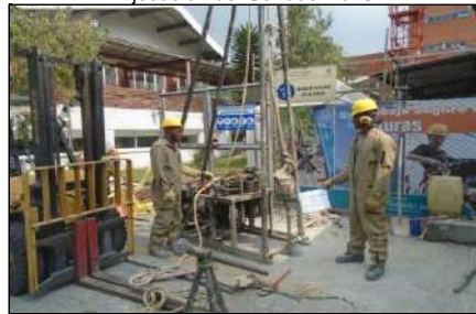
Ejecución del Sondeo No. 8
