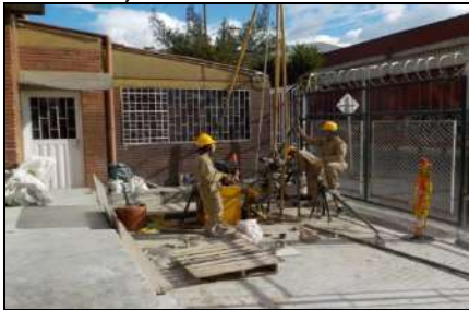
Ejecución del Sondeo No. 5
