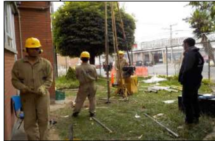
Ejecución del Sondeo No. 4
