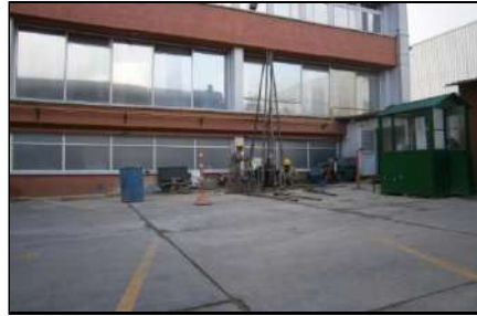
Ejecución del Sondeo No. 10
