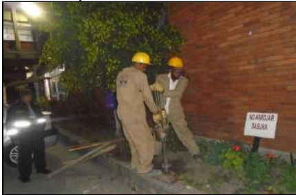
Ejecución del Sondeo No. 3
