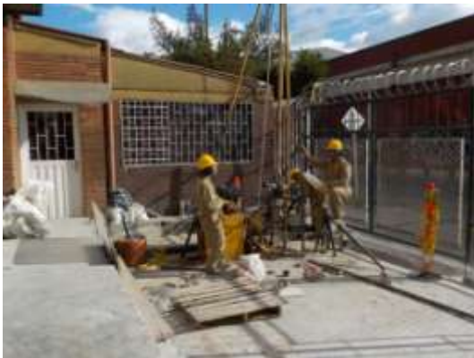
Fotografía 4-9 Ejecución del Sondeo S-5 Fuente: Técnicas Colombianas de Ingeniería, 2016
