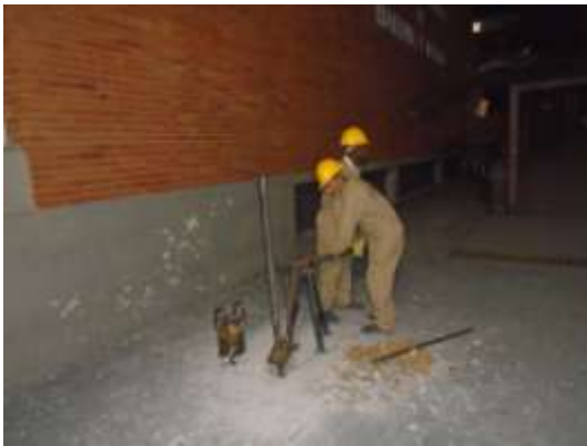
Fotografía 4-3 Ejecución del Sondeo S-2 Fuente: Técnicas Colombianas de Ingeniería, 2016
