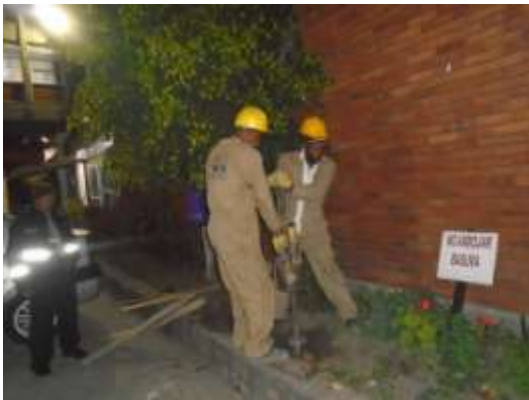
Fotografía 4-5 Ejecución del Sondeo S-3 Fuente: Técnicas Colombianas de Ingeniería, 2016
