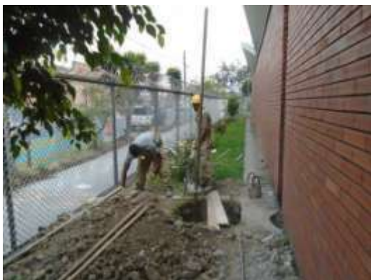
Fotografía 4-17 Ejecución del Sondeo S-9 Fuente: Técnicas Colombianas de Ingeniería, 2016
