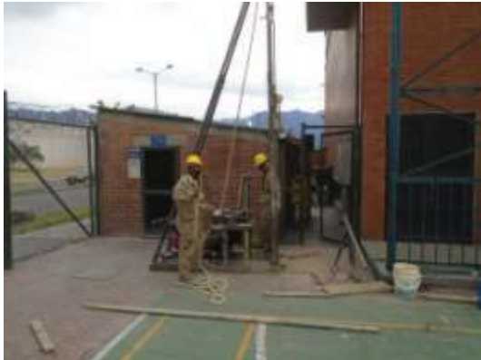
Fotografía 4-13 Ejecución del Sondeo S-7 Fuente: Técnicas Colombianas de Ingeniería, 2016
