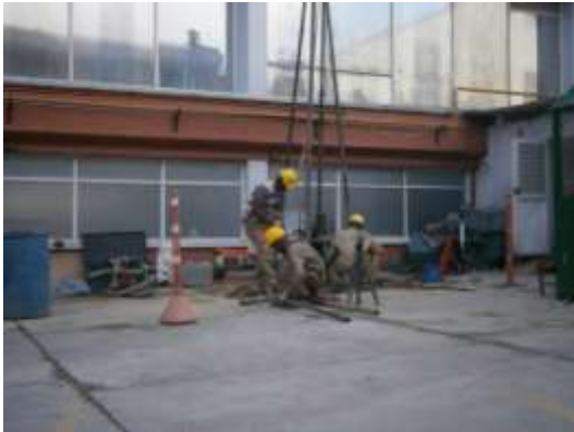
Fotografía 4-19 Ejecución del Sondeo S-10 Fuente: Técnicas Colombianas de Ingeniería, 2016
