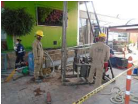
Fotografía 4-11 Ejecución del Sondeo S-6 Fuente: Técnicas Colombianas de Ingeniería, 2016
