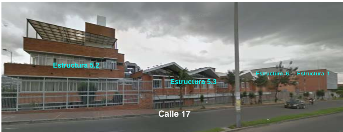
Fotografía 2-3 Vista de Estructura 5.2, Estructura 5.3, Estructura 6 y Estructura 1 (Desde la Calle 17) Fuente: Google Street View, 2016
