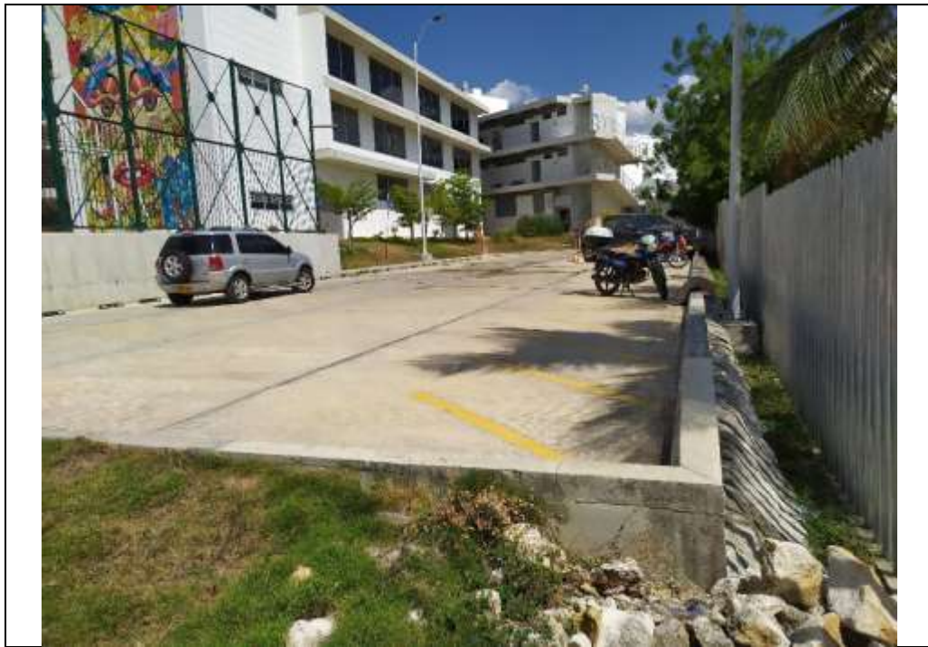
Fotografía 1. Parqueadero existente donde se realizará la intervención.
