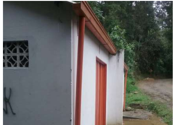
Ilustración 341. Bloque 52. Bajantes de aguas lluvia. Fuente: Equipo de diagnóstico.
