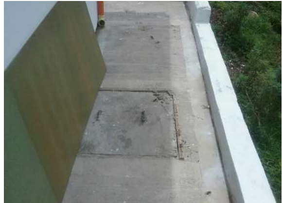
Ilustración 267. Bloque 39. Cajas de inspección de aguas residuales. Fuente: Equipo de diagnóstico.
