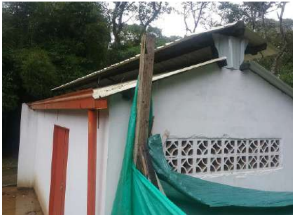
Ilustración 340. Bloque 52. Cubierta. Fuente: Equipo de diagnóstico.
