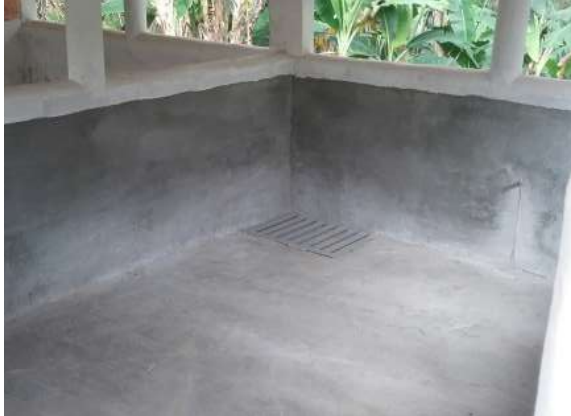
Ilustración 377. Bloque 66. Rejillas de piso. Fuente: Equipo de diagnóstico.
