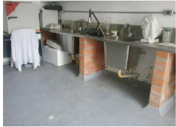
Ilustración 77. Bloque 9. Instalaciones incrustadas en muros. Fuente: Equipo de Diagnostico.
