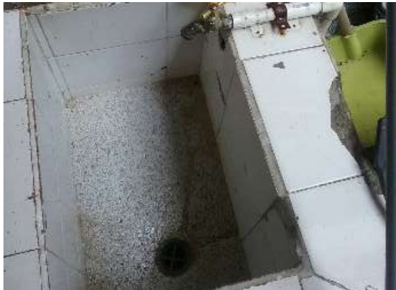
Ilustración 19. Bloque 5. Tuberías en pvcp de 1/2". Fuente: Equipo de Diagnóstico.
