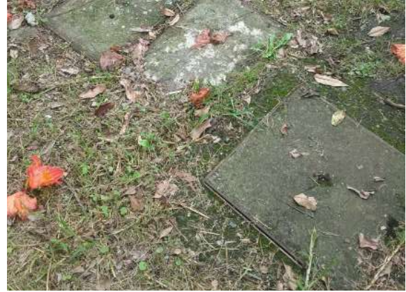
Ilustración 182. Bloque 20. Cajas de inspección. Fuente: Equipo de Diagnostico.
