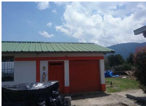
Ilustración 504. Bloque 100. Extintor multipropósito. Fuente: Equipo de diagnóstico.
