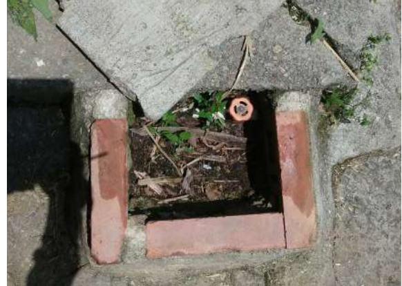
Ilustración 486. Bloque 95. Registro de corte general del suministro del bloque. Fuente: Equipo de diagnóstico.
