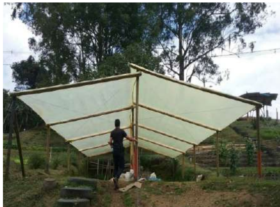
Ilustración 364. Bloque 62. Cubierta. Fuente: Equipo de diagnóstico.
