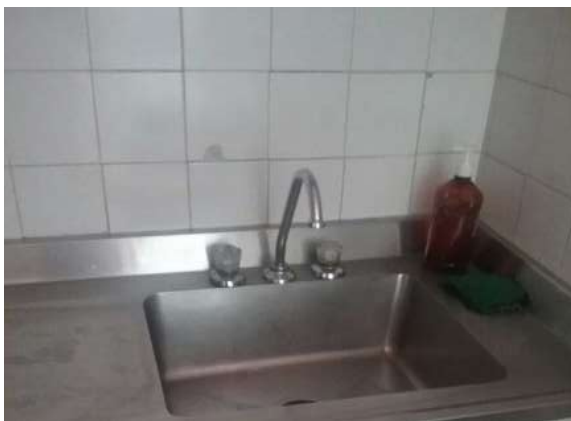
Ilustración 162. Bloque 19. Instalaciones en buen estado. Fuente: Equipo de Diagnóstico.
