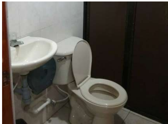
Ilustración 88. Bloque 10. Salidas sanitarias funcionan de manera correcta. Fuente: Equipo de Diagnostico.
