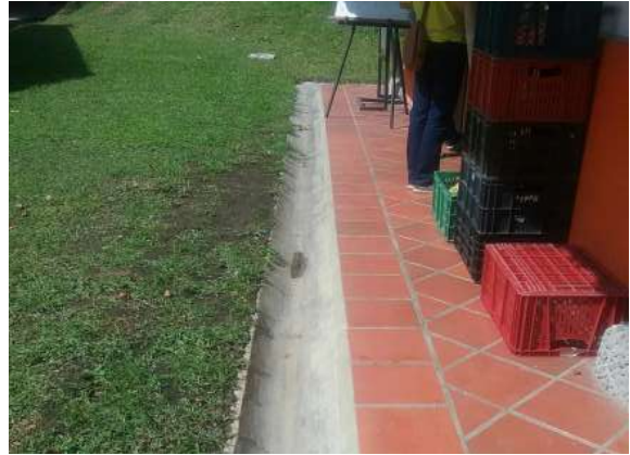
Ilustración 388. Bloque 68. Cuneta perimetral. Fuente: Equipo de diagnóstico.
