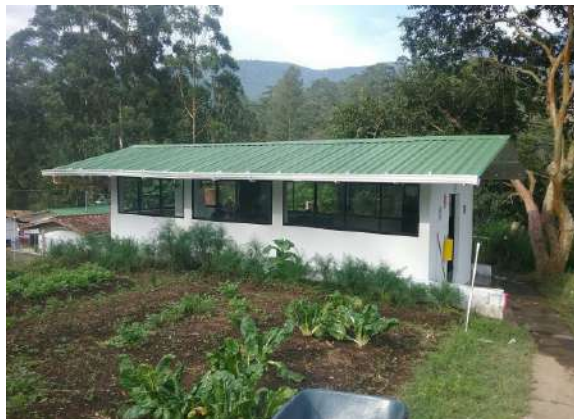
Ilustración 264. Bloque 39. Cubierta. Fuente: Equipo de diagnóstico.
