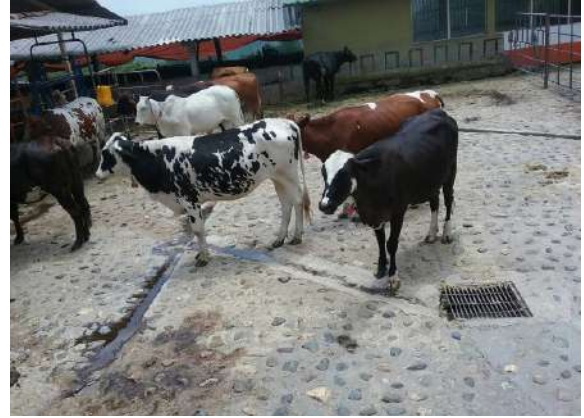
Ilustración 500. Bloque 97. Sumideros de aguas lluvia. Fuente: Equipo de diagnóstico.
