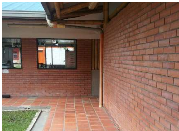
Ilustración 307. Bloque 45. Bajantes en tubería pvc de 3". Fuente: Equipo de diagnóstico.
