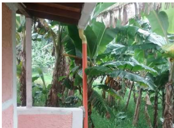
Ilustración 375. Bloque 66. Bajantes de aguas lluvia. Fuente: Equipo de diagnóstico.
