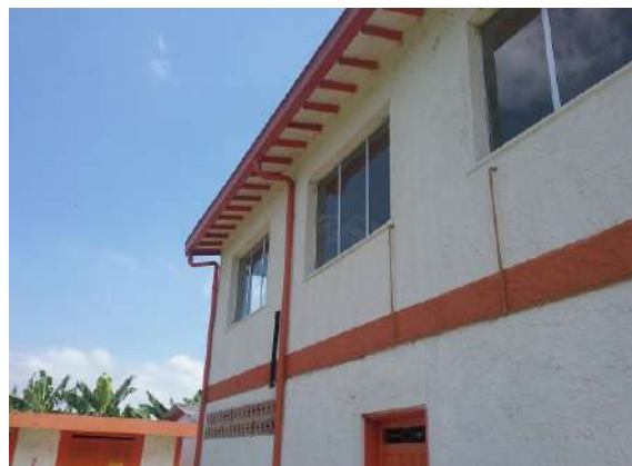
Ilustración 470. Bloque 92. Bajantes de aguas lluvia. Fuente: Equipo de diagnóstico.
