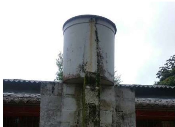
Ilustración 132. Bloque 16. Tanque 2 en fibrocemento. Fuente: Equipo de Diagnostico.
