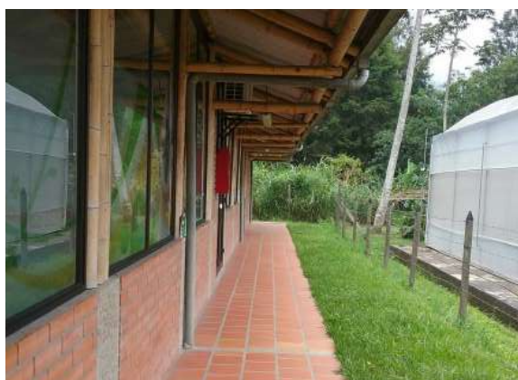
Ilustración 319. Bloque 48. Bajantes de aguas lluvia. Fuente: Equipo de diagnóstico.
