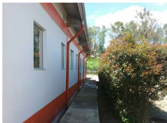
Ilustración 511. Bloque 101. Bajantes de aguas lluvia. Fuente: Equipo de diagnóstico.
