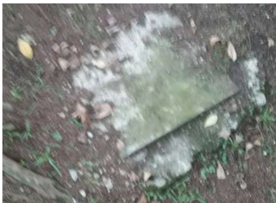
Ilustración 191. Bloque 21. Cajas de inspección de aguas lluvia. Fuente: Equipo de Diagnóstico.
