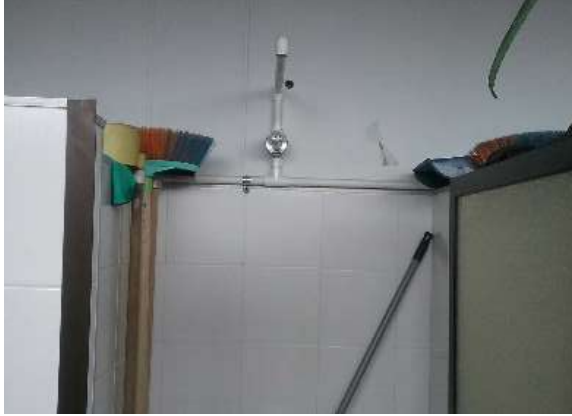
Ilustración 29. Bloque 5. Tubería pvcp de 1/2" a la vista. Fuente: Equipo de Diagnostico.
