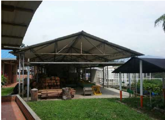
Ilustración 299. Bloque 44. Cubierta. Fuente: Equipo de diagnóstico.
