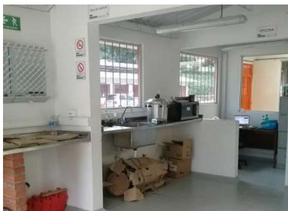
Ilustración 285. Bloque 42. Instalaciones en buen estado. Fuente: Equipo de diagnóstico.
