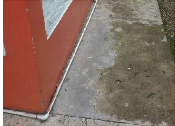
Ilustración 134. Bloque 16. Tuberías pvcp de ½” a la vista. Fuente: Equipo de Diagnostico.
