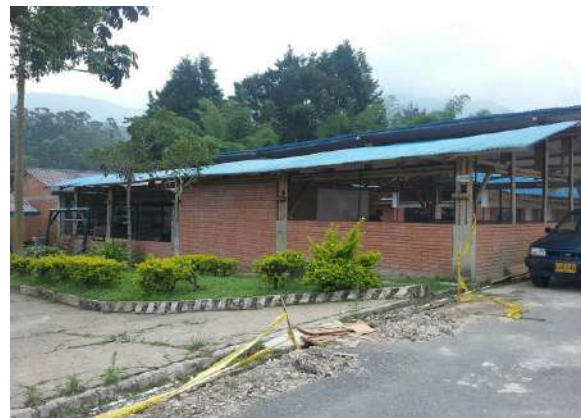
Ilustración 352. Bloque 58. Cubierta sin canaletas. Fuente: Equipo de diagnóstico.
