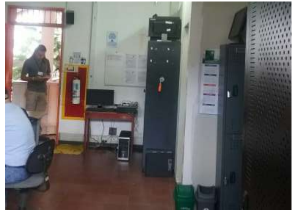
Ilustración 52. Bloque 5. Extintor multipropósito. Fuente: Equipo de Diagnostico.
