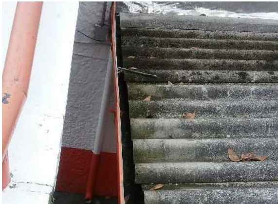
Ilustración 36. Bloque 5. Cubiertas con canaletas. Fuente: Equipo de Diagnostico.
