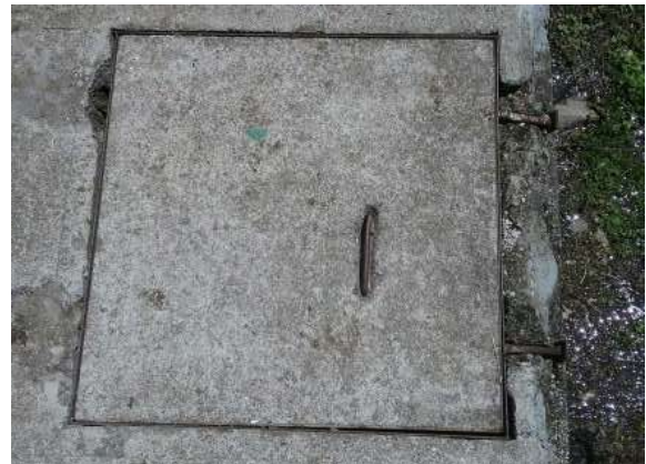
Ilustración 515. Bloque 101. Caja de inspección. Fuente: Equipo de diagnóstico.
