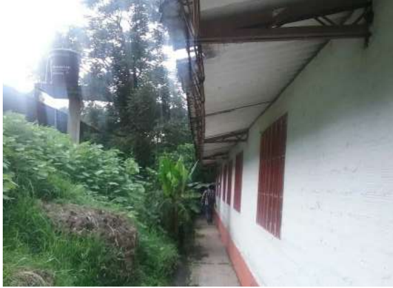
Ilustración 249. Bloque 35. Cubierta sin canaletas. Fuente: Equipo de diagnóstico.
