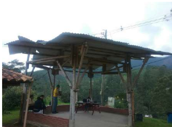
Ilustración 234. Bloque 32. Estructura en madera para cubrir de las precipitaciones. Fuente: Equipo de diagnóstico.
