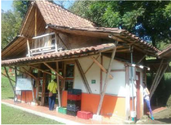
Ilustración 387. Bloque 68. Cubierta en teja tipo colonial. Fuente: Equipo de diagnóstico.
