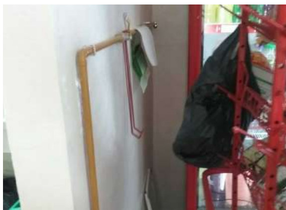
Ilustración 197. Bloque 22. Instalación sobrante. Fuente: Equipo de Diagnostico.
