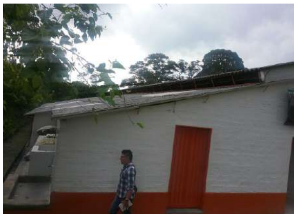
Ilustración 241. Bloque 34. Cubierta. Fuente: Equipo de diagnóstico.
