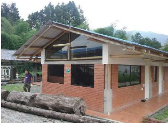
Ilustración 325. Bloque 49. Cubierta a dos aguas. Fuente: Equipo de diagnóstico.
