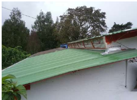
Ilustración 405. Bloque 71. Cubierta en teja pvc. Fuente: Equipo de diagnóstico.
