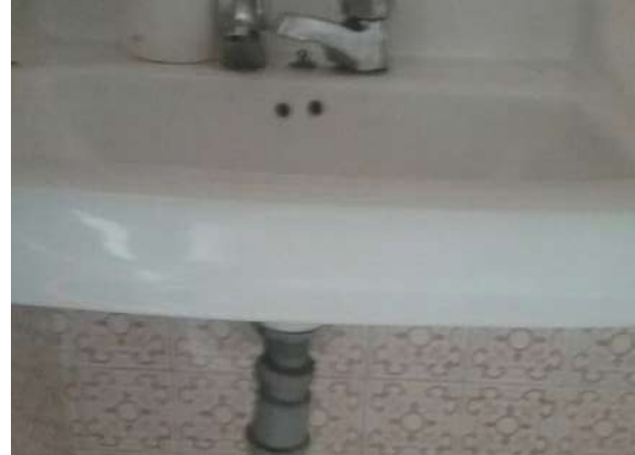
Ilustración 165. Bloque 19. Instalaciones en buen estado. Fuente: Equipo de diagnóstico.
