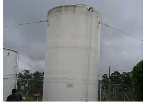
Ilustración 441. Bloque 82. Tanque de fibra de vidrio capacidad 20.000 litros. Fuente: Equipo de diagnóstico.
