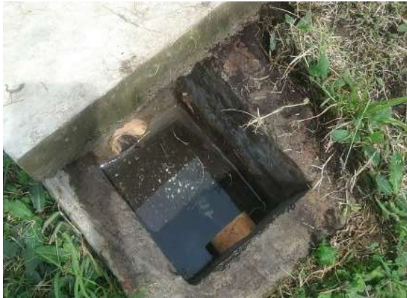
Ilustración 266. Bloque 39. Caja de inspección. Fuente: Equipo de diagnóstico.
