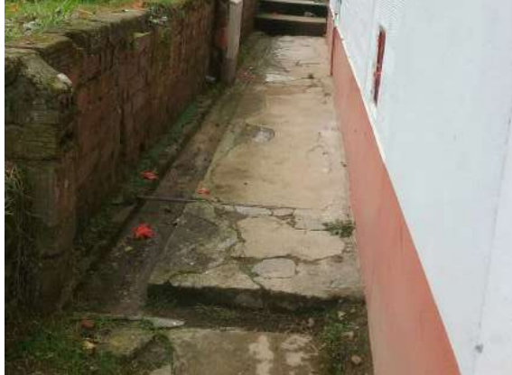
Ilustración 150. Bloque 17. Tubería principal en acero galvanizado. Fuente: Equipo de Diagnóstico.
