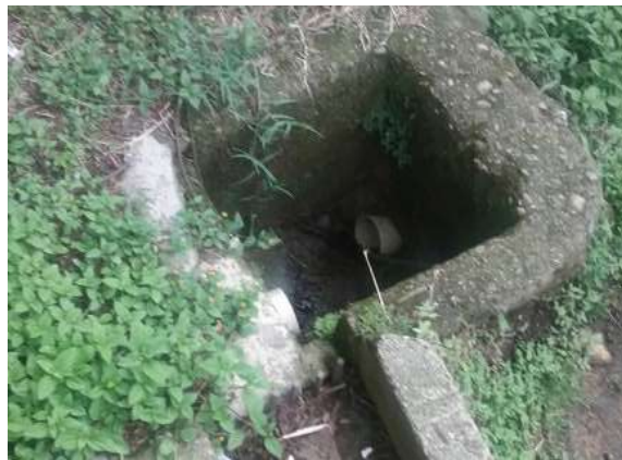
Ilustración 251. Bloque 35. Cajas de inspección de aguas lluvia. Fuente: Equipo de diagnóstico.
