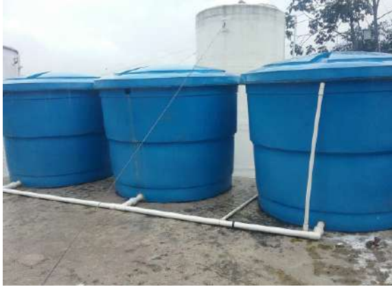
Ilustración 440. Bloque 82. Tanques plásticos de 5.000 litros. Fuente: Equipo de diagnóstico.
