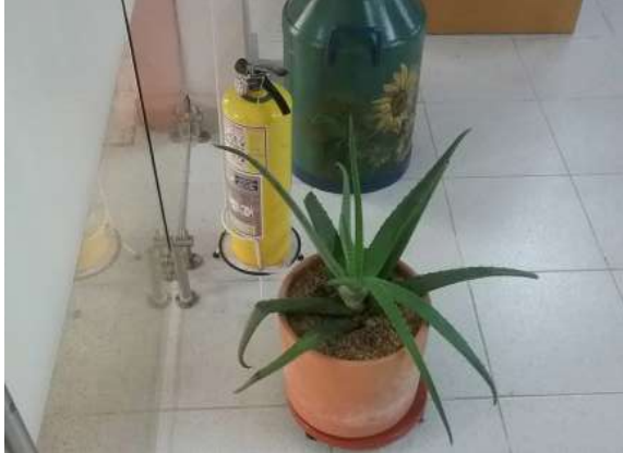
Ilustración 43. Bloque 5. Espacio biblioteca. Extintor multipropósito. Fuente: Equipo de Diagnostico.
