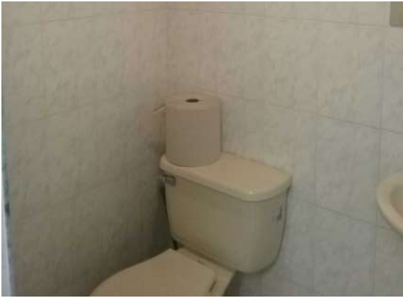
Ilustración 76. Bloque 9. Instalaciones incrustadas en muros. Fuente: Equipo de Diagnostico.
