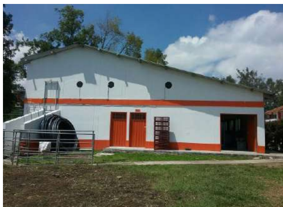
Ilustración 510. Bloque 101. Cubierta. Fuente: Equipo de diagnóstico.
