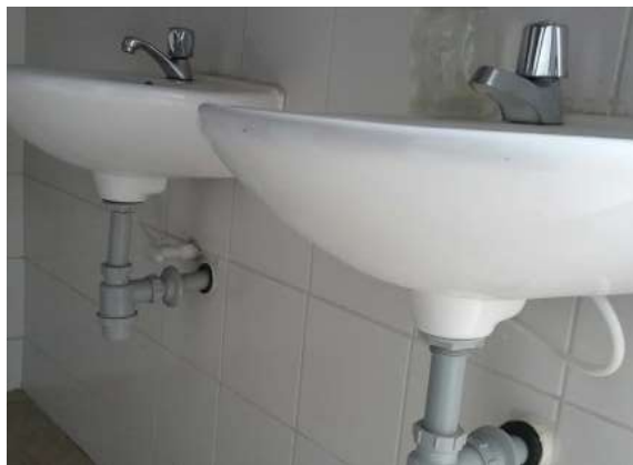
Ilustración 393. Bloque 69. Puntos hidráulicos con acoples plásticos. Fuente: Equipo de diagnóstico.
