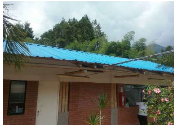
Ilustración 326. Bloque 49. Cubierta sin canaletas. Fuente: Equipo de diagnóstico.
