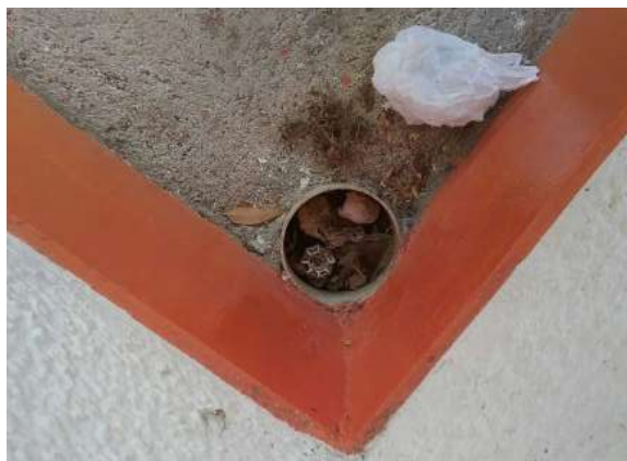
Ilustración 464. Bloque 92. Registro de corte general tipo compuerta. Fuente: Equipo de diagnóstico.
