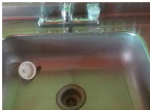
Ilustración 223. Instalaciones funcionan de manera correcta. Fuente: Equipo de diagnóstico.
