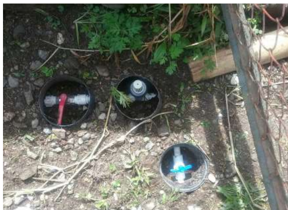
Ilustración 209. Bloque 25 válvulas de control de la siembra. Fuente: Equipo de diagnóstico.
