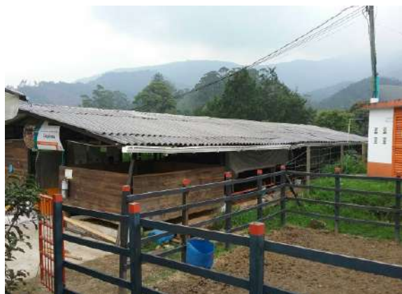
Ilustración 279. Bloque 41. Cubierta. Fuente: Equipo de diagnóstico.
