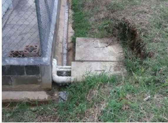
Ilustración 530. Bloque 104. Desagües funcionan de manera correcta. Fuente: Equipo de diagnóstico.
