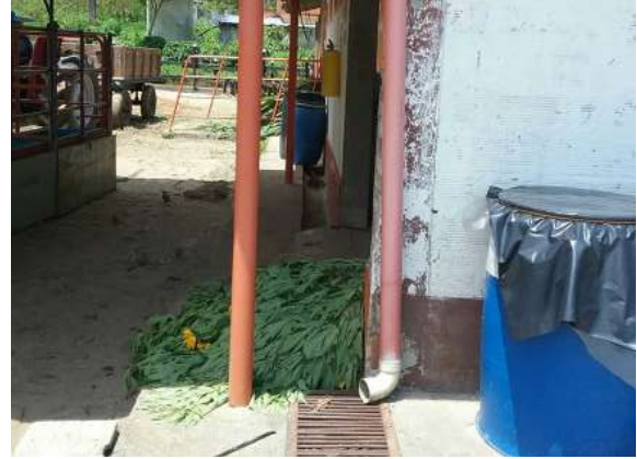
Ilustración 489. Bloque 95. Bajantes de aguas lluvia. Fuente: Equipo de diagnóstico.
