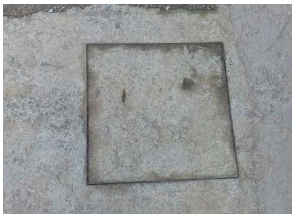
Ilustración 472. Bloque 92. Caja de inspección. Fuente: Equipo de diagnóstico.
