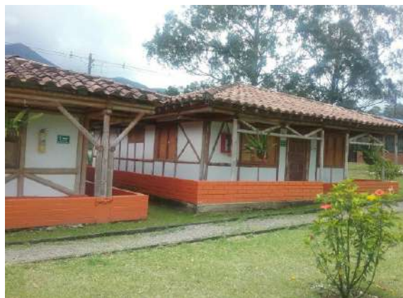
Ilustración 230. Bloque 27 y 28. Extintores tipo multipropósito. Fuente: Equipo de diagnóstico.
