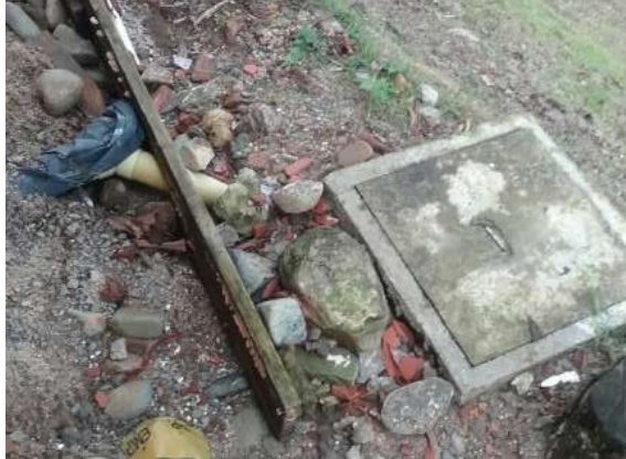
Ilustración 155. Bloque 17. Caja de inspección de aguas negras. Fuente: Equipo de Diagnostico.
