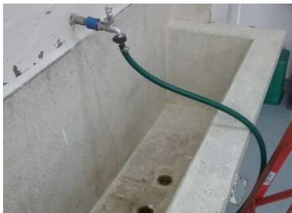
Ilustración 507. Bloque 101. Llave tipo manguera. Fuente: Equipo de diagnóstico.
