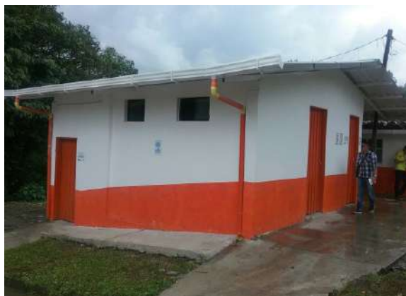
Ilustración 260. Bloque 38. Cubierta. Fuente: Equipo de diagnóstico.
