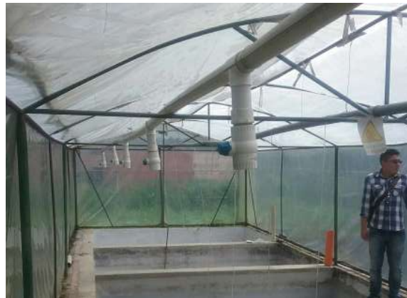
Ilustración 207. Bloque 24. Tubería pvcp de 1". Fuente: Equipo de diagnóstico.
