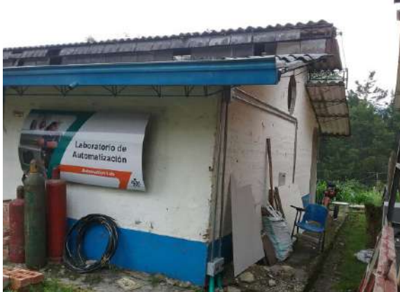
Ilustración 86. Bloque 10. Cubierta a dos aguas. Fuente: Equipo de Diagnostico.
