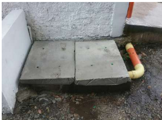
Ilustración 261. Bloque 38. Cajas de inspección de aguas lluvia. Fuente: Equipo de diagnóstico.
