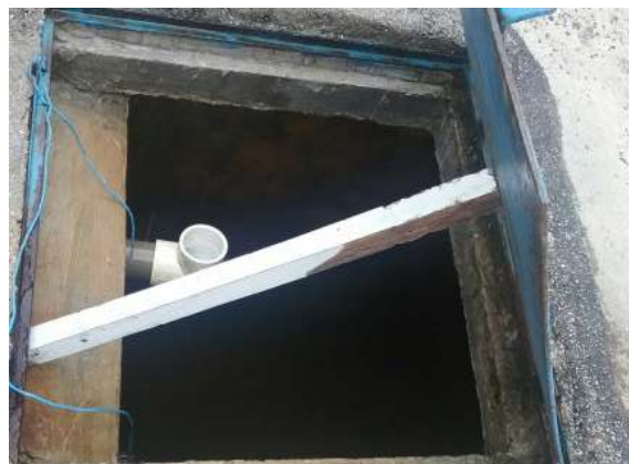
Ilustración 439. Bloque 82. Compuerta de acceso al tanque de 45.000 litros. Fuente: Equipo de diagnóstico.
