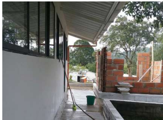
Ilustración 265. Bloque 39. Bajantes en tubería pvc de 3". Fuente: Equipo de diagnóstico.
