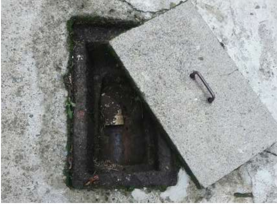
Ilustración 181. Bloque 20. Caja de inspección. Fuente: Equipo de Diagnostico.
