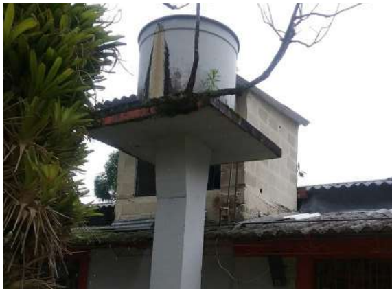
Ilustración 131. Bloque 16. Tanque 1 en fibrocemento. Fuente: Equipo de Diagnostico.
