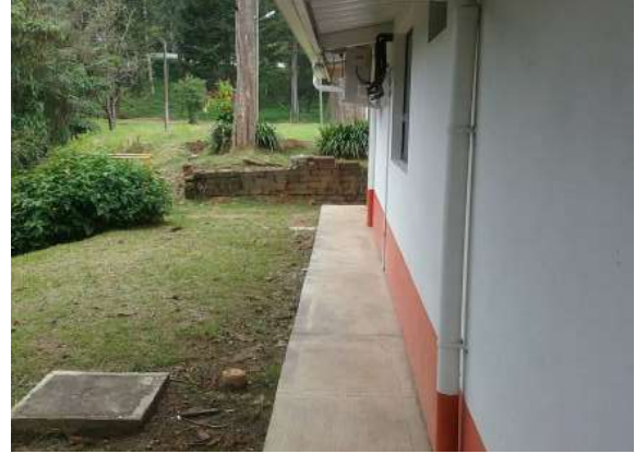
Ilustración 153. Bloque 17. Bajantes de aguas lluvia en tubería pvcs de 3" Fuente: Equipo de Diagnostico.
