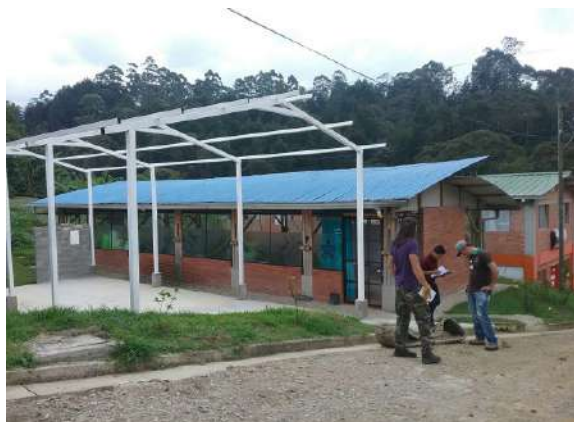
Ilustración 335. Bloque 51. Cubierta. Fuente: Equipo de diagnóstico.
