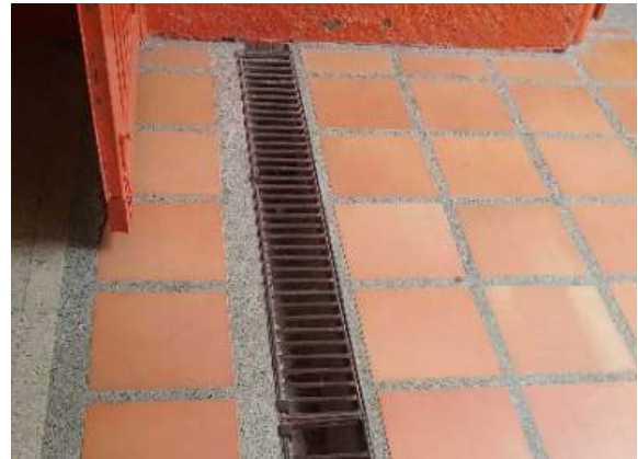
Ilustración 37. Bloque 5. Sumideros de aguas lluvia. Fuente: Equipo de Diagnostico.
