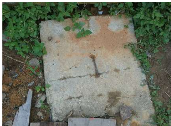
Ilustración 473. Bloque 92. Caja de inspección. Fuente: Equipo de diagnóstico.
