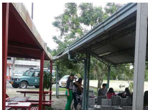
Ilustración 371. Bloque 65. Tubería en pvc de 3" Fuente: Equipo de diagnóstico.
