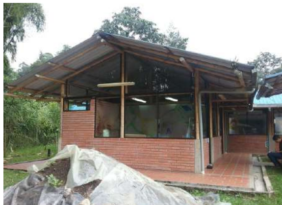
Ilustración 314. Bloque 47. Cubierta. Fuente: Equipo de diagnóstico.
