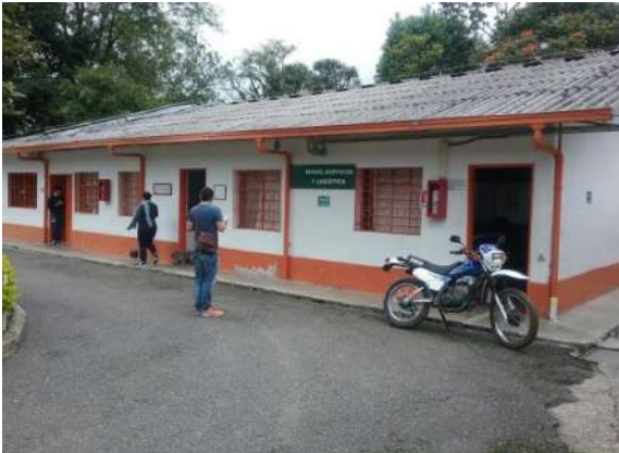
Ilustración 184. Bloque 20. Extintores exteriores. Fuente: Equipo de Diagnostico.
