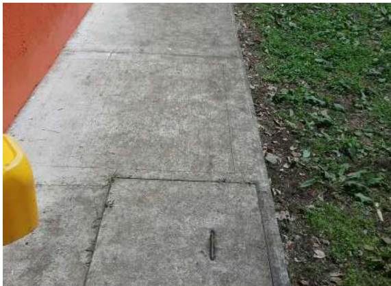
Ilustración 514. Bloque 101. Caja de inspección. Fuente: Equipo de diagnóstico.
