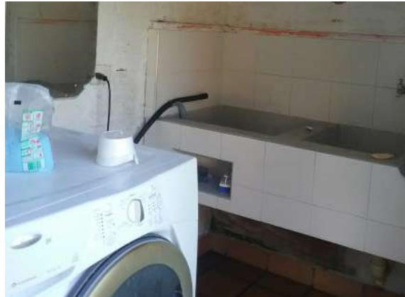
Ilustración 457. Bloque 88. Desagües de 2" en tubería pvc. Fuente: Equipo de diagnóstico.
