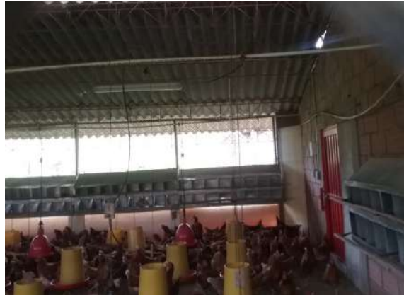
Ilustración 410. Bloque 72. Tuberías pvcp de 1/2" en mal estado. Fuente: Equipo de diagnóstico.
