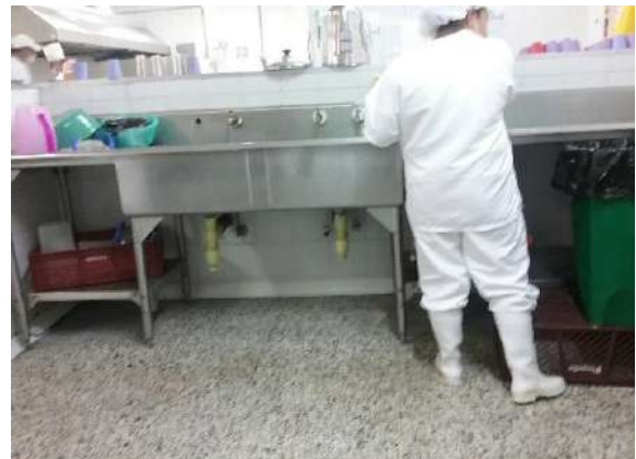
Ilustración 22. Bloque 5. Instalaciones incrustadas en muros. Fuente: Equipo de Diagnóstico.
