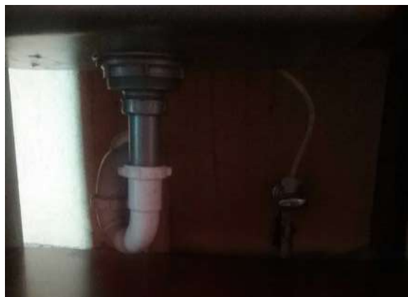
Ilustración 227. Bloque 28. Sifones en buen estado. Fuente: Equipo de diagnóstico.
