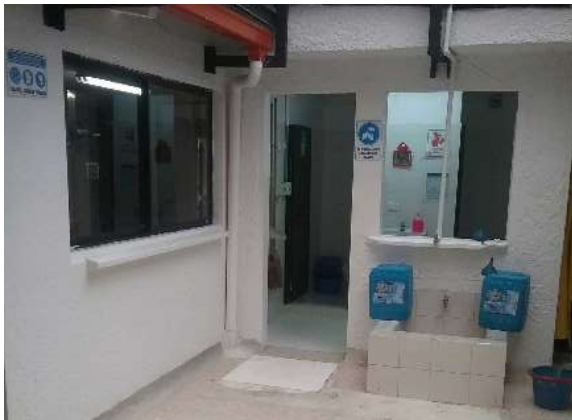
Ilustración 32. Bloque 5. Punto hidráulico. Fuente: Equipo de Diagnostico.
