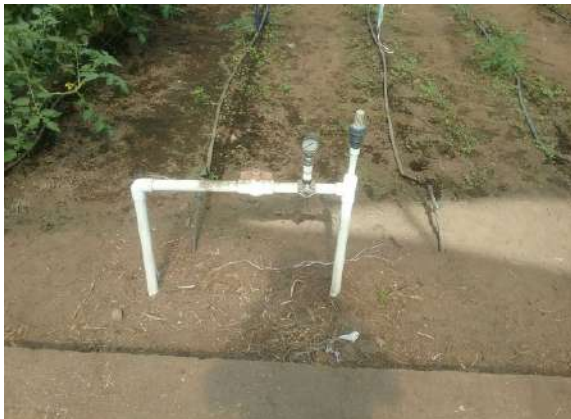
Ilustración 344. Bloque 55. Tubería pvcp de 1/2". Fuente: Equipo de diagnóstico.
