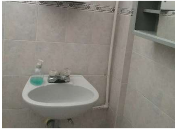
Ilustración 29. Bloque 5. Tubería pvcp de 1/2" a la vista. Fuente: Equipo de Diagnostico.
