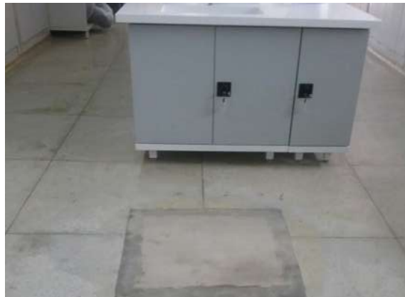
Ilustración 94. Bloque 11. Caja de inspección de aguas residuales. Fuente: Equipo de Diagnostico.
