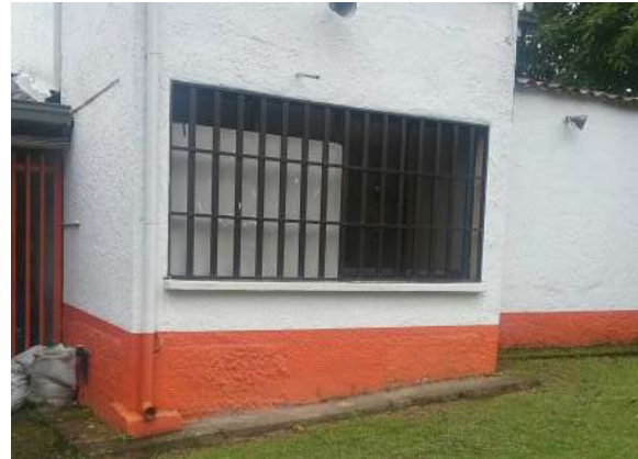
Ilustración 167. Bloque 19. Bajantes de aguas lluvia. Fuente: Equipo de diagnóstico.
