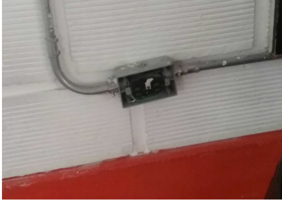
Ilustración 52. Toma corriente Fuente: Equipo Diagnóstico
