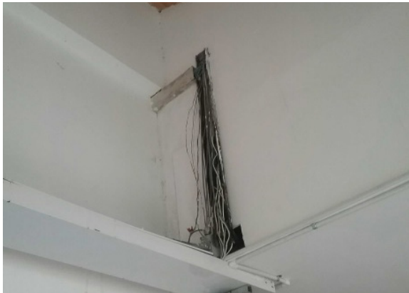
Ilustración 37. Biblioteca Fuente: Equipo Diagnóstico
