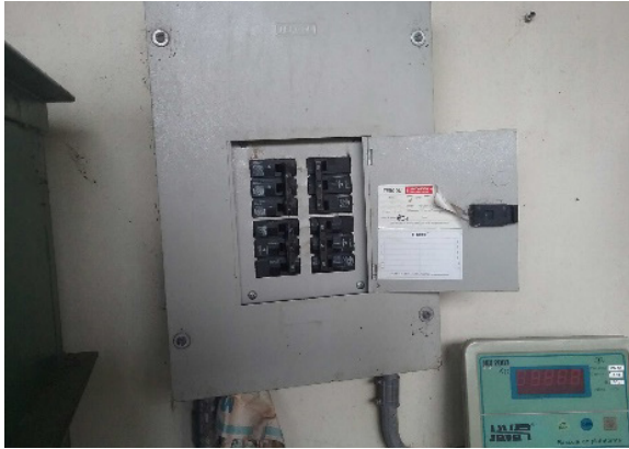
Ilustración 309: Tablero bloque 100. Fuente: equipo de diagnóstico.
