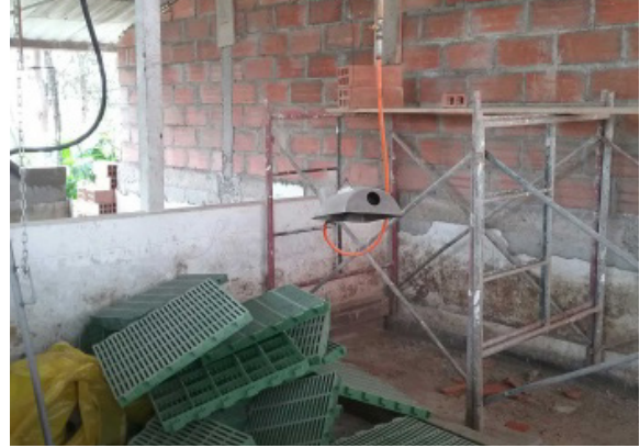
Ilustración 261 Bloque 79. Fuente: equipo diagnóstico.
