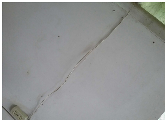
Ilustración 305: tomacorriente. Fuente: equipo de diagnóstico.
