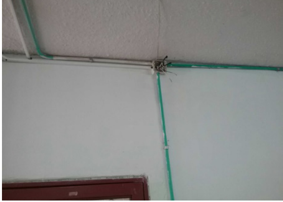
Ilustración 47. Ductería en PVC Fuente: Equipo Diagnóstico
