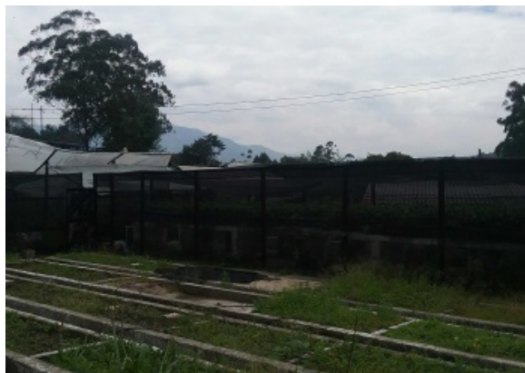
Ilustración 219. Bloque 59. Fuente: equipo diagnóstico.
