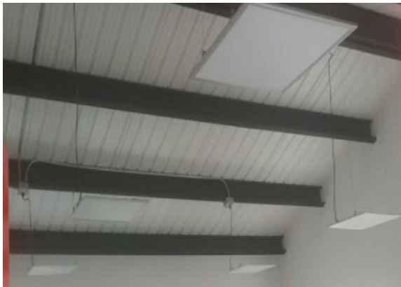
Ilustración 164. Paneles tipo LED. Fuente: equipo diagnóstico
