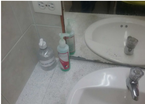
Ilustración 170. Tomacorriente bloque 40. Fuente: equipo diagnóstico
