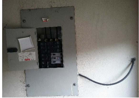
Ilustración 310: Tablero bloque 100. Fuente: equipo de diagnóstico.
