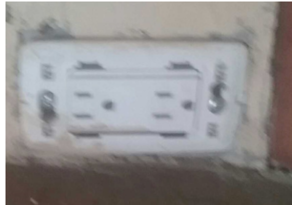
Ilustración 148. Baño cabaña. Fuente: equipo eléctrico
