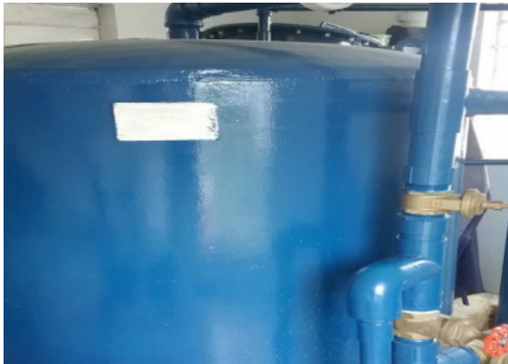
Ilustración 266.Localización del bloque 82. Fuente: equipo diagnóstico.
