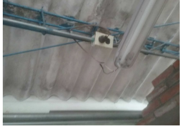
Ilustración 75. Iluminación Fuente: Equipo Diagnóstico
