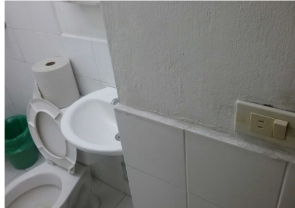
Ilustración 119. Baños. Fuente: Equipo Diagnóstico
