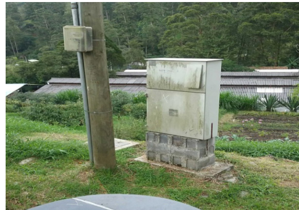
Ilustración 11. Tablero general. Fuente: Equipo Diagnóstico
