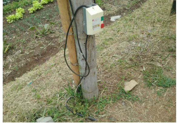
Ilustración 14. Bombas. Fuente: Equipo Diagnóstico
