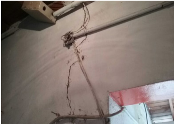
Ilustración 18. Interior bloque 1 Fuente. Equipo Diagnóstico
