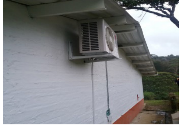
Ilustración 116. Mini Split Fuente: Equipo Diagnóstico
