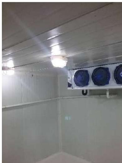
Ilustración 147. Evaporador de aire cuarto frío
