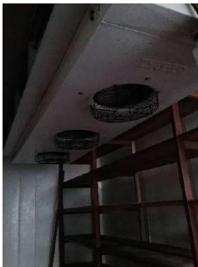
Ilustración 148. Evaporador de aire cuarto frío
