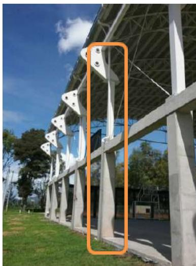
Ilustración 428. Manejo de aguas lluvias Bloque 67
