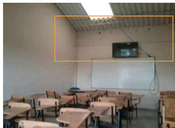
Ilustración 251. Espacios 3 y 4, bloque 42. Fuente. Equipo de diagnóstico.
