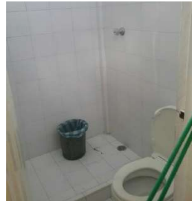
Ilustración 81. Espacios 16 y 18, bloque 13. Fuente. Equipo de diagnóstico
