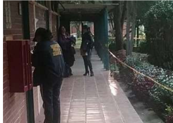
Ilustración 8. Elementos contraincendios, bloque 5. Fuente. Equipo de diagnóstico.
