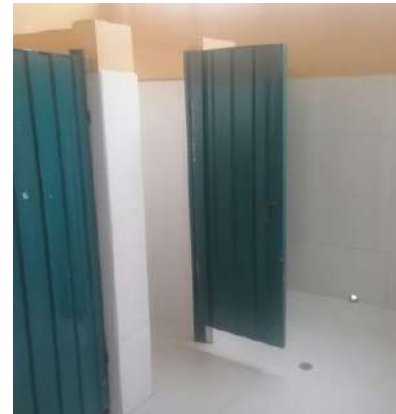
Ilustración 36. Espacios 4 y 5, bloque 9. Fuente. Equipo de diagnóstico.
