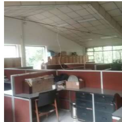
Ilustración 22. Espacios 7 y 8, bloque 8. Fuente. Equipo de diagnóstico.
