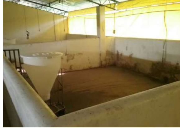
Ilustración 107. Espacios 6 y 7, bloque 16. Fuente. Equipo de diagnóstico.
