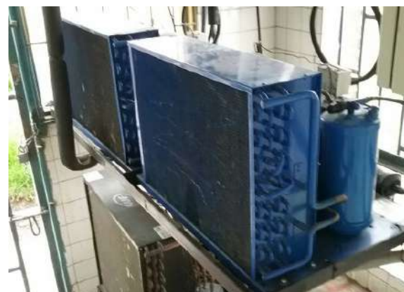
Ilustración 209. Espacios 12 y 14, bloque 33. Fuente. Equipo de diagnóstico.
