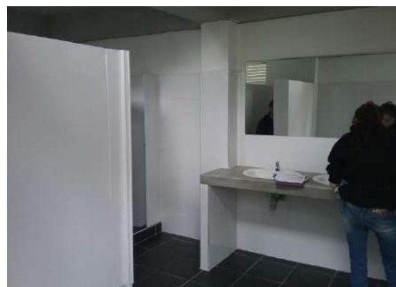
Ilustración 361. Espacios 1 y 2, bloque 67. Fuente. Equipo de diagnóstico.
