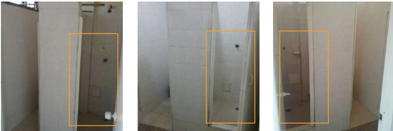
Ilustración 132. Baterías sanitarias dormitorios, bloque 20. Fuente. Equipo de diagnóstico.
