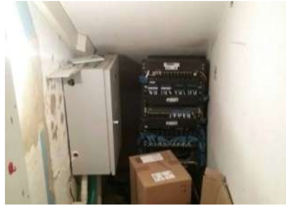
Ilustración 198. Espacios 16 y 17, bloque 32. Fuente: Equipo de diagnóstico.
