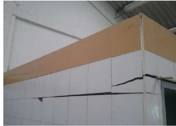
Ilustración 76. Espacios 1 y 2, bloque 13. Fuente. Equipo de diagnóstico.
