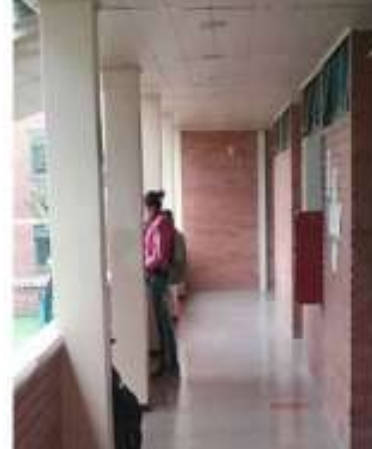
Ilustración 135. Elementos contraincendios bloque 20. Fuente. Equipo de diagnóstico.
