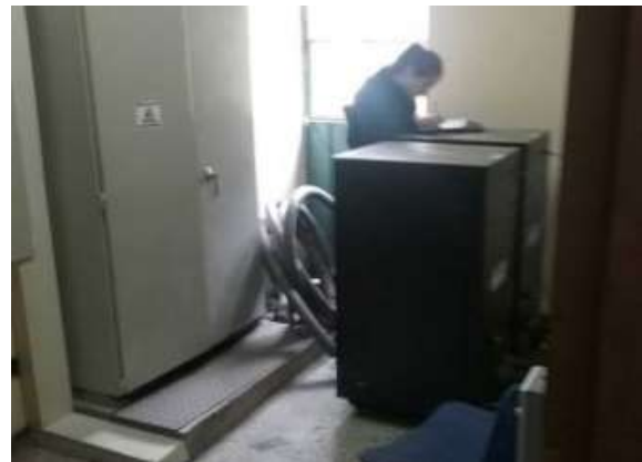
Ilustración 64. Espacios 42 y 29, bloque 12. Fuente. Equipo de diagnóstico.
