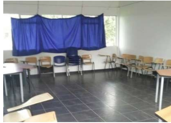
Ilustración 294. Espacio 1 y 2, bloque 50. Fuente. Equipo de diagnóstico.
