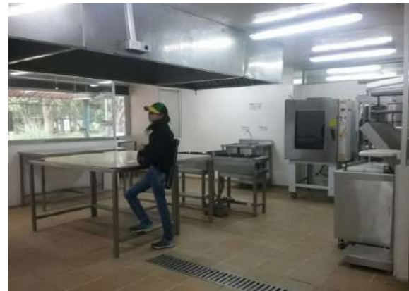
Ilustración 58. Espacios 26 y 27, bloque 12. Fuente. Equipo de diagnóstico.
