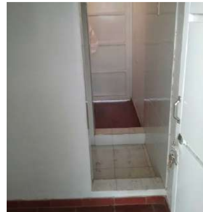
Ilustración 116. Espacios 5, 2 y 4. Bloque 18. Fuente. Equipo de diagnóstico.
