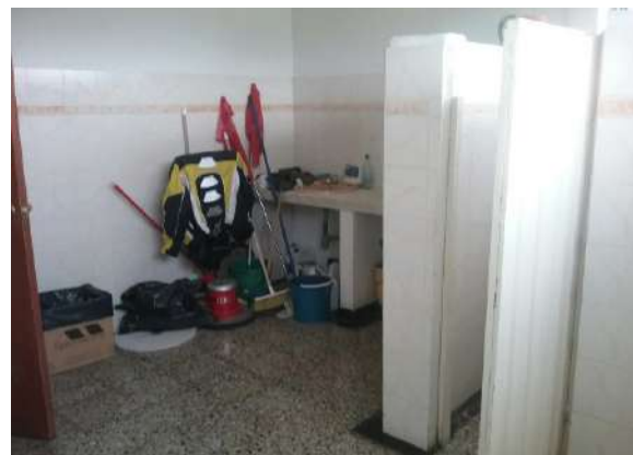
Ilustración 37. Espacios 24 y 25, bloque 9. Fuente. Equipo de diagnóstico.
