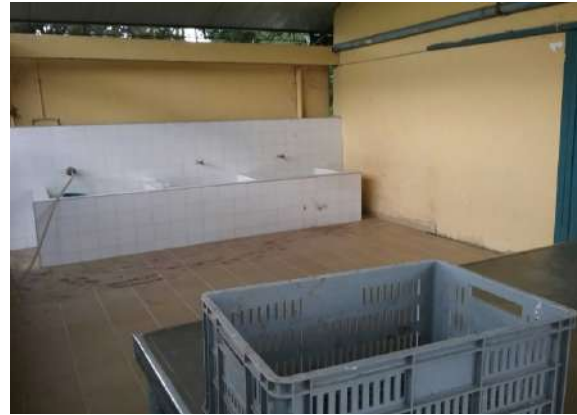
Ilustración 283. Espacios 1 y 8, bloque 48. Fuente. Equipo de diagnóstico.
