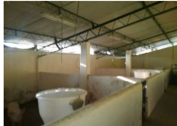
Ilustración 106. Espacios 6 y 7, bloque 16. Fuente. Equipo de diagnóstico.
