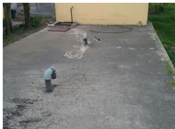
Ilustración 320. Espacios 1 y 2, bloque 56. Fuente. Equipo de diagnóstico.
