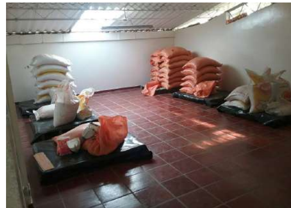
Ilustración 99. Espacios 2 y 3, bloque 15. Fuente. Equipo de diagnóstico.
