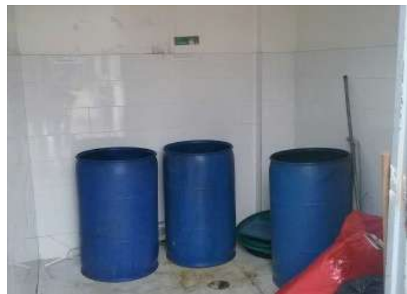
Ilustración 65. Espacios 29 y 42, bloque 12. Fuente. Equipo de diagnóstico.
