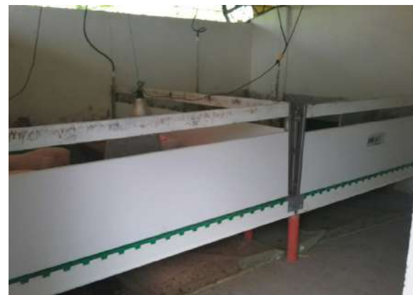
Ilustración 105. Espacio 1 y 5, bloque 16. Fuente. Equipo de diagnóstico.
