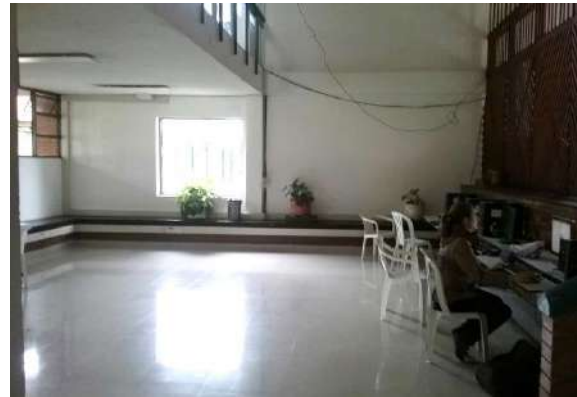
Ilustración 21. Espacios 1 y 2, bloque 8. Fuente. Equipo de diagnóstico.
