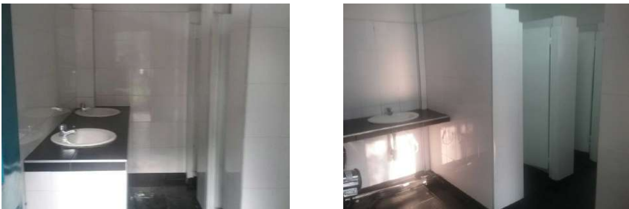
Ilustración 5. Espacios 13 y 14, bloque 5. Fuente. Equipo de diagnóstico.
