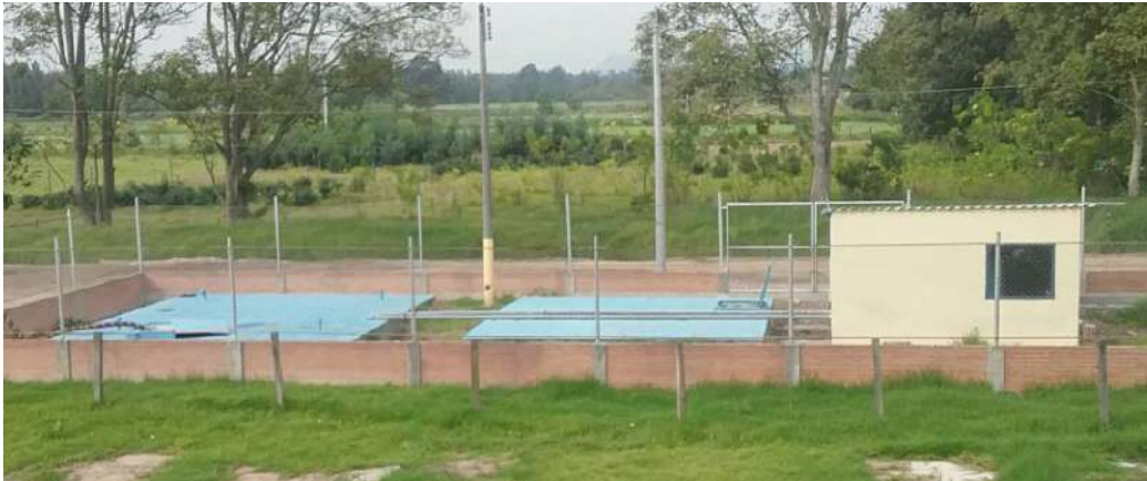
Ilustración 71. Estructura Bloque 7 Fuente. Equipo de diagnóstico
