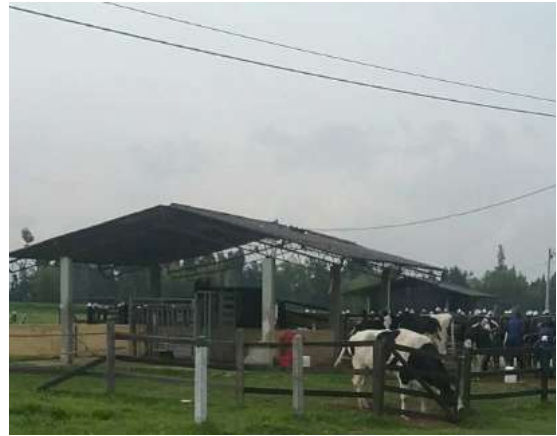
Ilustración 203. Estructura Bloque 46 Fuente. Equipo de diagnóstico
