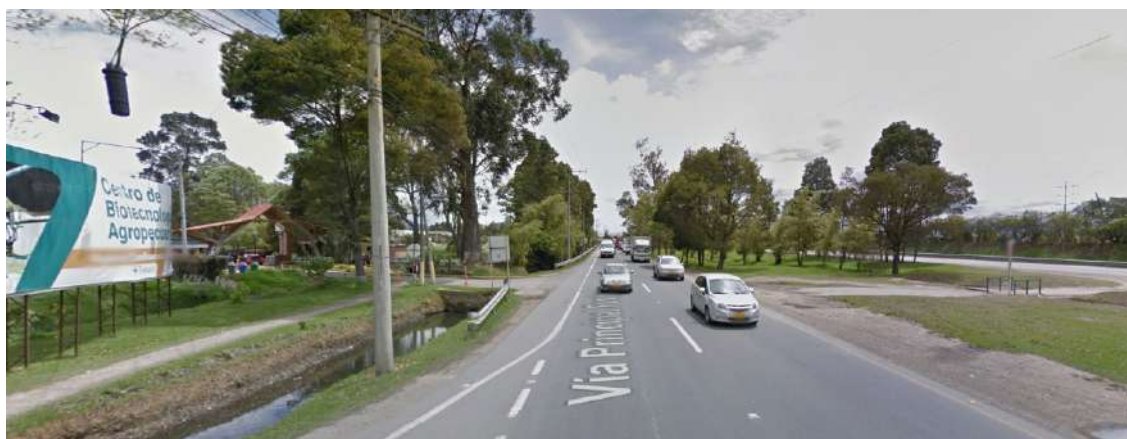
Ilustración 286 Vista acceso al centro, vía principal sentido occidente a oriente. Fuente: Google Maps.
