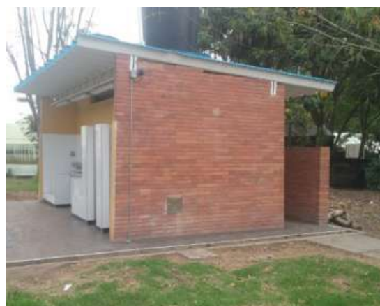
Ilustración 240. Estructura Bloque 60 Fuente. Equipo de diagnóstico
