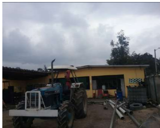
Ilustración 262. Estructura Bloque 68.A Fuente. Equipo de diagnóstico
