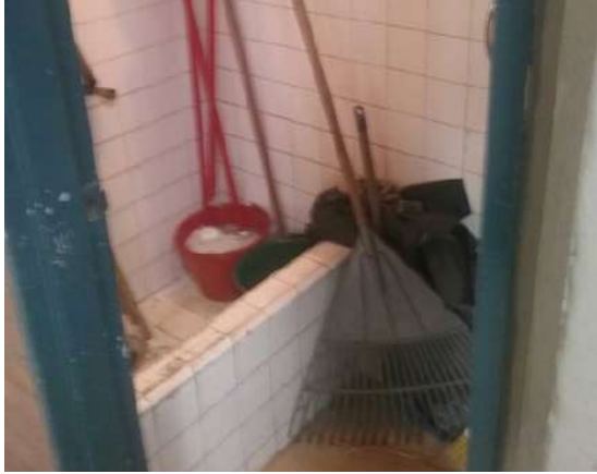
Ilustración 321. Espacio 23. Fuente. Equipo de diagnóstico.
