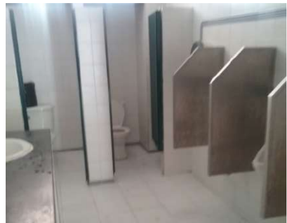
Ilustración 309. Espacios 8 y 9, bloque 3. Fuente. Equipo de diagnóstico.
