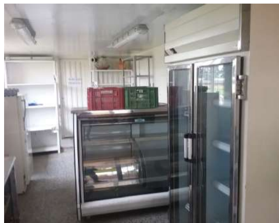
Ilustración 294. Espacios 1 y 3, bloque 1. Fuente. Equipo de diagnóstico.
