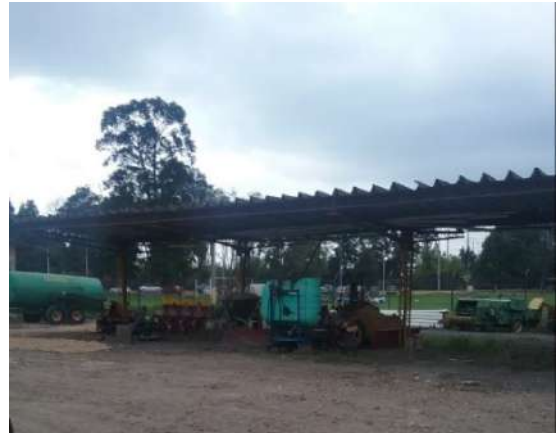
Ilustración 265. Estructura Bloque 68.C Fuente. Equipo de diagnóstico
