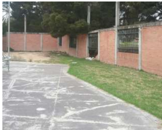
Ilustración 173. Estructura Bloque 37 Fuente. Equipo de diagnóstico
