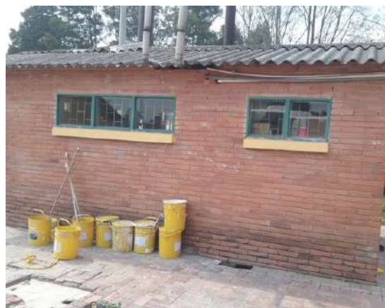
Ilustración 164. Estructura Bloque 34 Fuente. Equipo de diagnóstico
