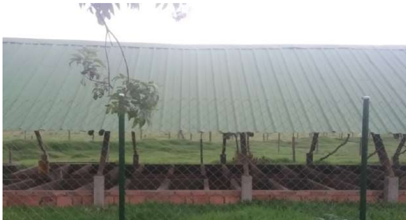
Ilustración 113. Estructura Bloque 17 Fuente. Equipo de diagnóstico
