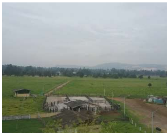
Ilustración 277. Estructura exterior Fuente. Equipo de diagnóstico
