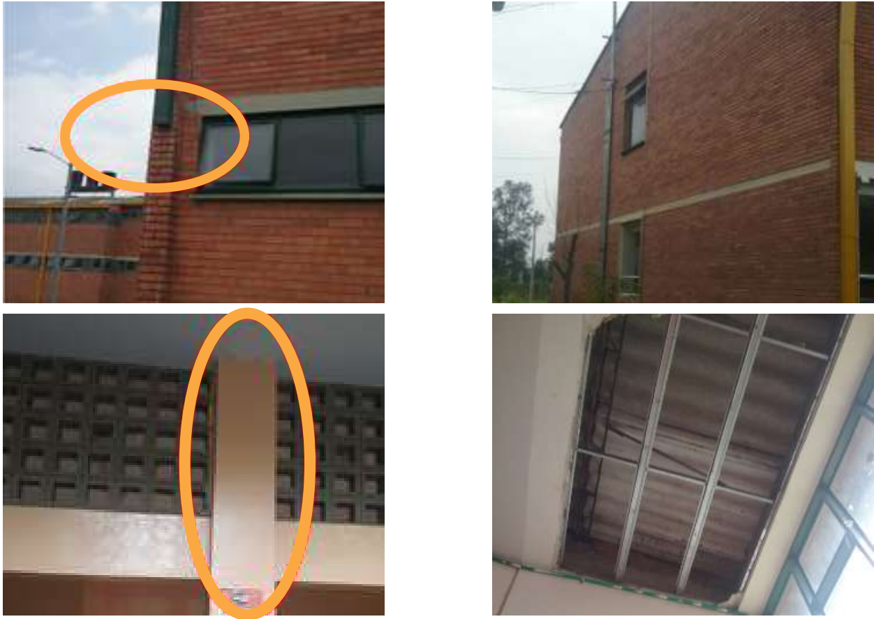
Ilustración 85. Elementos no E Bloque 19 Fuente. Equipo de diagnóstico
