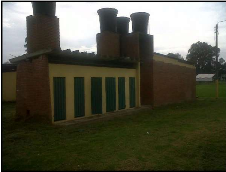
Cimentación - Estado actual
