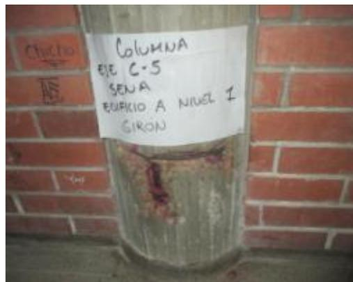
Foto 5 Estructura 8, Piso 1, Columna C-5. Regata, carbonatación.
