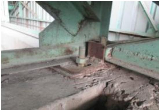
Foto 30 Levantamiento de cubiertas. Pernos de anclaje, corrosión.
