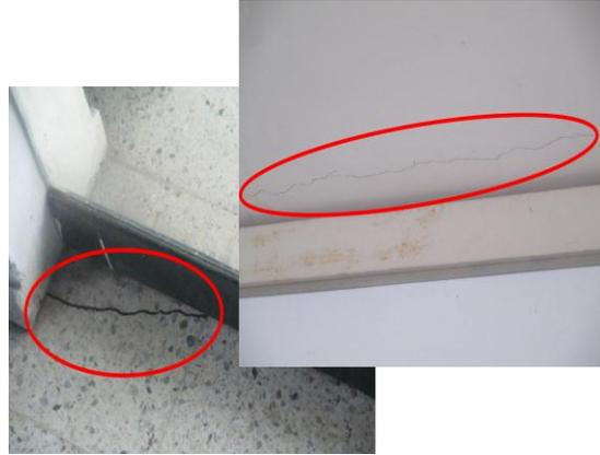
Foto 24. presencia de grietas en pisos y techos
