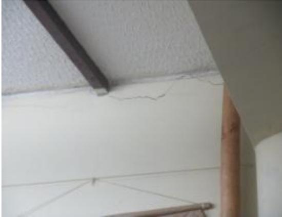
Foto 23 Presencia de grietas en muros
