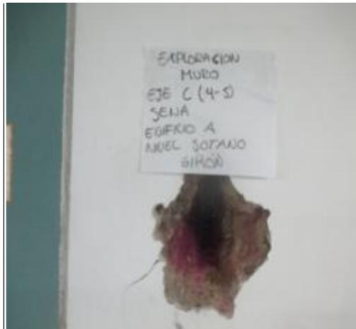
Foto 9 Estructura 8. Nivel sótano, Eje C (4-5). Muro de Contención. Regata y carbonatación.
