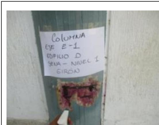
Foto 4 Estructura 2. Piso 1, Columna E-1. Exploración mediante regata, Carbonatación.
