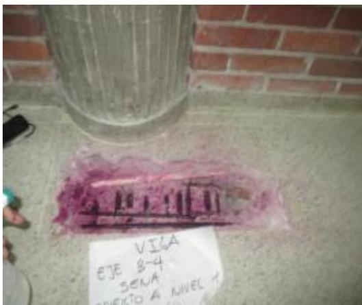
Foto 32 presencia de vigas con sección mayor a la sección de las columnas
