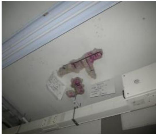
Foto 8 Estructura 8. Piso 2. Regata y carbonatación en Placa.
