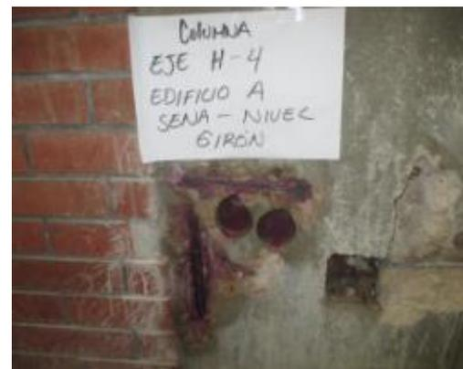
Foto 7 Estructura 8. Piso 1, Eje H-4, Extracción de Núcleo, Regata y carbonatación.
