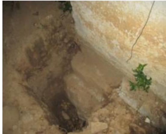
Foto 35 Estructura 9. Cimentación, vigas en concreto ciclópeo.
