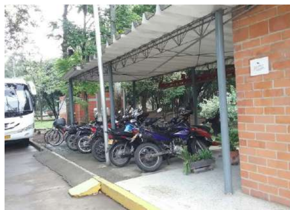
Ilustración 196. Fachadas bloque 22 Fuente. Equipo de diagnóstico
