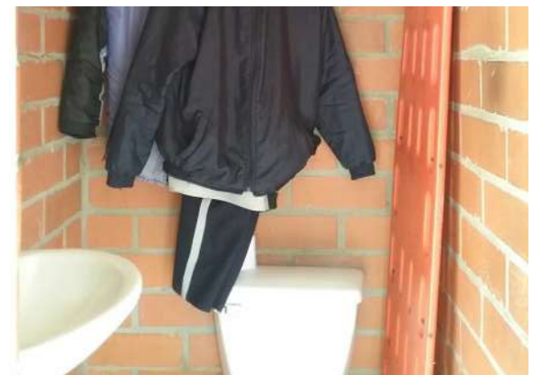
Ilustración 199. Estructura bloque 25 Fuente. Equipo de diagnóstico
