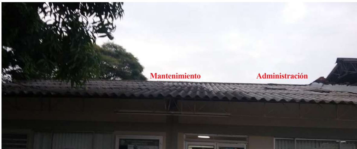
Ilustración 178. Cubierta teja asbesto cemento parte administrativa Fuente. Equipo de diagnóstico
