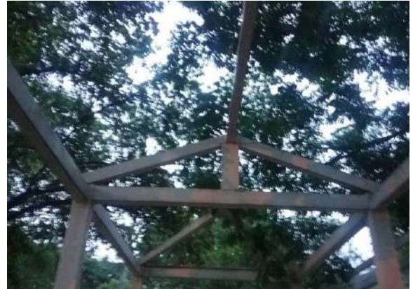
Ilustración 189. Estructura bloque 20 Fuente. Equipo de diagnóstico
