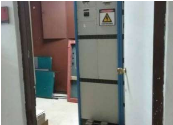
Ilustración 327. Espacio No.19 Fuente. Equipo de diagnóstico
