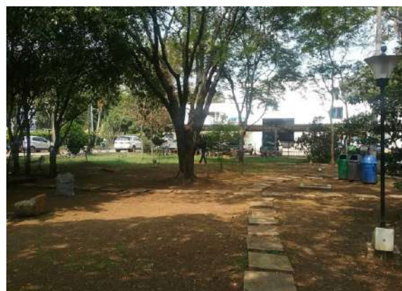
Ilustración 235. Deterioro de placa huella Fuente. Equipo de diagnóstico
