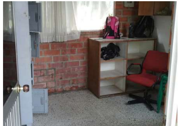
Ilustración 198. Estructura bloque 22 Fuente. Equipo de diagnóstico
