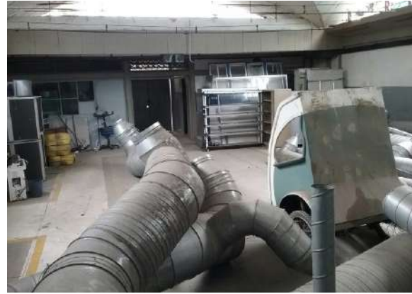
Ilustración 348. Espacio No.10 Fuente. Equipo de diagnóstico
