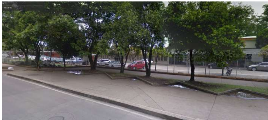
Ilustración 232. Panorámica de cerramiento Fuente. Equipo de diagnóstico
