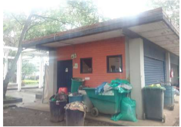
Ilustración 193. Estructura bloque 21 Fuente. Equipo de diagnóstico
