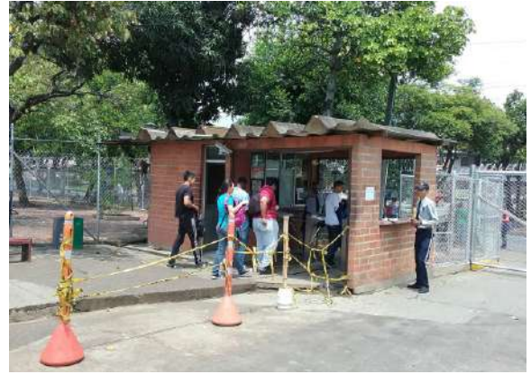
Ilustración 197. Fachadas bloque 25 Fuente. Equipo de diagnóstico
