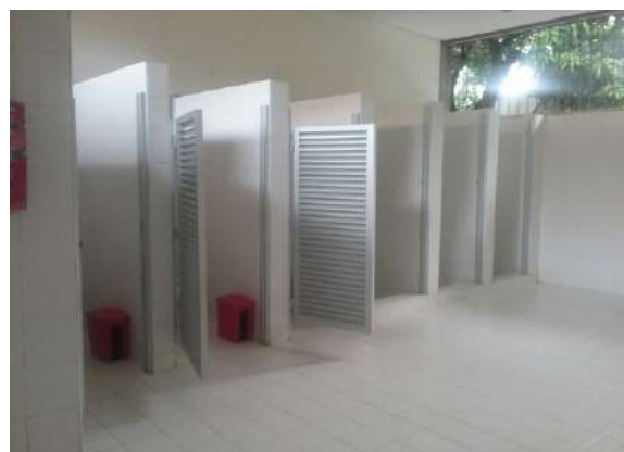
Ilustración 166. Estructura bloque 16 Fuente. Equipo de diagnóstico
