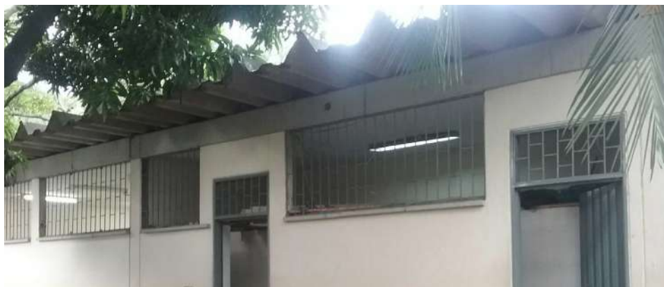
Ilustración 169. Cubierta teja asbesto cemento Fuente. Equipo de diagnóstico
