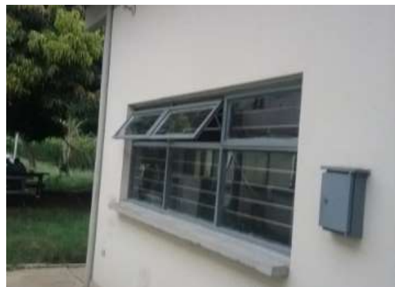
Ilustración 183. Fachadas bloque 19 Fuente. Equipo de diagnóstico
