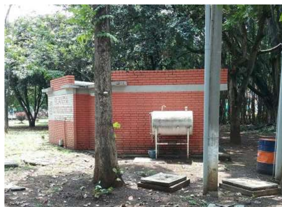
Ilustración 214. Estructura bloque 26 Fuente. Equipo de diagnóstico
