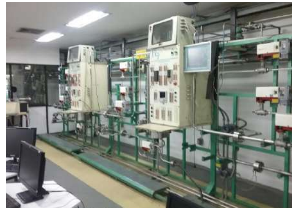
Ilustración 334. Espacio 36. Fuente. Equipo de diagnóstico
