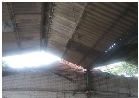
Ilustración 179. Estructura centro de mantenimiento Fuente. Equipo de diagnóstico
