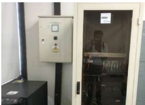
Ilustración 283. Espacio 24. Fuente. Equipo de diagnóstico
