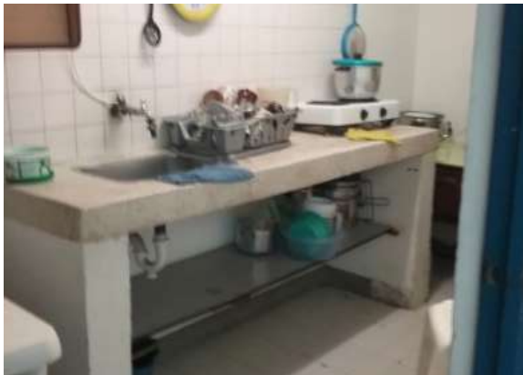
Ilustración 261. Espacio No.13 Fuente. Equipo de diagnóstico
