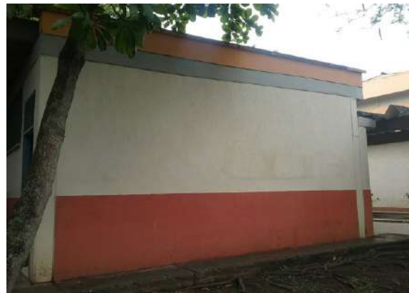
Ilustración 165. Fachadas bloque 16 Fuente. Equipo de diagnóstico
