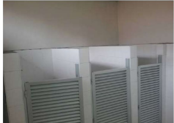
Ilustración 167. Buen estado aparente de la estructura Fuente. Equipo de diagnóstico
