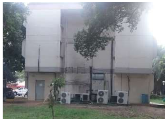
Ilustración 161. Fachadas bloque 15 Fuente. Equipo de diagnóstico
