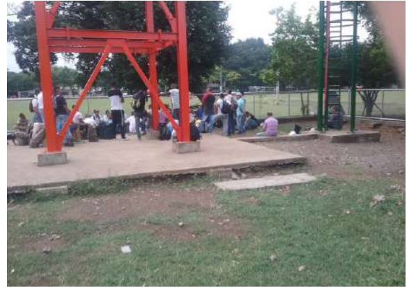
Ilustración 173. Andamio empotrado a placa de concreto
