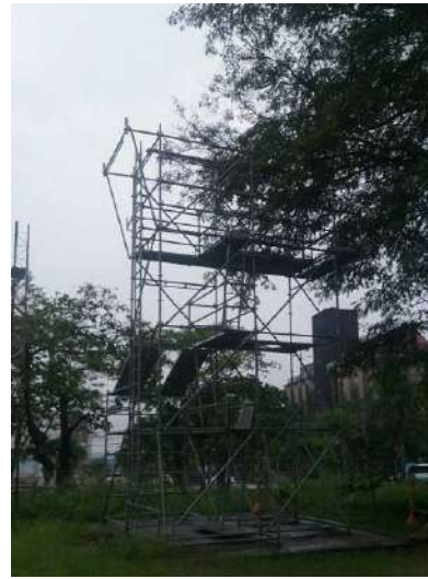
Ilustración 250 Bloque 11 Fuente: Equipo diagnóstico.
