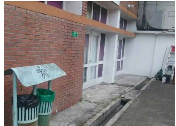
Ilustración 324 Imagen estado de circulación espacio 16. Fuente: Equipo diagnóstico..
