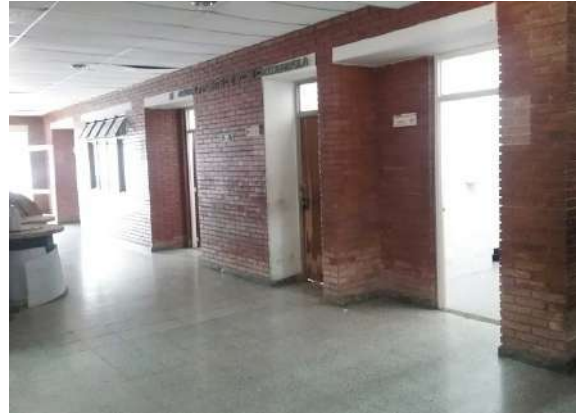
Ilustración 158. Estructura Bloque 28 Fuente. Equipo de diagnóstico
