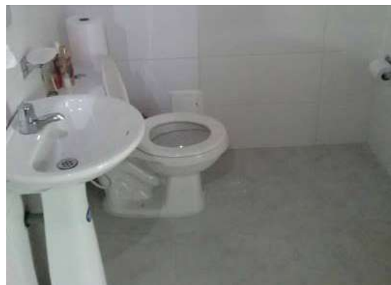
Ilustración 302. Imagen interna espacio 29, bloque 23. Fuente: Equipo diagnóstico
