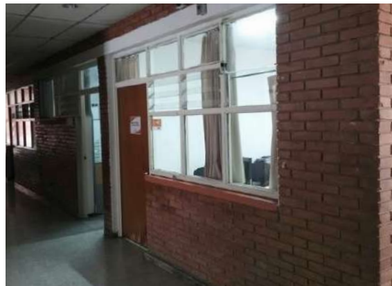
Ilustración 164. Estructura Bloque 29 Fuente. Equipo de diagnóstico
