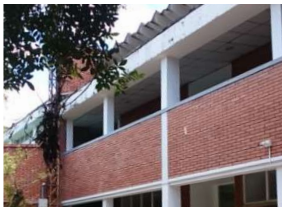
Ilustración 177. Estructura Bloque 32 Fuente. Equipo de diagnóstico
