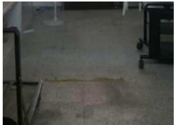
Ilustración 159. Pisos Bloque 28 Fuente. Equipo de diagnóstico
