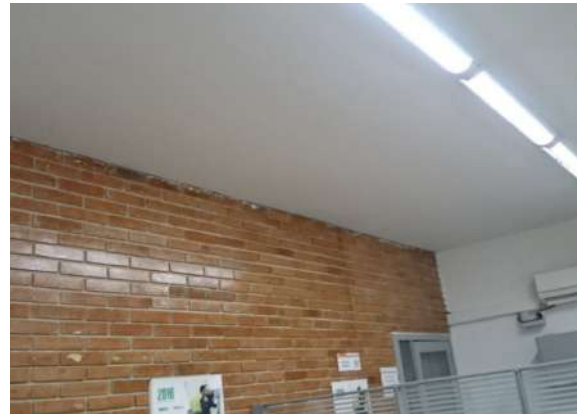
Ilustración 139. Cubierta y entrepisos Bloque 23 Fuente. Equipo de diagnóstico
