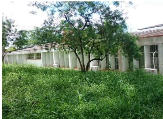
Ilustración 176. Estructura Bloque 31 Fuente. Equipo de diagnóstico
