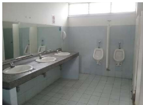
Ilustración 224. Imagen interna espacio 7. Fuente: Equipo de diagnóstico.
