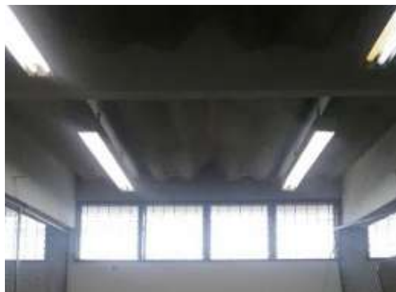
Ilustración 160. Cubierta Bloque 28 Fuente. Equipo de diagnóstico
