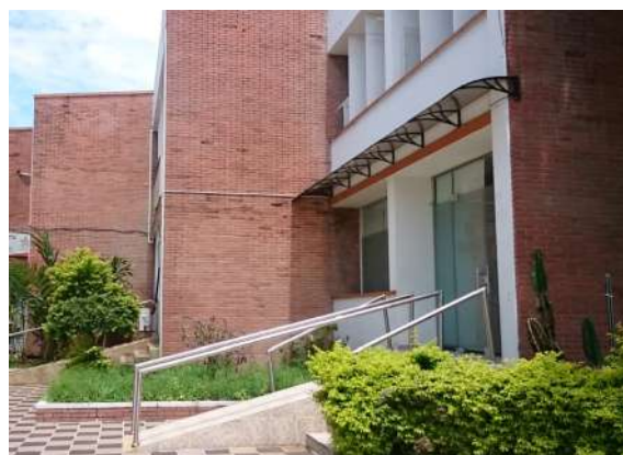
Ilustración 169. Estructura Bloque 30 Fuente. Equipo de diagnóstico
