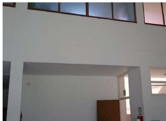
Ilustración 171. Interior Bloque 30 Fuente. Equipo de diagnóstico
