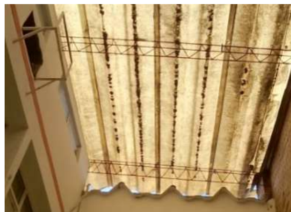
Ilustración 172. Cubierta Bloque 30 Fuente. Equipo de diagnóstico
