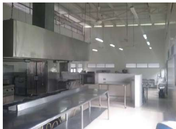
Ilustración 197. Imagen interna espacio 3. Fuente. Equipo de diagnóstico.
