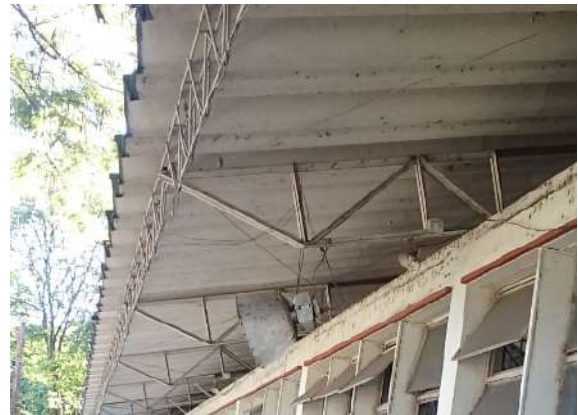
Ilustración 78. Cubierta Bloque 10 Fuente. Equipo de diagnóstico
