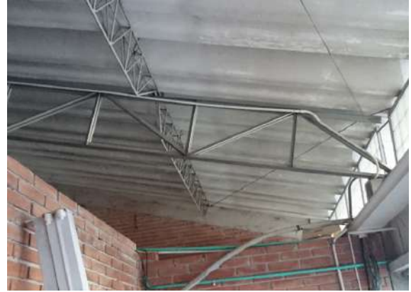
Ilustración 57. Cubierta Bloque 6 Fuente. Equipo de diagnóstico
