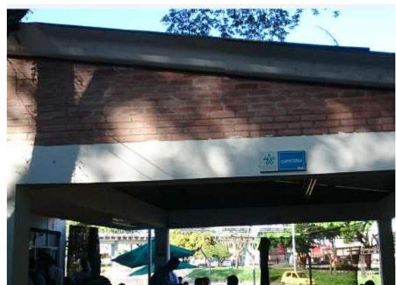
Ilustración 63. Cubierta Bloque 7 Fuente. Equipo de diagnóstico
