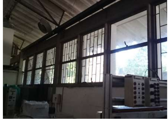
Ilustración 67. Interior Bloque 8 Fuente. Equipo de diagnóstico
