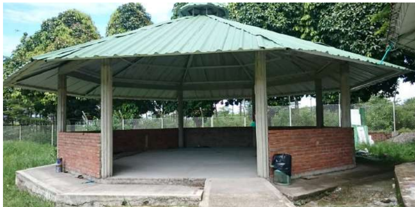
Ilustración 109. Estructura Bloque 17 Fuente. Equipo de diagnóstico
