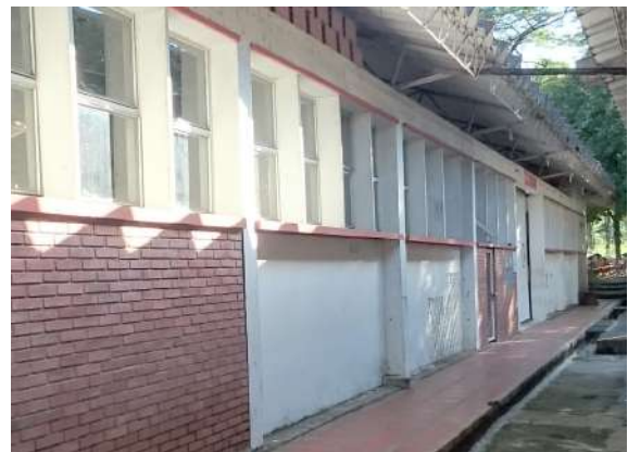
Ilustración 74. Estructura Bloque 10 Fuente. Equipo de diagnóstico
