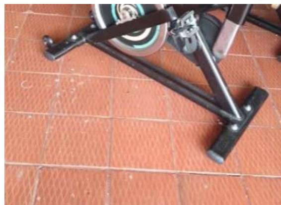
Ilustración 112. Pisos Bloque 17 Fuente. Equipo de diagnóstico
