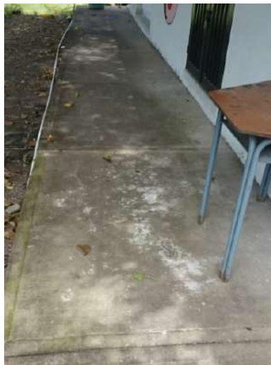
Ilustración 126. Andenes perimetrales Bloque 21 Fuente. Equipo de diagnóstico
