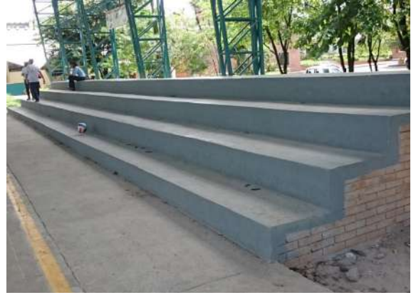
Ilustración 105. Gradería Bloque 16 Fuente. Equipo de diagnóstico
