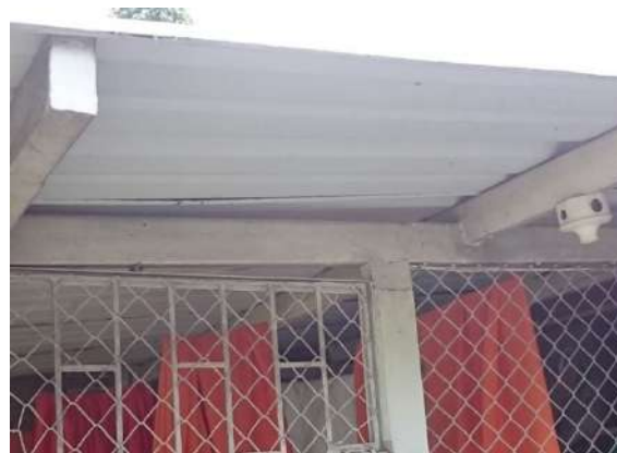
Ilustración 133. Cubierta Bloque 22 Fuente. Equipo de diagnóstico
