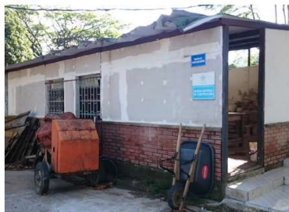
Ilustración 92. Estructura Bloque 14 Fuente. Equipo de diagnóstico
