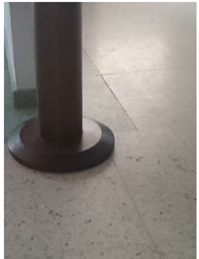
Ilustración 37. Pisos Bloque 2 Fuente. Equipo de diagnóstico
