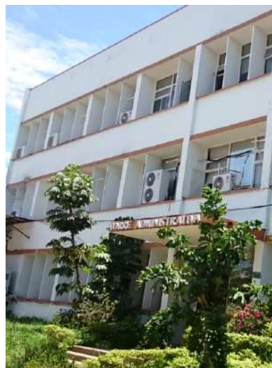
Ilustración 136. Estructura Bloque 23 Fuente. Equipo de diagnóstico
