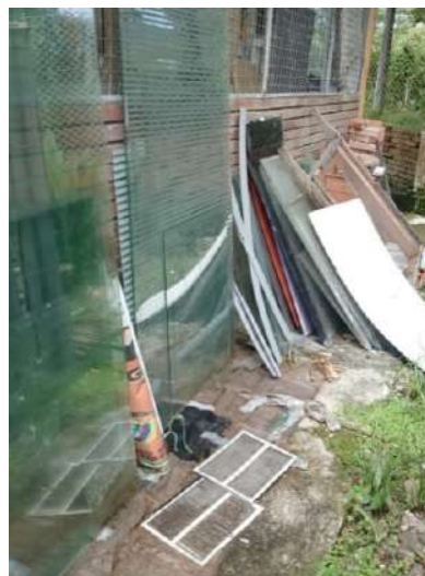
Ilustración 117. Andenes perimetrales Bloque 19 Fuente. Equipo de diagnóstico
