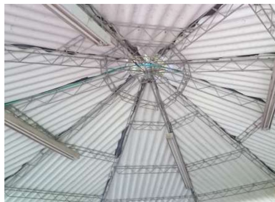
Ilustración 113. Cubierta Bloque 17 y 18 Fuente. Equipo de diagnóstico
