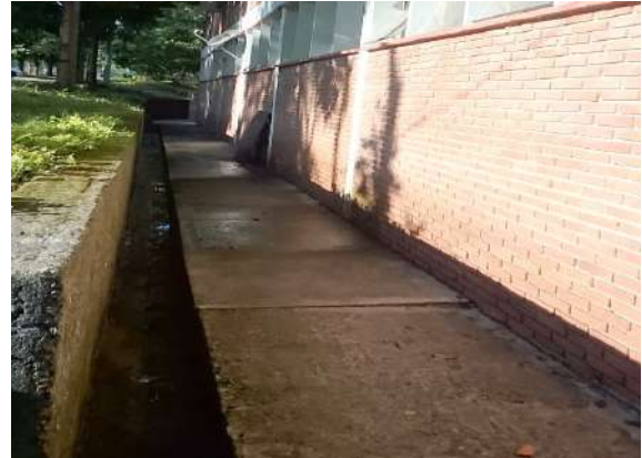
Ilustración 53. Andenes perimetrales Bloque 6 Fuente. Equipo de diagnóstico
