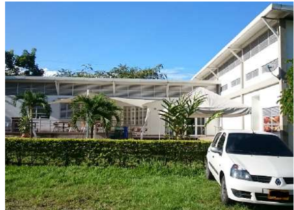
Ilustración 35. Estructura Bloque 2 Fuente. Equipo de diagnóstico
