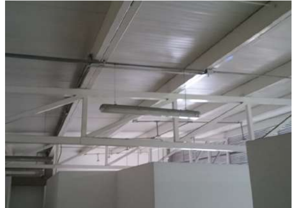
Ilustración 38. Cubierta Bloque 2 Fuente. Equipo de diagnóstico
