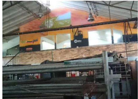
Ilustración 76. Interior Bloque 10 Fuente. Equipo de diagnóstico
