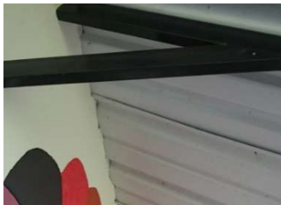
Ilustración 128. Cubierta Bloque 21 Fuente. Equipo de diagnóstico
