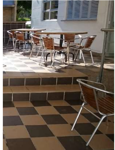
Ilustración 36. Andenes perimetrales Bloque 2 Fuente. Equipo de diagnóstico
