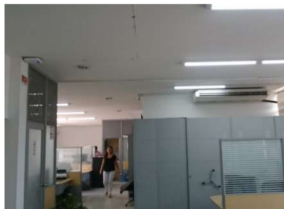
Ilustración 137. Interior Bloque 23 Fuente. Equipo de diagnóstico
