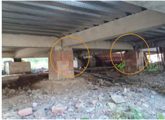
Ilustración 101. Pedestales en bloque estructuras Bloque 15 Fuente. Equipo de diagnóstico
