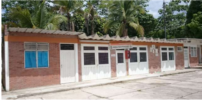
Ilustración 130. Estructura Bloque 22 Fuente. Equipo de diagnóstico
