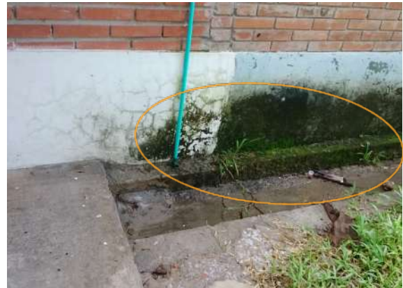
Ilustración 131. Andenes perimetrales Bloque 22 Fuente. Equipo de diagnóstico
