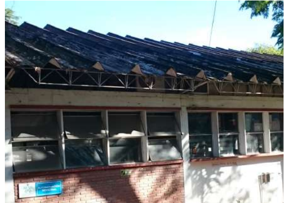
Ilustración 69. Cubierta Bloque 8 Fuente. Equipo de diagnóstico
