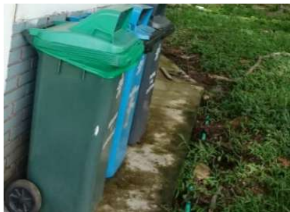
Ilustración 111. Andenes perimetrales Bloque 17 Fuente. Equipo de diagnóstico
