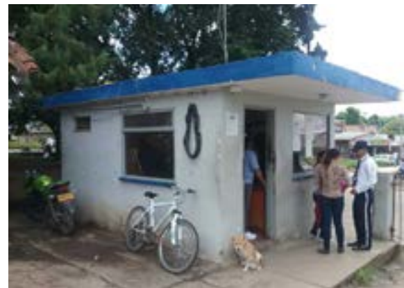
Ilustración 361. Bloque 103. Fuente. Equipo diagnóstico
