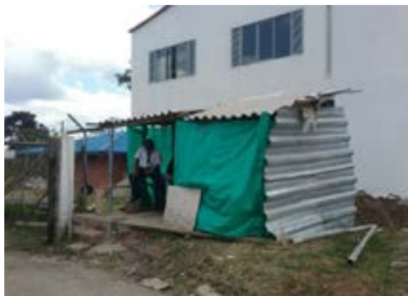
Ilustración 476. Bloque 126. Fuente. Equipo diagnóstico
