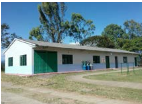
Ilustración 498. Bloque 130. Fuente. Equipo diagnóstico
