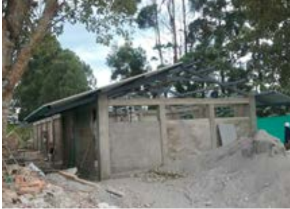
Ilustración 152. Bloque 29 A (En obra). Fuente. Equipo diagnóstico
