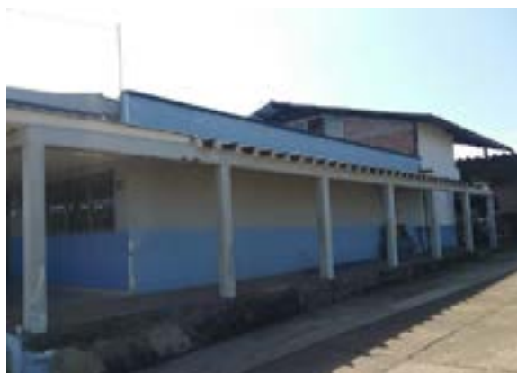
Ilustración 335. Bloque 102. Fuente. Equipo diagnóstico
