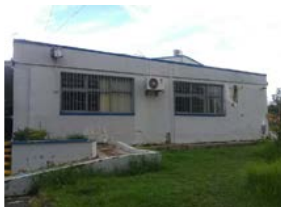
Ilustración 305. Bloque 101. Fuente. Equipo diagnóstico
