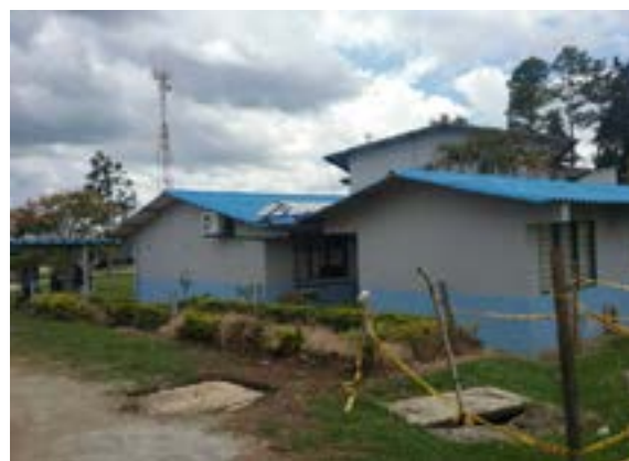
Ilustración 383. Bloque 108. Fuente. Equipo diagnóstico
