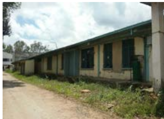
Ilustración 447. Bloque 122. Fuente. Equipo diagnóstico
