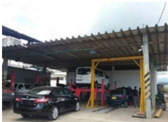
Ilustración 530. Bloque 138. Fuente. Equipo diagnóstico
