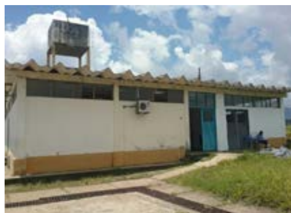
Ilustración 520. Bloque 136. Fuente. Equipo diagnóstico
