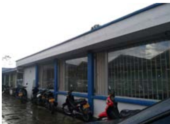
Ilustración 304. Bloque 101. Fuente. Equipo diagnóstico
