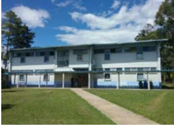
Ilustración 390. Bloque 109. Fuente. Equipo diagnóstico
