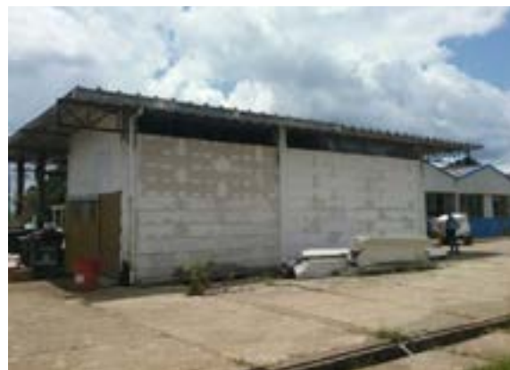
Ilustración 531. Bloque 138. Fuente. Equipo diagnóstico
