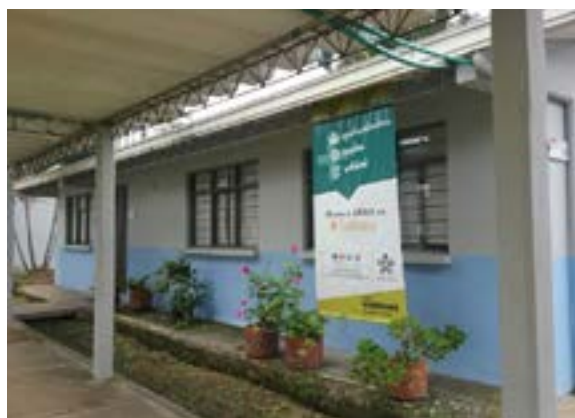
Ilustración 382. Bloque 108. Fuente. Equipo diagnóstico
