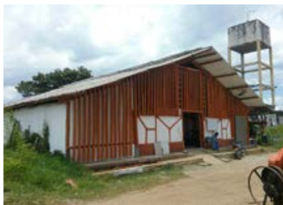
Ilustración 510. Bloque 133. Fuente. Equipo diagnóstico
