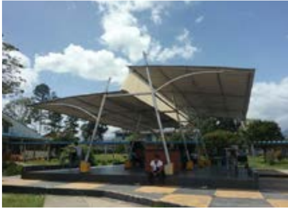
Ilustración 434. Bloque 119. Fuente. Equipo diagnóstico
