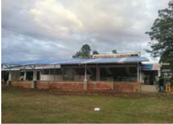
Ilustración 402. Bloque 110. Fuente. Equipo diagnóstico
