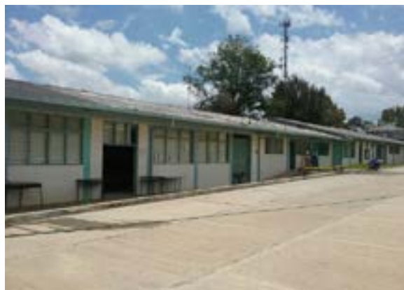
Ilustración 446. Bloque 122. Fuente. Equipo diagnóstico
