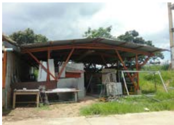
Ilustración 516. Bloque 134. Fuente. Equipo diagnóstico
