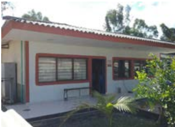
Ilustración 489. Bloque 129. Fuente. Equipo diagnóstico
