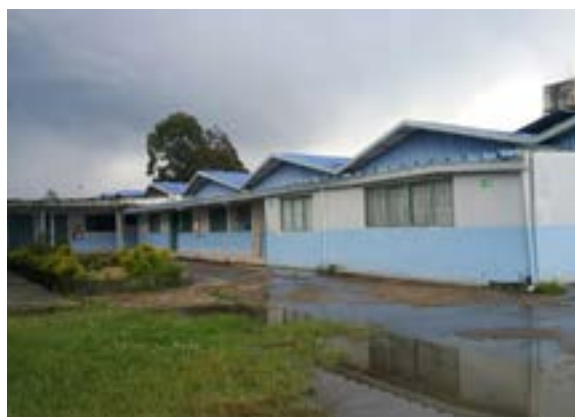
Ilustración 373. Bloque 107. Fuente. Equipo diagnóstico
