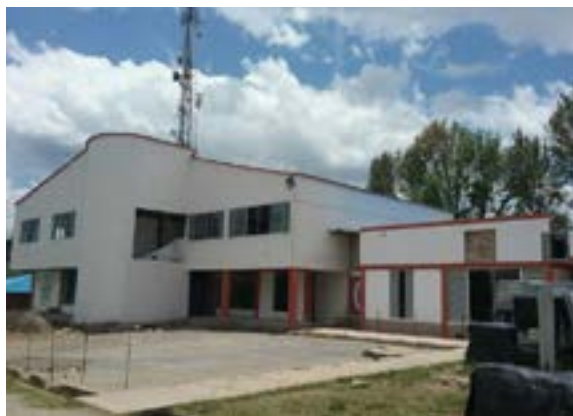
Ilustración 468. Bloque 124. Fuente. Equipo diagnóstico
