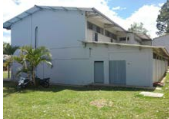
Ilustración 391. Bloque 109. Fuente. Equipo diagnóstico
