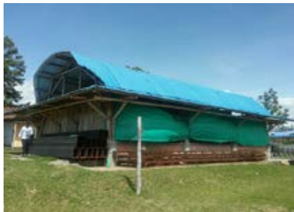
Ilustración 427. Bloque 116. Fuente. Equipo diagnóstico
