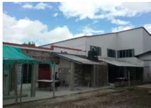
Ilustración 469. Bloque 124. Fuente. Equipo diagnóstico
