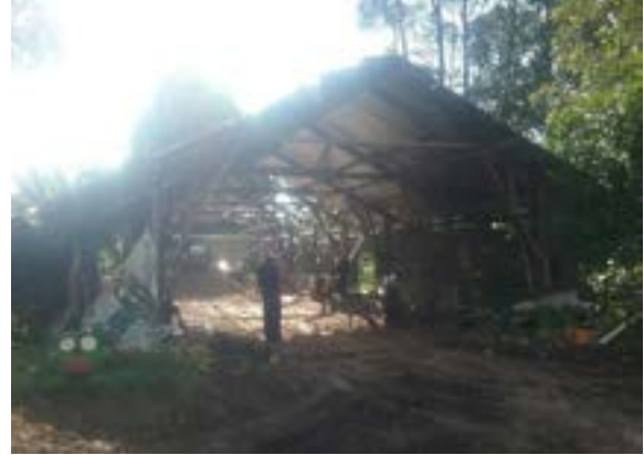
Ilustración 153. Bloque 29 A (En obra). Fuente. Equipo diagnóstico
