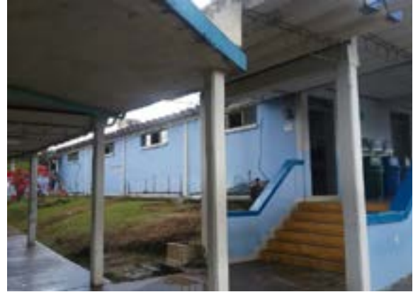
Ilustración 307. Bloque 101. Fuente. Equipo diagnóstico
