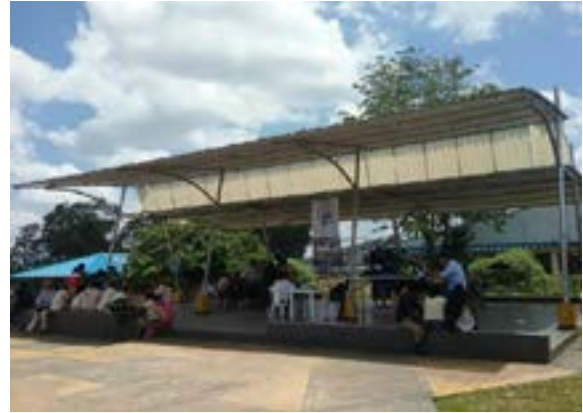
Ilustración 435. Bloque 119. Fuente. Equipo diagnóstico
