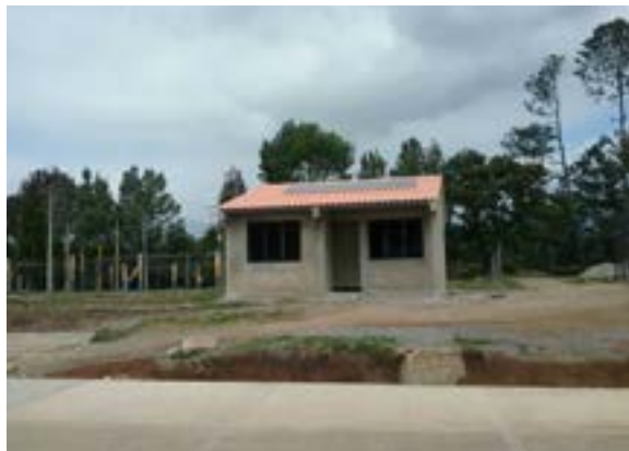
Ilustración 444. Bloque 121. Fuente. Equipo diagnóstico
