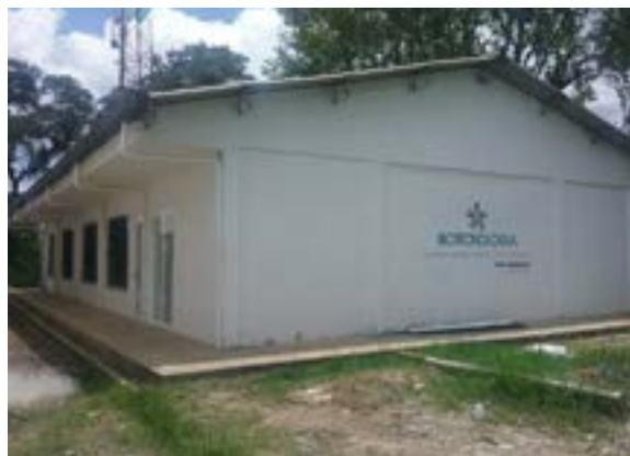
Ilustración 478. Bloque 127. Fuente. Equipo diagnóstico
