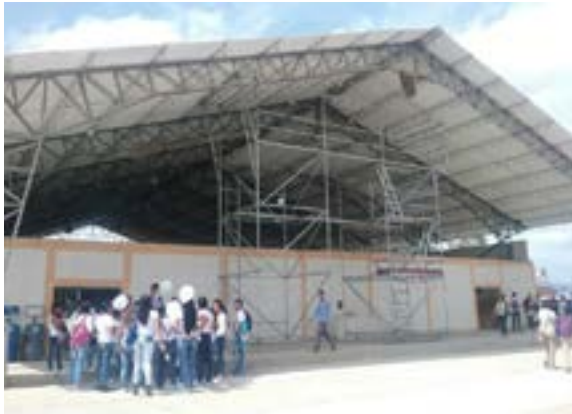
Ilustración 464. Bloque 123. Fuente: Equipo diagnóstico
