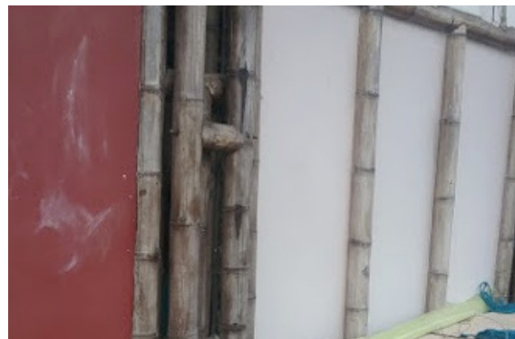
Ilustración 319. Estructura Bloque 45 Fuente. Equipo de diagnóstico
