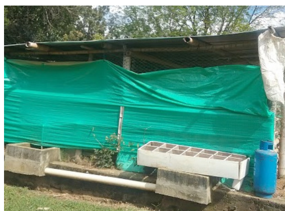
Ilustración 325. Estructura Bloque 43 Fuente. Equipo de diagnóstico
