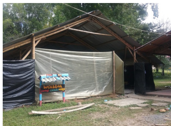
Ilustración 341 Fachadas bloque 53 y 54 Fuente. Equipo de diagnóstico
