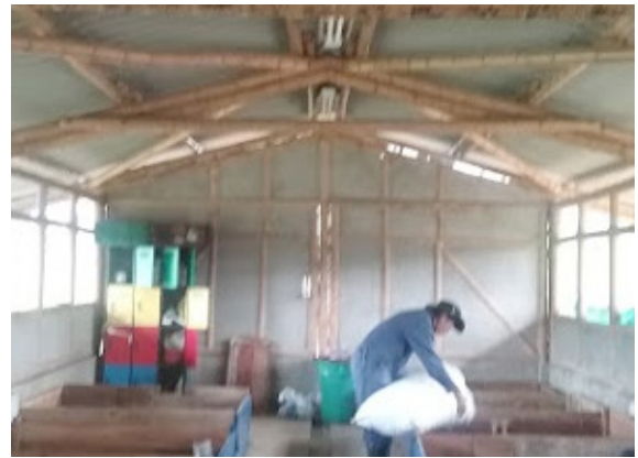
Ilustración 318. Estructura Bloque 41 Fuente. Equipo de diagnóstico
