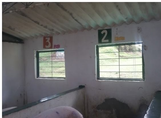
Ilustración 322. Estructura Bloque 42 Fuente. Equipo de diagnóstico
