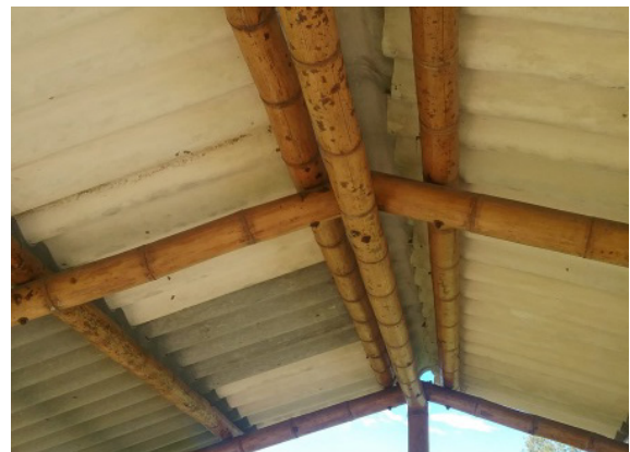
Ilustración 334 Estructura bloque 49 Fuente. Equipo de diagnóstico
