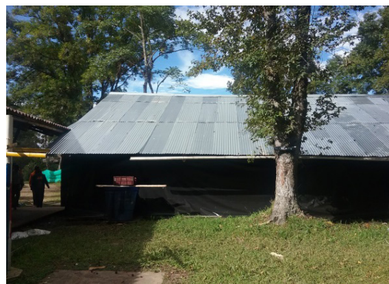
Ilustración 345 Cubierta bloque 54 Fuente. Equipo de diagnóstico
