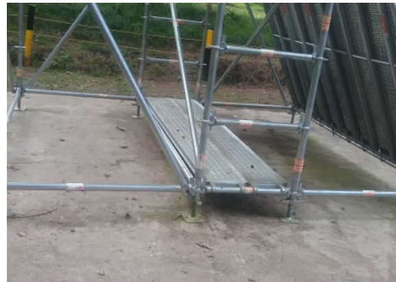
Ilustración 347 Estructura bloque 55 Fuente. Equipo de diagnóstico
