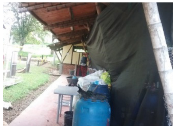
Ilustración 344 Estructura de cubierta bloque 53 Fuente. Equipo de diagnóstico
