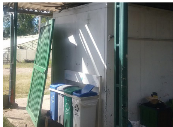
Ilustración 328 Fachada bloque 48 Fuente. Equipo de diagnóstico
