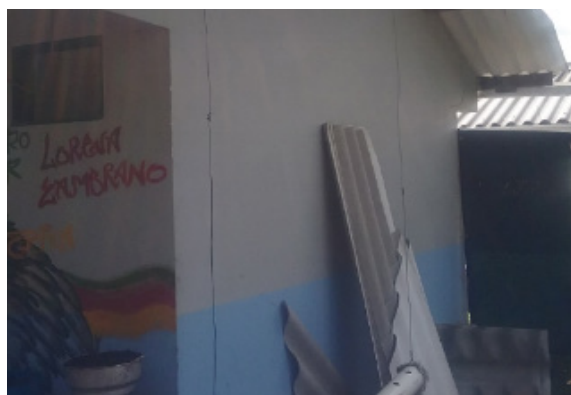
Ilustración 330 Estructura de cubierta bloque 48 Fuente. Equipo de diagnóstico
