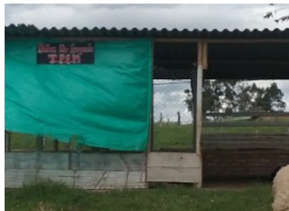
Ilustración 324. Estructura Bloque 43 Fuente. Equipo de diagnóstico
