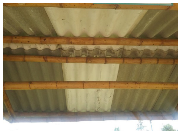
Ilustración 351 Cubierta bloques 56 y 57 Fuente. Equipo de diagnóstico
