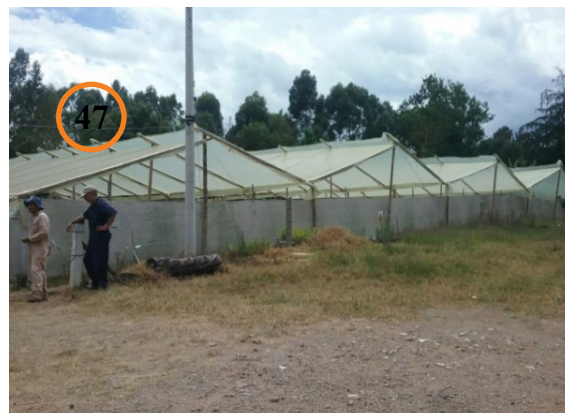
Ilustración 327. Estructura Bloque 44, 46 y 47 Fuente. Equipo de diagnóstico
