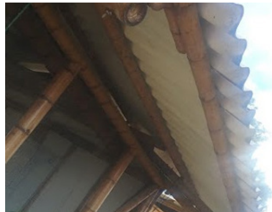
Ilustración 316. Estructura Bloque 39 Fuente. Equipo de diagnóstico
