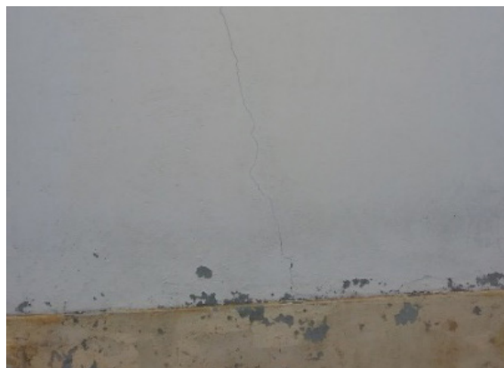
Ilustración 187 Estructura bloque 136 Fuente. Equipo de diagnóstico
