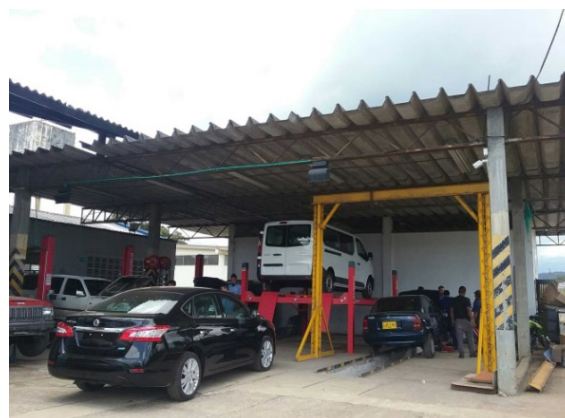
Ilustración 193. Estructura Bloque 138 Fuente. Equipo de diagnóstico
