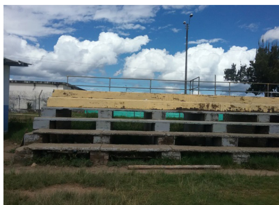
Ilustración 197 Estructura bloques 1 y 3 Fuente. Equipo de diagnóstico
