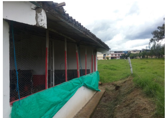
Ilustración 218 Estructura bloque 8 Fuente. Equipo de diagnóstico
