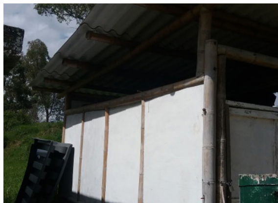
Ilustración 209 Estructura bloque 5 Fuente. Equipo de diagnóstico
