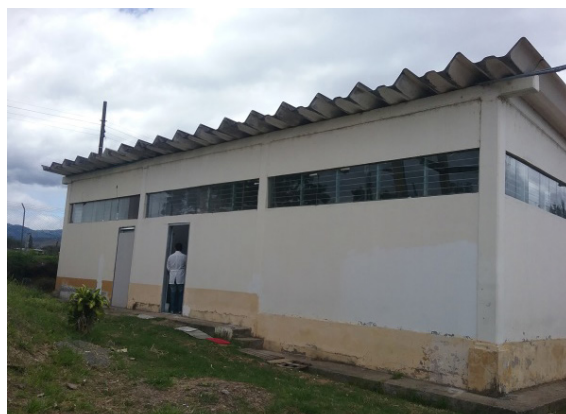
Ilustración 189 Estructura de cubierta Fuente. Equipo de diagnóstico
