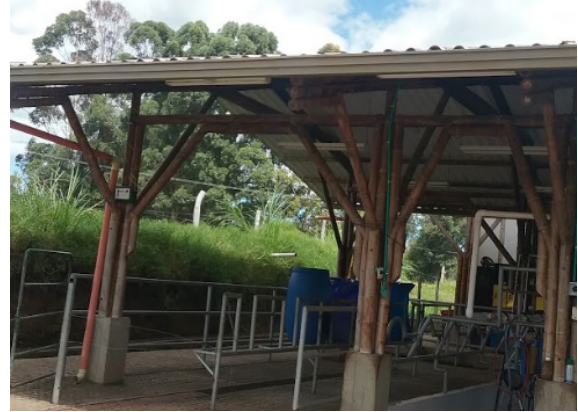
Ilustración 181. Estructura Bloque 134 Fuente. Equipo de diagnóstico
