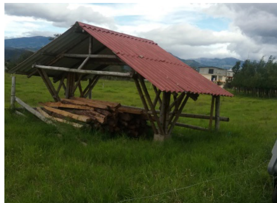
Ilustración 215 Estructura bloque 7 Fuente. Equipo de diagnóstico
