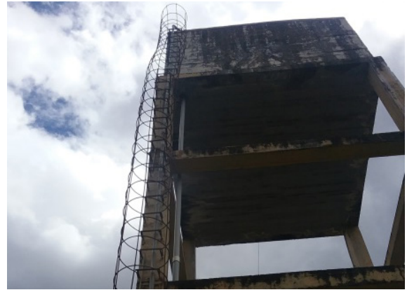
Ilustración 184 Estructura bloque 34 Fuente. Equipo de diagnóstico
