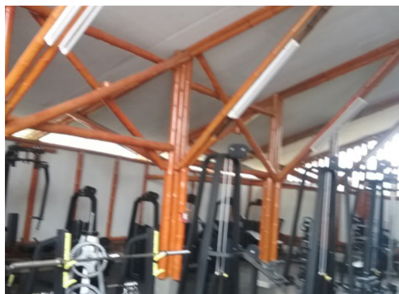
Ilustración 178 Estructura bloque 133 Fuente. Equipo de diagnóstico
