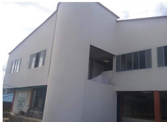
Ilustración 148. Fachadas bloque 124 Fuente. Equipo de diagnóstico
