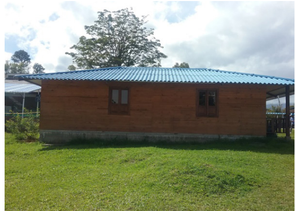
Ilustración 131 Estructura bloque 120 Fuente. Equipo de diagnóstico
