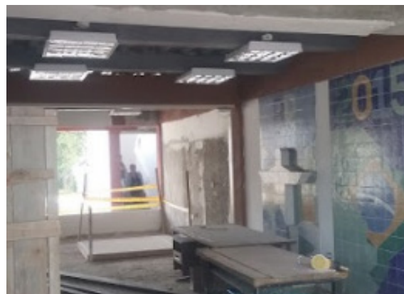
Ilustración 150. Estructura bloque 124 Fuente. Equipo de diagnóstico
