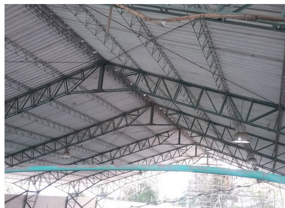
Ilustración 142. Estructura bloque 123 Fuente. Equipo de diagnóstico
