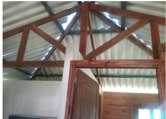
Ilustración 132 Estructura de cubierta Fuente. Equipo de diagnóstico
