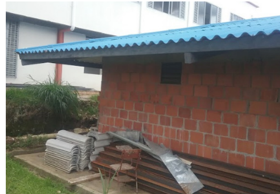
Ilustración 161. Cubierta bloque 128 Fuente. Equipo de diagnóstico
