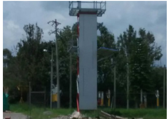
Ilustración 152 Estructura bloque 125 Fuente. Equipo de diagnóstico
