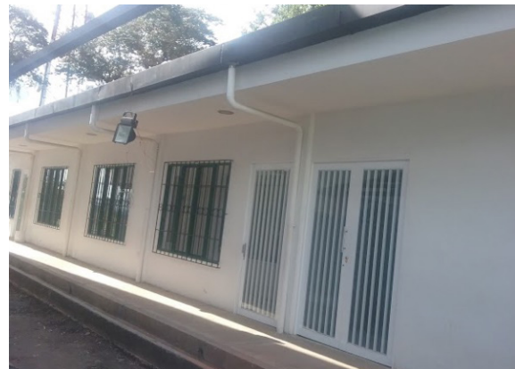
Ilustración 156. Fachada Bloque 127 Fuente. Equipo de diagnóstico
