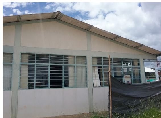
Ilustración 138. Estructura Bloque 122 Fuente. Equipo de diagnóstico
