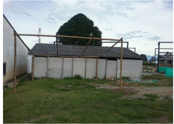
Ilustración 109 Estructura de cubierta bloque 114 Fuente. Equipo de diagnóstico
