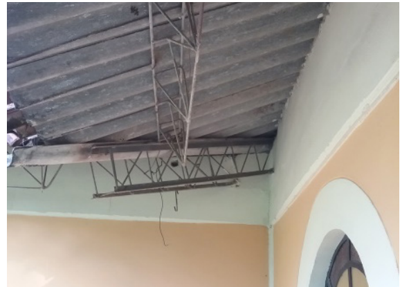
Ilustración 120 Estructura de cubierta bloque 117 Fuente. Equipo de diagnóstico
