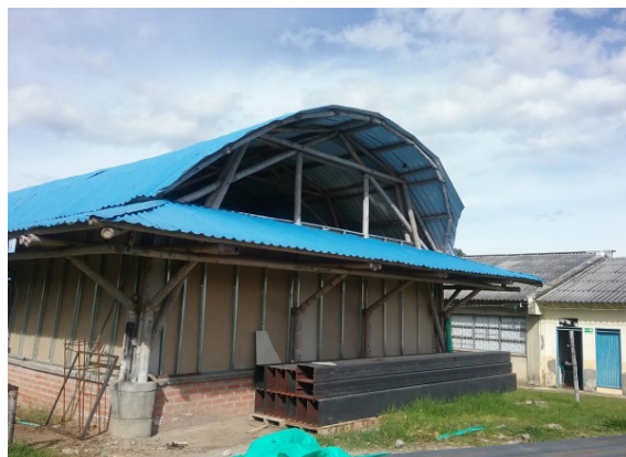
Ilustración 115 Estructura bloque 116 Fuente. Equipo de diagnóstico
