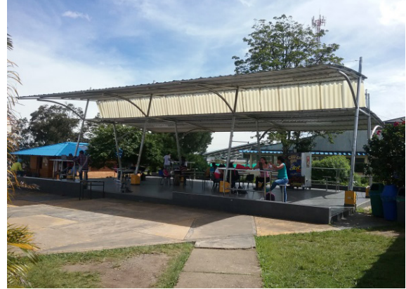
Ilustración 127 Estructura bloque 119 Fuente. Equipo de diagnóstico
