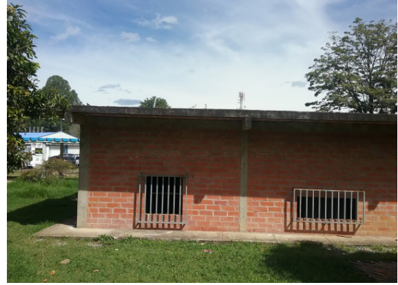
Ilustración 123 Estructura bloque 118 Fuente. Equipo de diagnóstico
