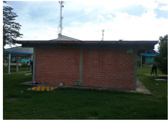
Ilustración 124 Estructura de cubierta bloque 118 Fuente. Equipo de diagnóstico
