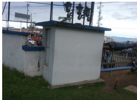
Ilustración 97 Estructura bloque 111 Fuente. Equipo de diagnóstico
