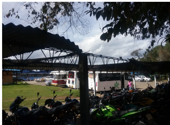
Ilustración 102 Estructura de cubierta bloque 112 Fuente. Equipo de diagnóstico
