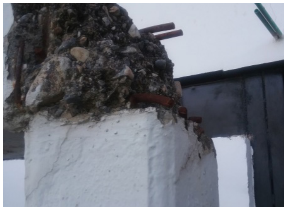
Ilustración 59 Entrepiso de madera y estructura de concreto exterior Fuente. Equipo de diagnóstico
