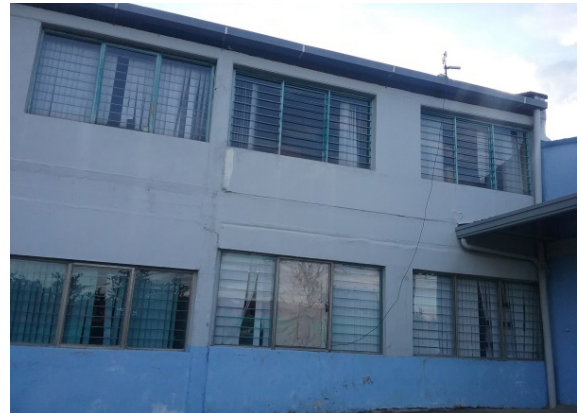
Ilustración 49 Estructura Bloque n. 101 y 107 Fuente. Equipo de diagnóstico
