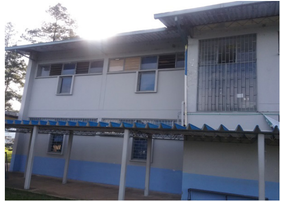
Ilustración 86 Estructura bloque 9 Fuente. Equipo de diagnóstico
