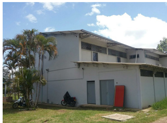
Ilustración 88 Estructura de cubierta Fuente. Equipo de diagnóstico
