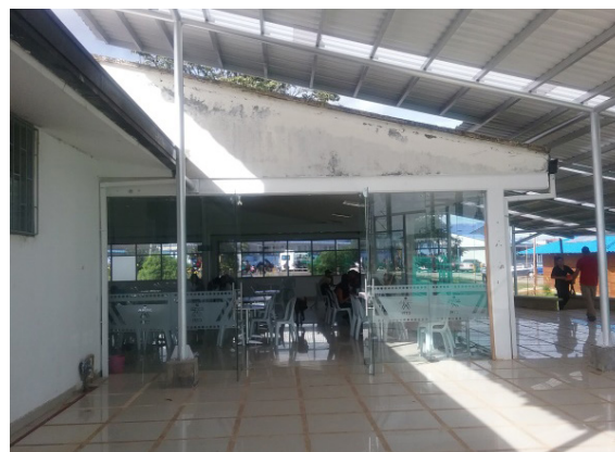
Ilustración 94 Estructura de cubierta parte exterior de la cafetería Fuente. Equipo de diagnóstico
