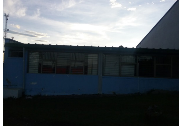
Ilustración 48. Fachadas bloque 101 y 107 Fuente. Equipo de diagnóstico
