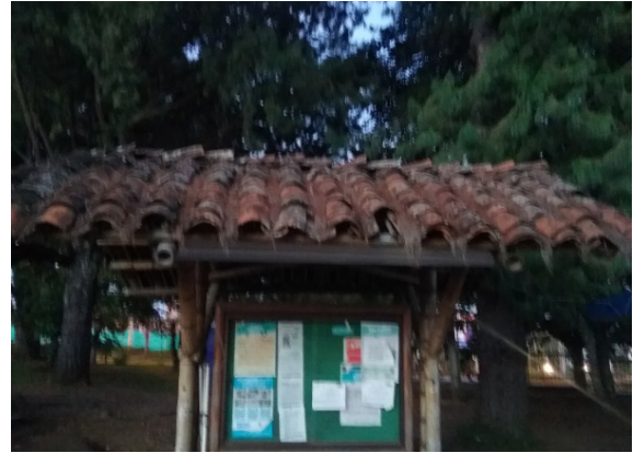
Ilustración 71 Estructura de cubierta bloque104 Fuente. Equipo de diagnóstico
