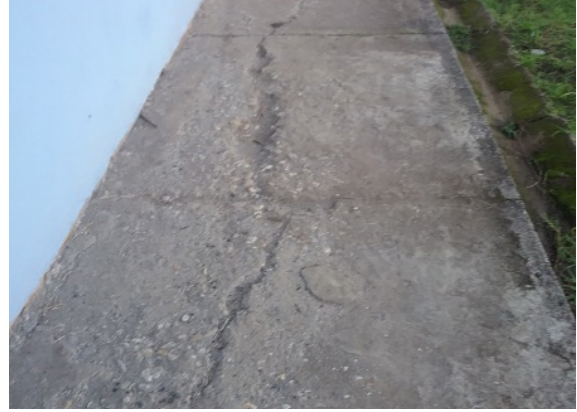
Ilustración 50 Evidencia de fisuras y/o grietas en placa de contrapiso, elementos estructurales y no estructurales Fuente. Equipo de diagnóstico.
