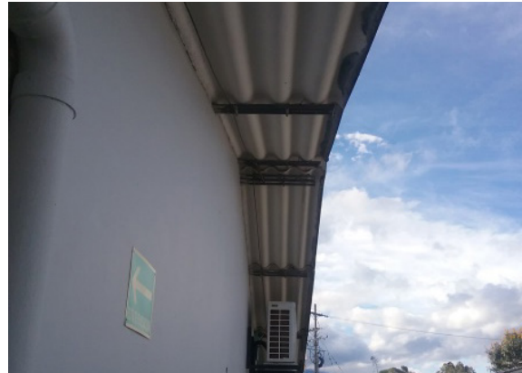
Ilustración 83 Estructura cubierta bloque 8 Fuente. Equipo de diagnóstico
