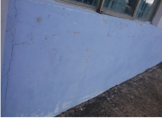
Ilustración 50 Evidencia de fisuras y/o grietas en placa de contrapiso, elementos estructurales y no estructurales Fuente. Equipo de diagnóstico.
