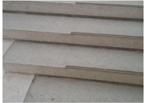
Ilustración 91 Estructura bloque 10 y 11 Fuente. Equipo de diagnóstico
