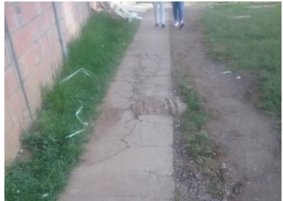
Ilustración 55 Estructura parte A Fuente. Equipo de diagnóstico
