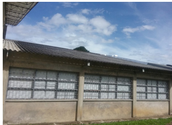
Ilustración 93 Estructura de cubierta bloque 10 Fuente. Equipo de diagnóstico
