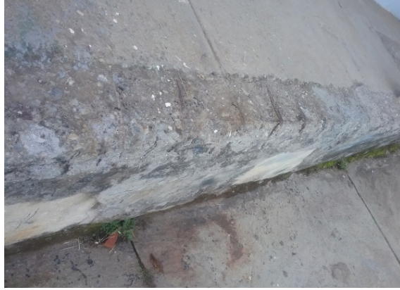
Ilustración 60 Evidencia de viga de amarre en andén perimetral Fuente. Equipo de diagnóstico
