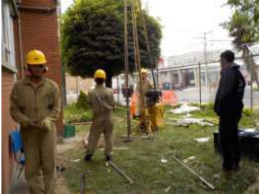
Fotografía 4-7 Ejecución del Sondeo S-4 Fuente: Técnicas Colombianas de Ingeniería, 2016
