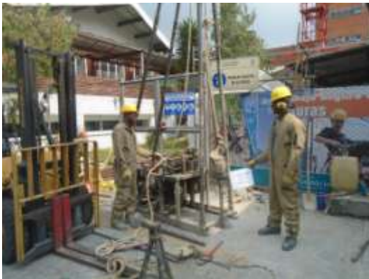
Fotografía 4-15 Ejecución del Sondeo S-8 Fuente: Técnicas Colombianas de Ingeniería, 2016
