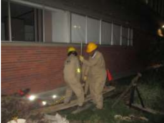
Fotografía 4-1 Ejecución del Sondeo S-1 Fuente: Técnicas Colombianas de Ingeniería, 2016
