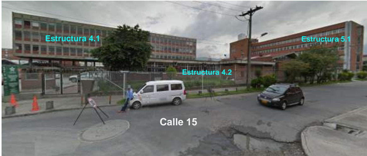
Fotografía 2-4 Vista de Estructura 4.1, Estructura 4.2 y Estructura 5.1 (Desde la Calle 15) Fuente: Google Street View, 2016
