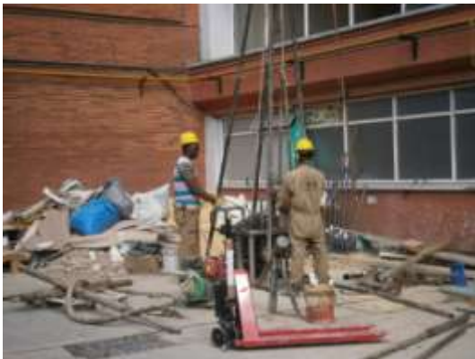
Fotografía 4-21 Ejecución del Sondeo S-11 Fuente: Técnicas Colombianas de Ingeniería, 2016
