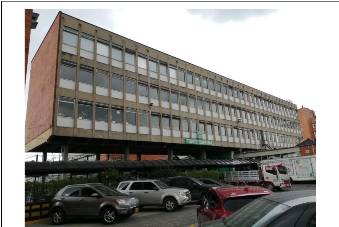
Fotografía 4. Parte de Fachada de la Torre Oriental
