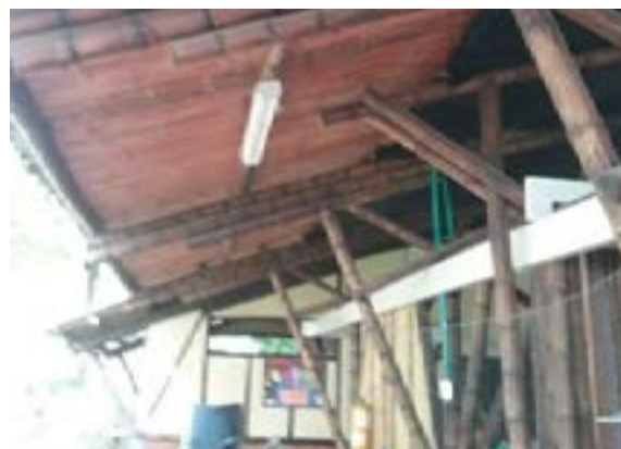
Ilustración 151 Iluminación (Tubería PVC expuesta). Fuente: equipo diagnóstico.
