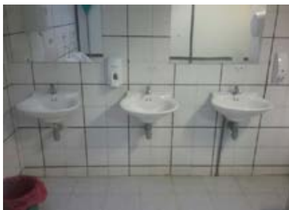
Ilustración 486 Sifón de Lavamanos en PVCs de 2". Fuente: equipo diagnóstico.
