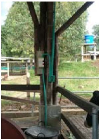
Ilustración 111 Salida para tomacorriente.. Fuente: equipo diagnóstico.
