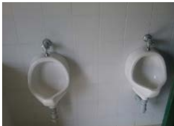
Ilustración 459 Sifón de orinal en PVC de 2". Fuente: equipo diagnóstico.
