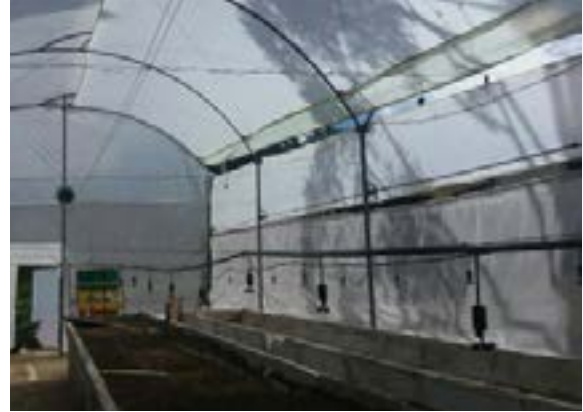
Ilustración 160 Iluminación (Conductores eléctricos expuestos). Fuente: equipo diagnóstico.
