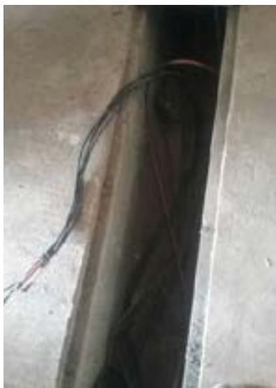
Ilustración 8 Conductores eléctricos (Desorganizados). Fuente: equipo diagnóstico.
