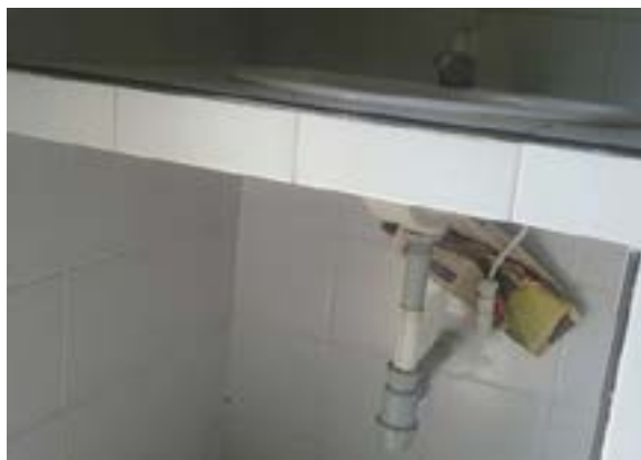
Ilustración 458 Sifón de lavamanos en PVC de 2". Fuente: equipo diagnóstico.
