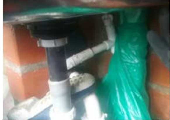
Ilustración 507 Sifón de lavaplatos en PVC de 2". Fuente: equipo diagnóstico.
