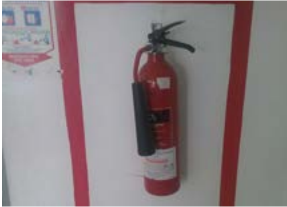
Ilustración 510 Extintor tipo CO2. Fuente: equipo diagnóstico.
