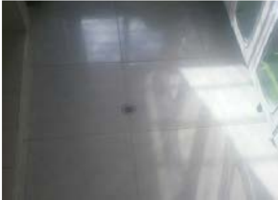
Ilustración 532 Sifón de piso en aluminio de 2". Fuente: equipo diagnóstico.
