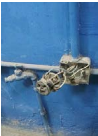
Ilustración 189 tomacorriente Fuente: equipo diagnóstico.
