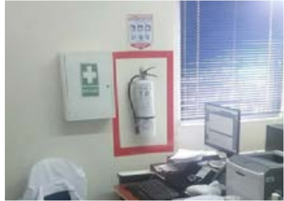
Ilustración 511 Extintor tipo Solkaflam. Fuente: equipo diagnóstico.
