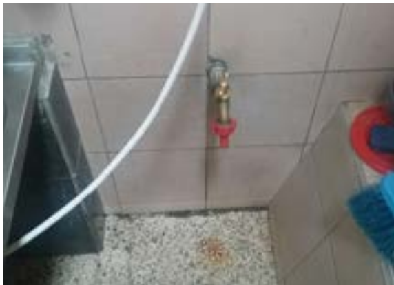
Ilustración 483 Punto hidráulico de \frac{1}{2} " en HG. Fuente: equipo diagnóstico.
