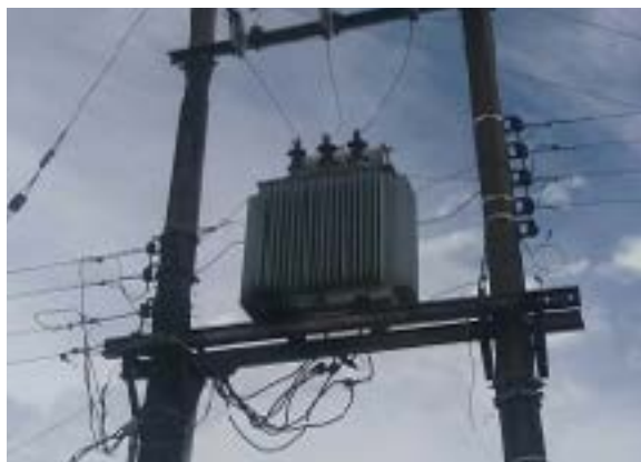
Ilustración 10. Subestación tipo poste. Fuente: equipo diagnóstico.
