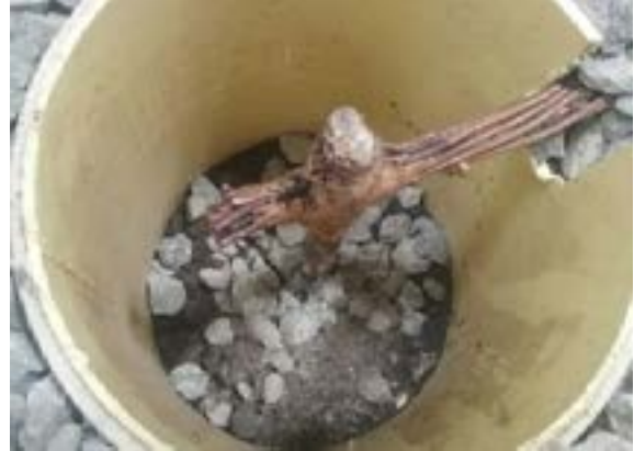
Ilustración 18 Electrodo de puesta a tierra. Fuente: equipo diagnóstico.
