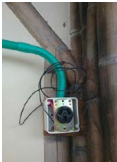
Ilustración 110 Tomacorriente trifásico (Conductores eléctricos expuestos). Fuente: equipo diagnóstico.
