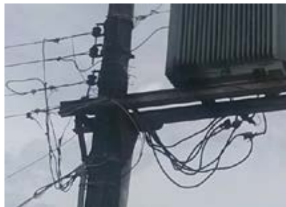
Ilustración 11 Subestación tipo poste (Conductores desorganizados). Fuente: equipo diagnóstico.
