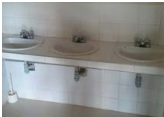
Ilustración 393 Sifón de Lavamanos en PVC de 2". Fuente: equipo diagnóstico.
