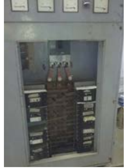
Ilustración 14 Barrajes sin código de colores. Fuente: equipo diagnóstico.
