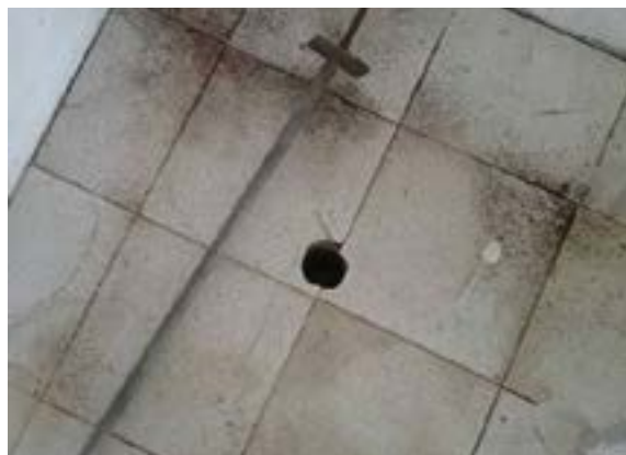
Ilustración 374 Sifón de piso en 3". Fuente: equipo diagnóstico.
