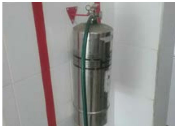
Ilustración 518 Extintor tipo agua a presión. Fuente: equipo diagnóstico.
