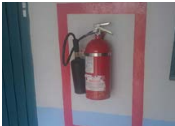
Ilustración 489 Extintor tipo CO2. Fuente: equipo diagnóstico.
