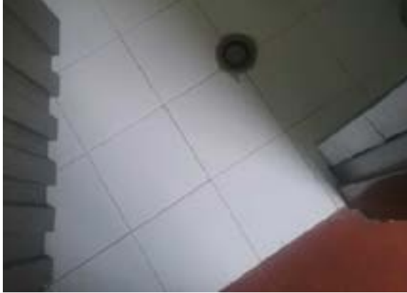
Ilustración 506 Sifón de piso deshabilitado en 2". Fuente: equipo diagnóstico.
