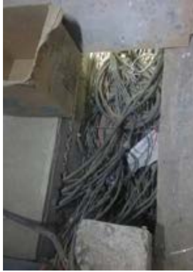
Ilustración 13 Conductores eléctricos desorganizados. Fuente: equipo diagnóstico.
