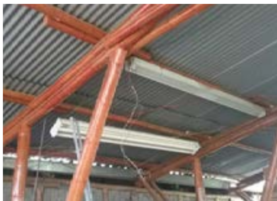
Ilustración 350 Iluminación (Conductores eléctricos expuestos) Fuente: equipo de diagnóstico.
