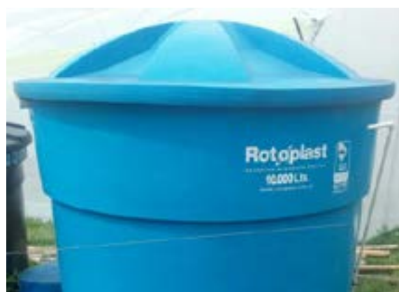
Ilustración 448 Tanque plástico de 10 m 3 . Fuente: equipo diagnóstico.
