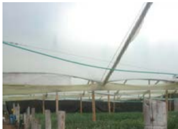
Ilustración 136 Tubería PVC expuesta. Fuente: equipo diagnóstico.
