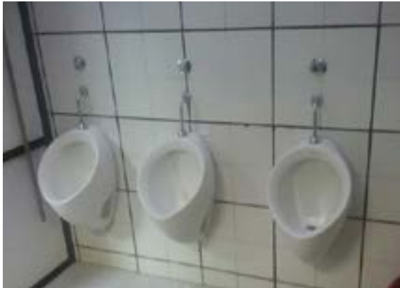
Ilustración 481 Orinal tipo push. Fuente: equipo diagnóstico.
