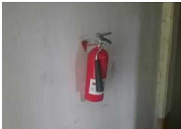
Ilustración 517 Extintor tipo CO2. Fuente: equipo diagnóstico.
