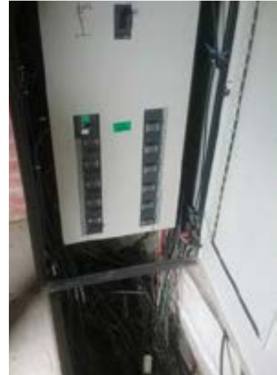
Ilustración 6 Tablero general de acometidas. Fuente: equipo diagnóstico.
