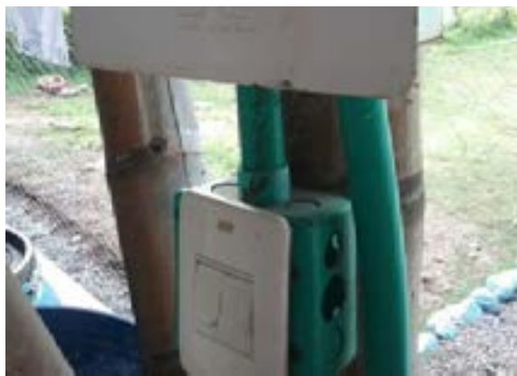
Ilustración 147 Tablero de distribución (Tubería PVC expuesta). Fuente: equipo de diagnóstico.
