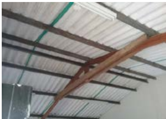
Ilustración 105 Iluminación (Tubería PVC expuesta). Fuente: equipo diagnóstico.
