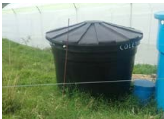
Ilustración 447 Tanque plástico de 5m 3 . Fuente: equipo diagnóstico.
