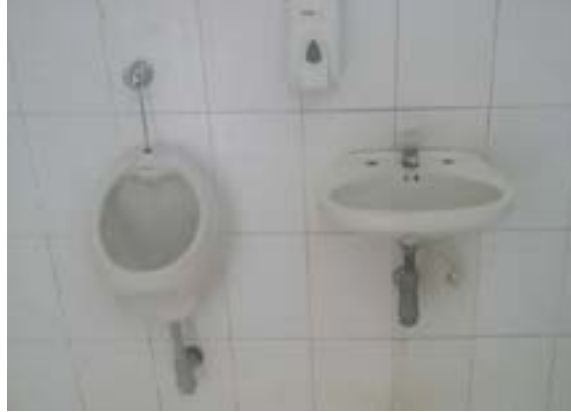
Ilustración 448 Sifón de lavamanos y orinal en PVCS de 2". Fuente: equipo de diagnóstico.
