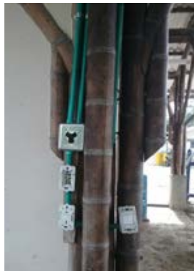
Ilustración 112 Tomacorriente (En malas condiciones). Fuente: equipo diagnóstico.
