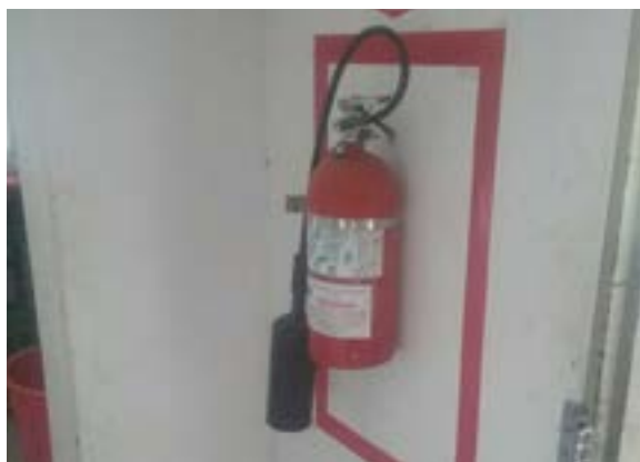
Ilustración 493 extintor tipo CO 2 . Fuente: equipo diagnóstico.
