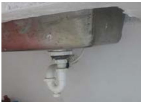
Ilustración 540 Sifón de lavaplatos en PVCS de 2". Fuente: equipo diagnóstico.
