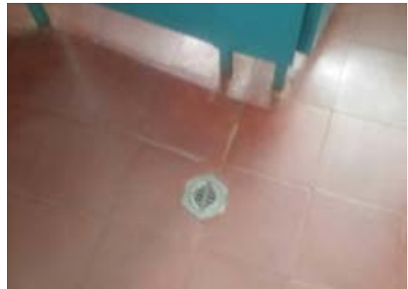
Ilustración 516 Sifón de piso en aluminio de 2". Fuente: equipo diagnóstico.
