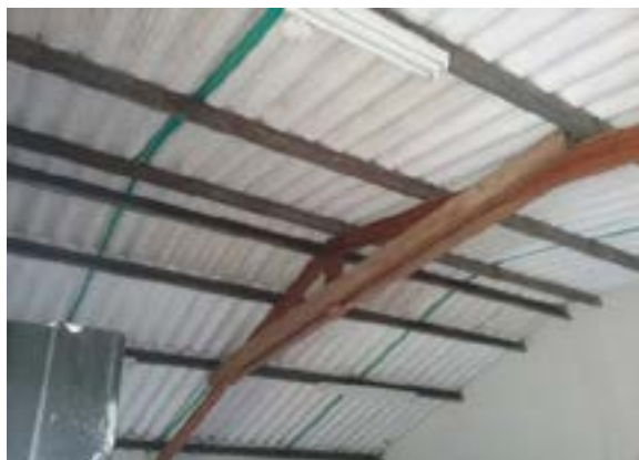
Ilustración 107 Iluminación (Tubería PVC expuesta). Fuente: equipo diagnóstico.
