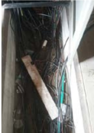
Ilustración 5 Conductores eléctricos (Desorganizados). Fuente: equipo diagnóstico.
