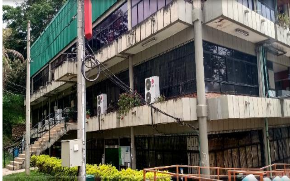
Fotografía 3. Bloque No. 8 Fachada Lateral
