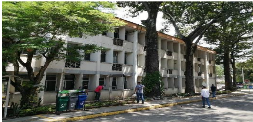
Fotografía 5. Bloque No. 9 Centro de Electricidad y Automatización Industrial - CEAI
