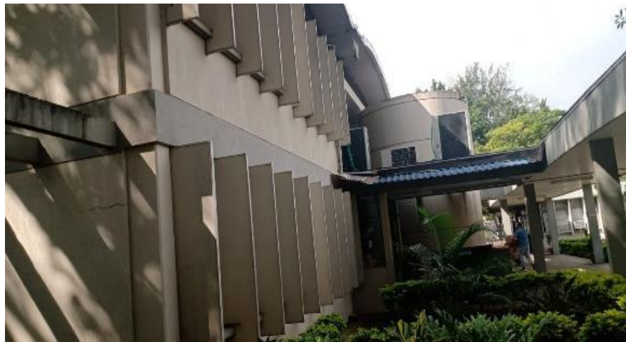
Fotografía 4. Bloque No. 1 Centro de Electricidad y Automatización Industrial - CEAI
