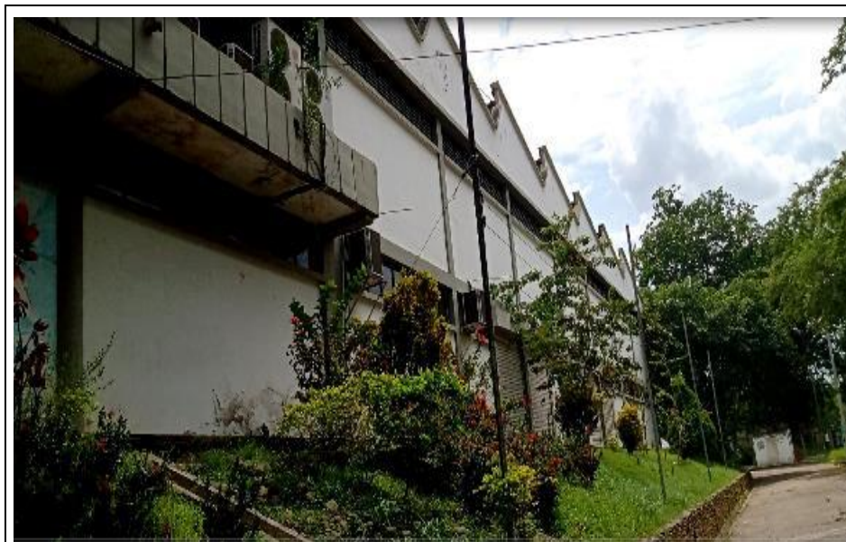
Fotografía 4. Bloque No. 8 Fachada Frontal
