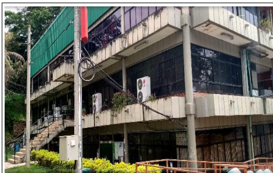
Fotografía 3. Bloque No. 8 Fachada Lateral
