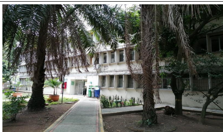
Fotografía 7. Bloque No. 10 Administrativo – Despacho Regional
