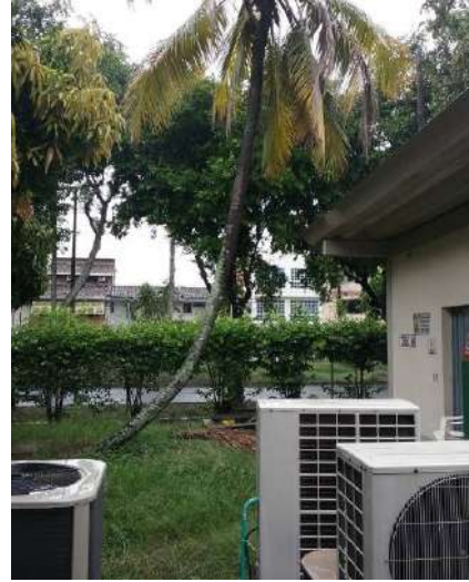
Ilustración 51. Árbol inclinado en un costado Fuente. Equipo de diagnóstico
