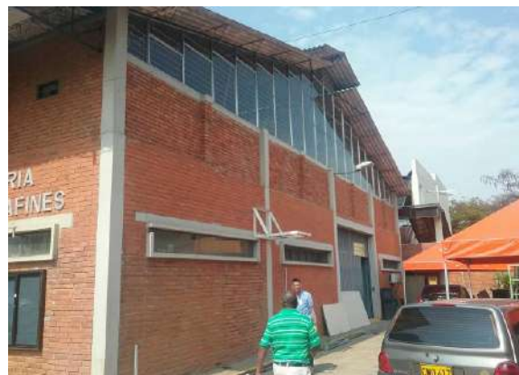
Ilustración 93. Estructura pórtico en concreto Bloque 7 Fuente. Equipo de diagnóstico
