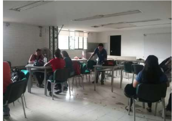
Ilustración 95. Estado de placa de contrapiso Bloque 7 Fuente. Equipo de diagnóstico
