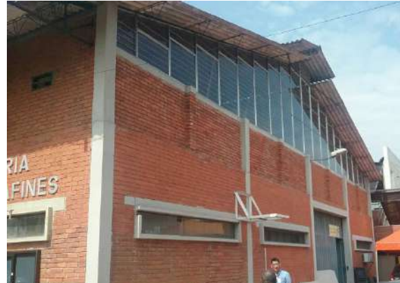
Ilustración 98. Cubierta teja asbesto cemento Fuente. Equipo de diagnóstico
