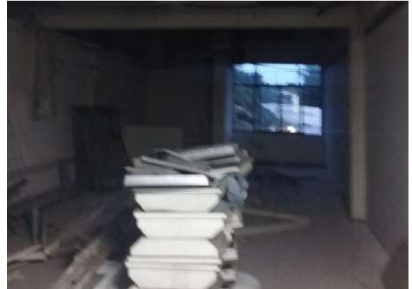
Ilustración 104. Espacios en remodelación bloque 8 Fuente. Equipo de diagnóstico
