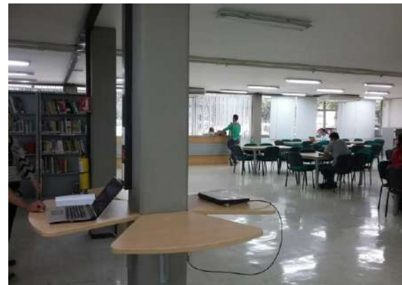
Ilustración 133. Estructura bloque 12 Fuente. Equipo de diagnóstico
