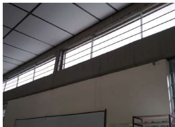
Ilustración 75. Estructura Bloque 4 Fuente. Equipo de diagnóstico
