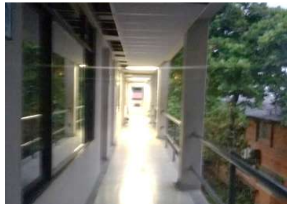
Ilustración 103. Estructura Bloque 8 Fuente. Equipo de diagnóstico
