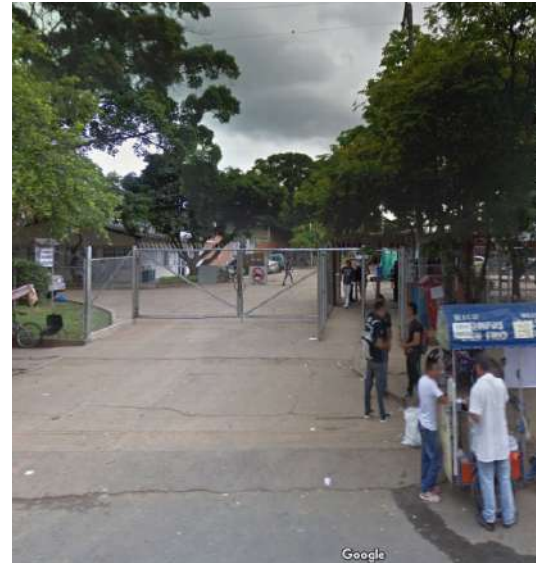
Ilustración 9. Fachada desde Carrera 2. Fuente: (2016). Google.com.co. (5 mayo/2016).
