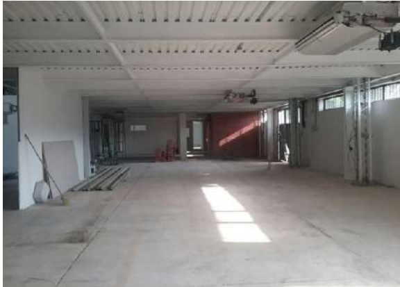
Ilustración 97. Cubierta con perfiles metálicos tipo "C" Fuente. Equipo de diagnóstico
