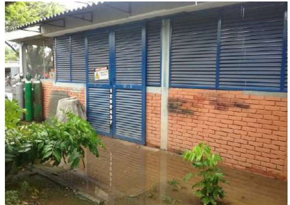
Ilustración 126. Fachadas bloque 11 y 30 Fuente. Equipo de diagnóstico
