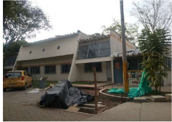
Ilustración 83. Fachadas Bloque 6 Fuente. Equipo de diagnóstico
