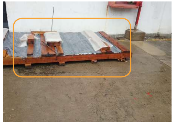
Ilustración 48. Presencia de fisuras en pavimento y andén frontal Fuente. Equipo de diagnóstico
