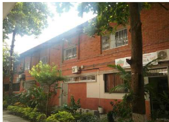
Ilustración 92. Fachadas del bloque 7 Fuente. Equipo de diagnóstico
