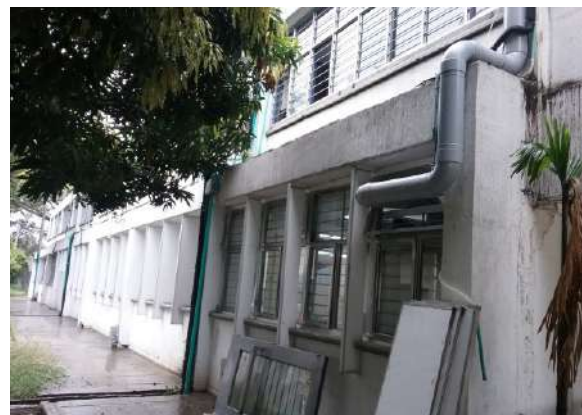
Ilustración 43. Fachadas del bloque 1 Fuente. Equipo de diagnóstico
