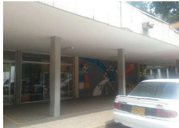
Ilustración 143. Estructura bloque 13 Fuente. Equipo de diagnóstico
