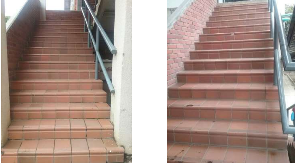
Ilustración 108. Escaleras de acceso que sirven como evacuación. Fuente. Equipo de diagnóstico
