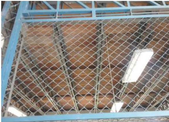
Ilustración 58. Cubierta en madera Fuente. Equipo de diagnóstico
