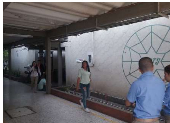
Ilustración 76. Estructura Bloque 5 Fuente. Equipo de diagnóstico
