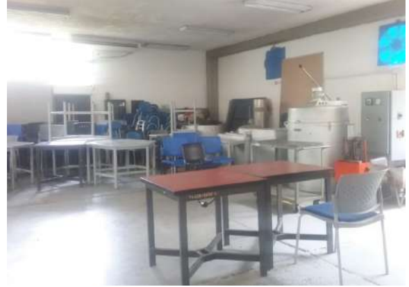
Ilustración 54. Estructura Bloque 2 Fuente. Equipo de diagnóstico
