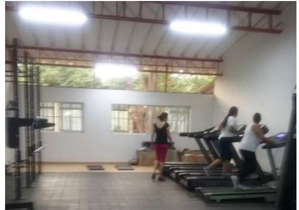
Ilustración 88. Cubierta teja asbesto cemento con estructura metálica Fuente. Equipo de diagnóstico
