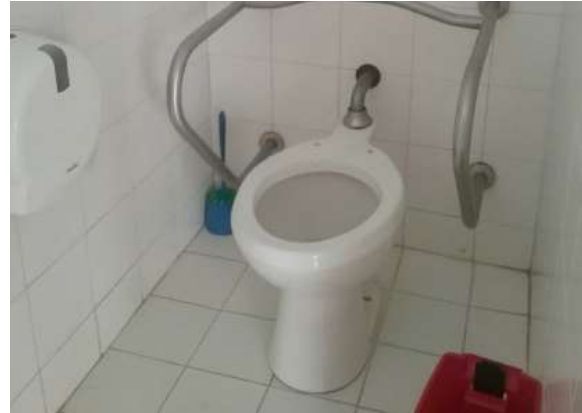
Ilustración 433. Retrete tipo push. Fuente. Equipo de diagnóstico
