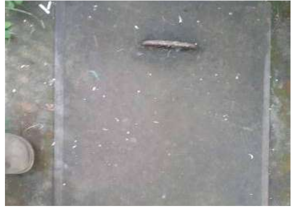
Ilustración 323. Sumidero lateral con rejilla en concreto. Fuente. Equipo de diagnóstico
