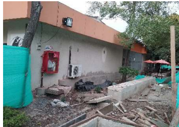
Ilustración 200. tablero Fuente. Equipo de diagnóstico
