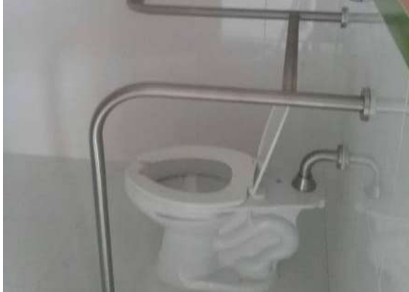
Ilustración 454. Retrete tipo push. Fuente. Equipo de diagnóstico
