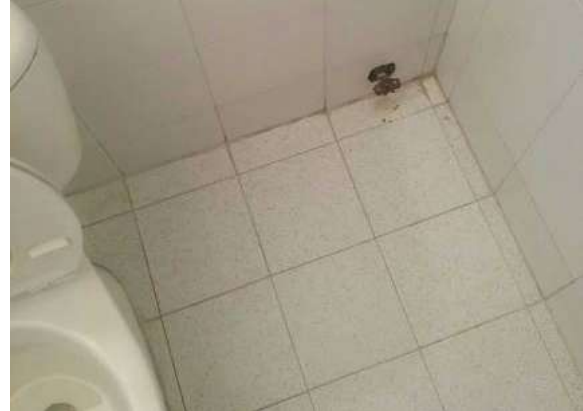
Ilustración 333. Válvula de control de paso directo. Fuente. Equipo de diagnóstico
