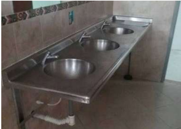
Ilustración 412. Sifón extensible en 2". Fuente. Equipo de diagnóstico
