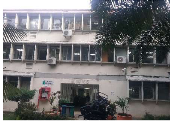
Ilustración 256. luminarias Fuente. Equipo de diagnóstico
