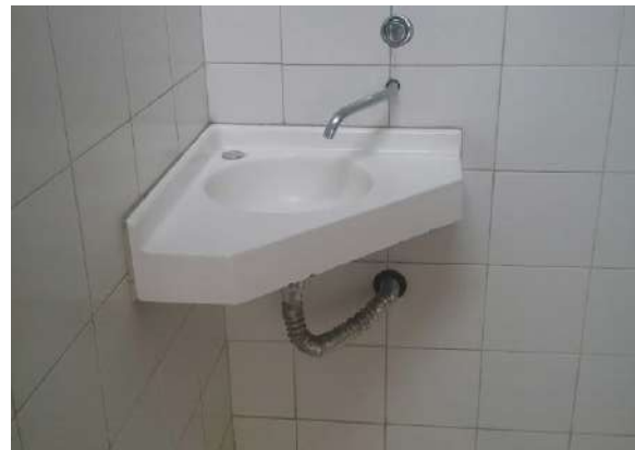
Ilustración 104. fotografía del espacio N° 4-5 del bloque 16 Fuente: Equipo diagnóstico
