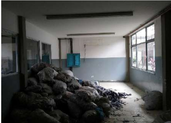
Ilustración 213. Tablero Fuente. Equipo de diagnóstico
