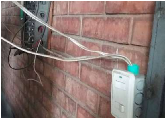
Ilustración 178. Tubería Fuente. Equipo de diagnóstico
