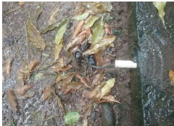
Ilustración 296. electrodo de puesta a tierra Fuente. Equipo de diagnóstico
