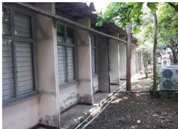
Ilustración 158. condensadoras Fuente. Equipo de diagnóstico
