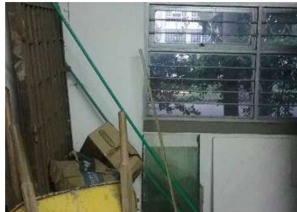
Ilustración 271. subestación Fuente. Equipo de diagnóstico
