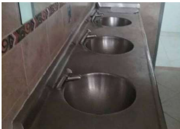
Ilustración 410. Lavamanos tipo push. Fuente. Equipo de diagnóstico
