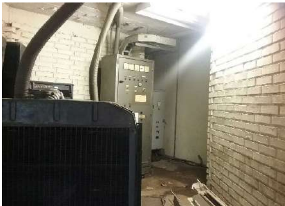
Ilustración 290. TGA y planta de suplencia. Fuente. Equipo de diagnóstico
