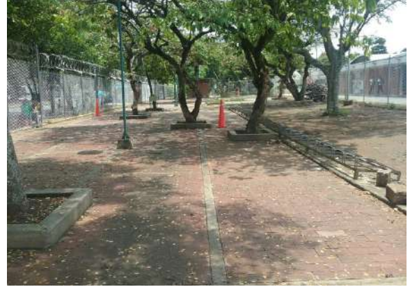
Ilustración 108. Exterior 15 Fuente. Equipo de diagnóstico
