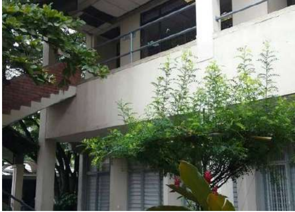
Ilustración 385. Fachada bloque 8. Fuente. Equipo de diagnóstico
