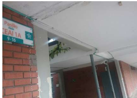
Ilustración 302. tubería pvc. Fuente. Equipo de diagnóstico
