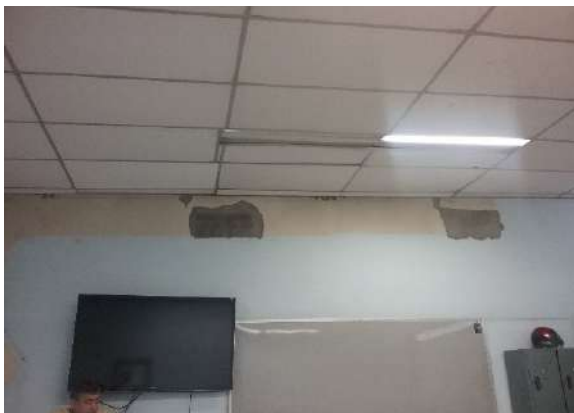
Ilustración 163. Ductos Fuente. Equipo de diagnóstico
