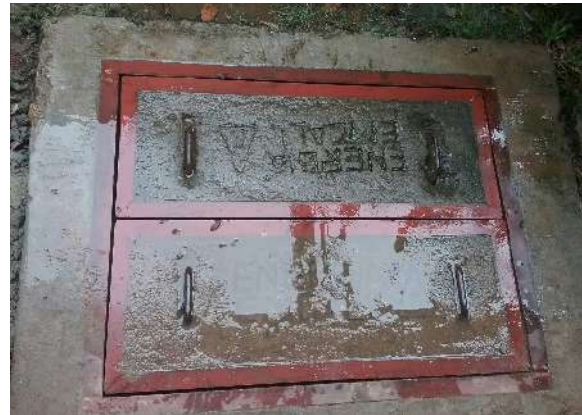
Ilustración 314. caja de inspección Fuente. Equipo de diagnóstico
