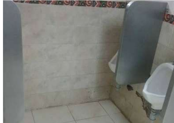
Ilustración 413. Sifón de orinal en PVCS de 2". Fuente. Equipo de diagnóstico
