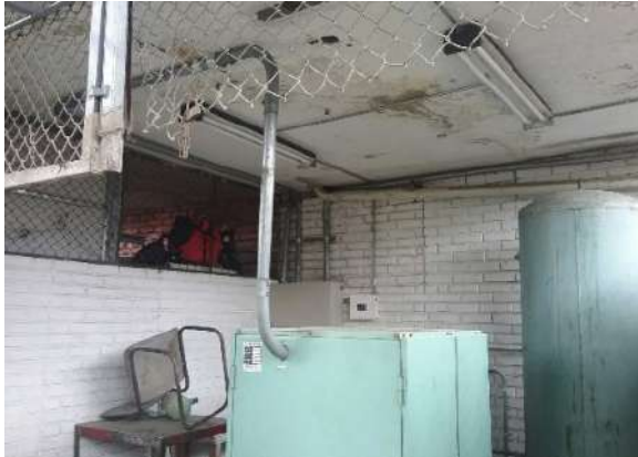
Ilustración 310. tablero Fuente. Equipo de diagnóstico
