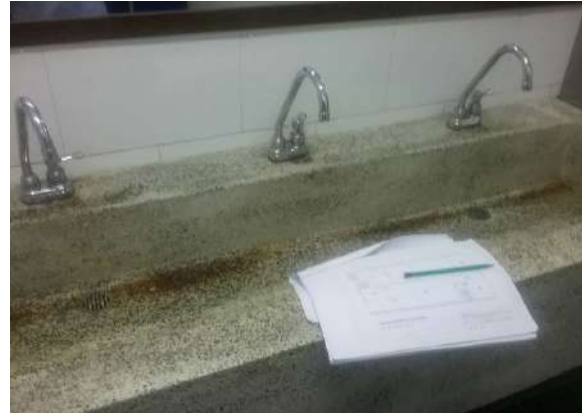
Ilustración 349. Instalación de lavamanos en el baño. Fuente. Equipo de diagnóstico
