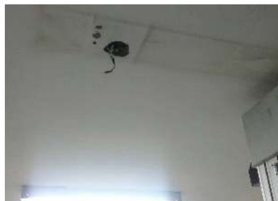
Ilustración 125. luminarias Fuente. Equipo de diagnóstico
