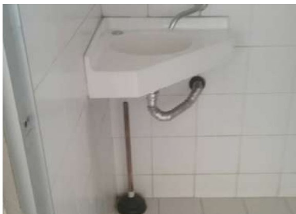
Ilustración 436. Sifón de aluminio en 2". Fuente. Equipo de diagnóstico
