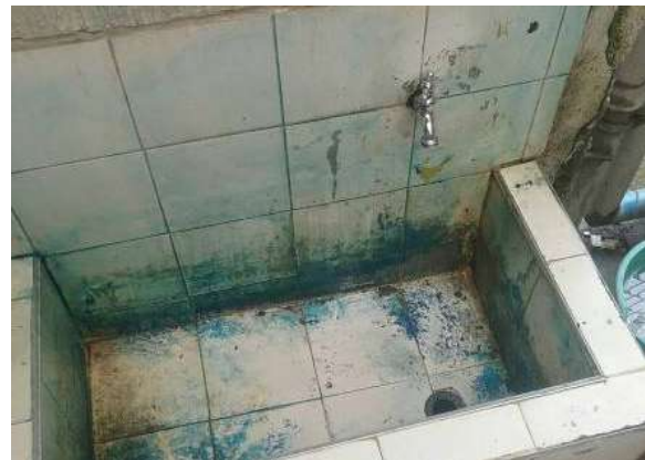
Ilustración 335. Poceta de aseo bloque 1. Fuente. Equipo de diagnóstico
