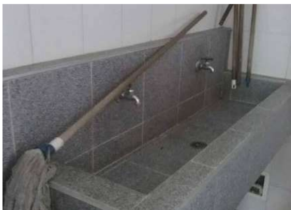
Ilustración 393. Lavamanos. Fuente. Equipo de diagnóstico
