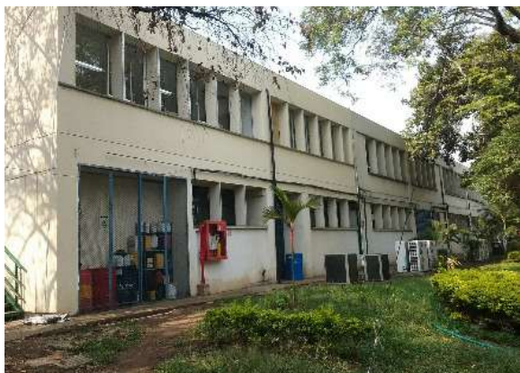
Ilustración 140. Condensadoras Fuente. Equipo de diagnóstico
