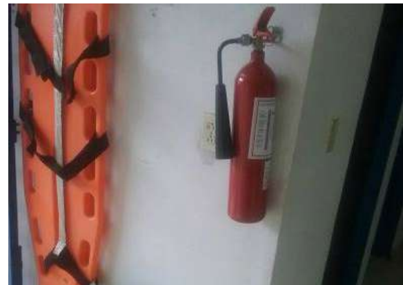
Ilustración 358. Extintor tipo CO2. Fuente. Equipo de diagnóstico
