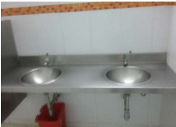
Ilustración 406. Sifón de lavamanos de PVC en 2". Fuente. Equipo de diagnóstico
