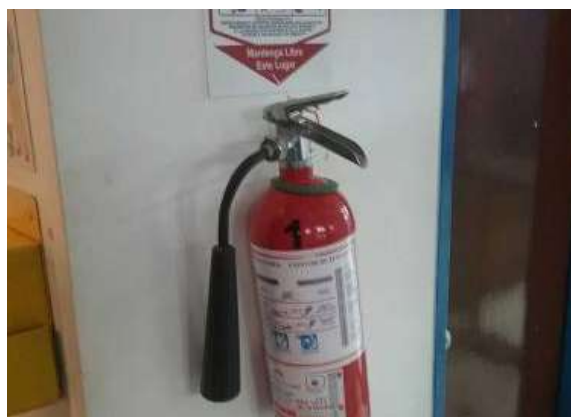
Ilustración 343. Extintor tipo Solkaflam. Fuente. Equipo de diagnóstico
