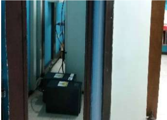
Ilustración 197. Tablero Fuente. Equipo de diagnóstico
