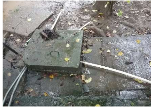
Ilustración 297. caja de inspección Fuente. Equipo de diagnóstico
