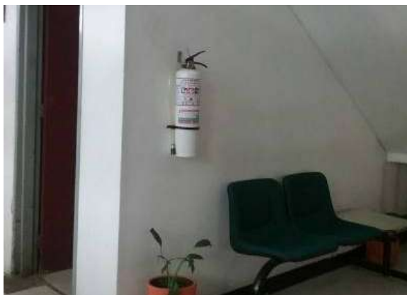
Ilustración 343. Extintor tipo Solkaflam. Fuente. Equipo de diagnóstico
