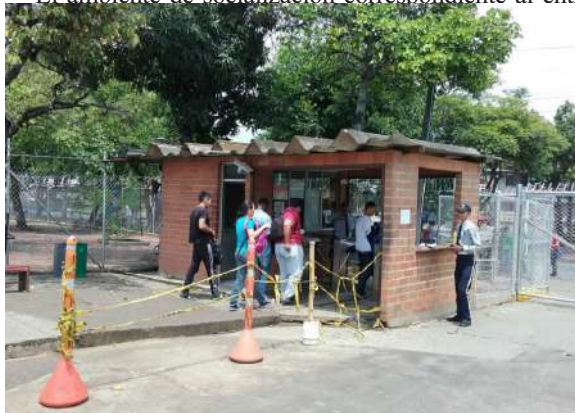
Ilustración 73. Fachada Bloque No.25. Fuente. Equipo de diagnóstico
