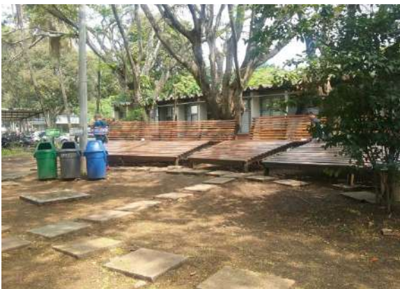
Ilustración 111. exterior 9 Fuente. Equipo de diagnóstico
