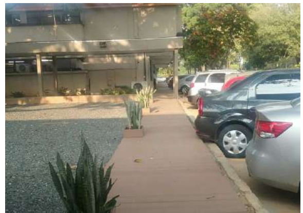
Ilustración 112. exterior 18 Fuente. Equipo de diagnóstico
