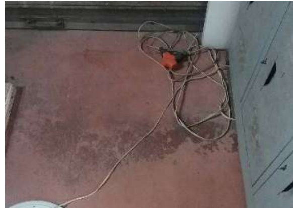
Ilustración 181. Tomacorriente Fuente. Equipo de diagnóstico
