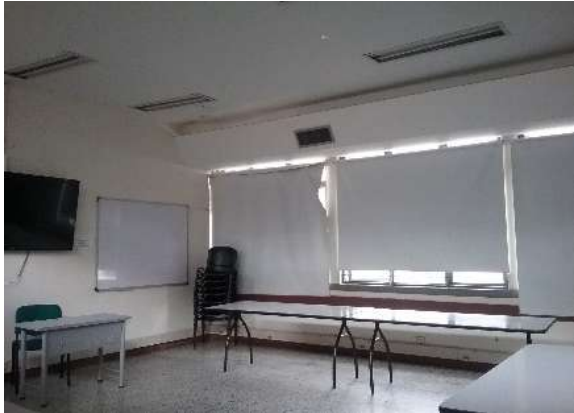
Ilustración 165. Ductos Fuente. Equipo de diagnóstico
