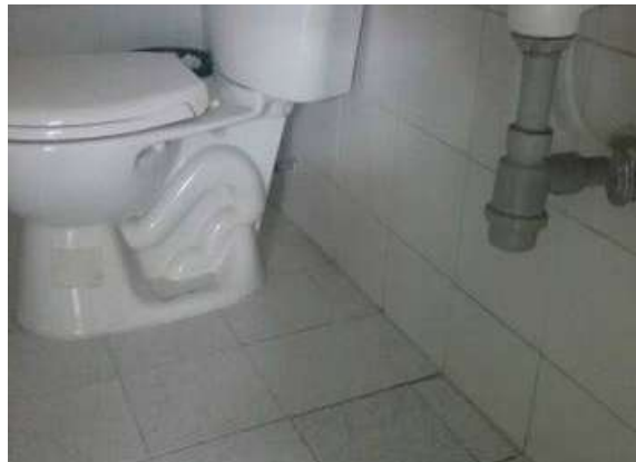
Ilustración 339. Sifón de lavaplatos en 2" de PVCS. Fuente. Equipo de diagnóstico
