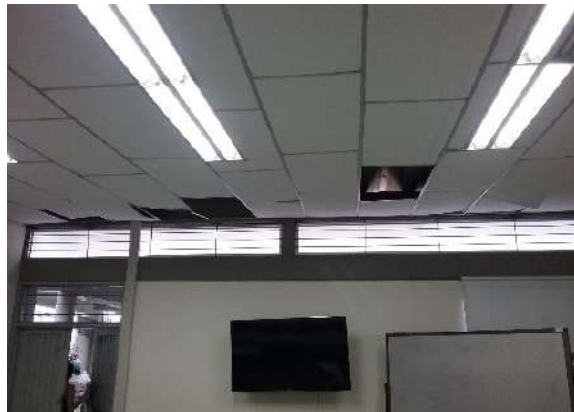
Ilustración 155. luminarias Fuente. Equipo de diagnóstico
