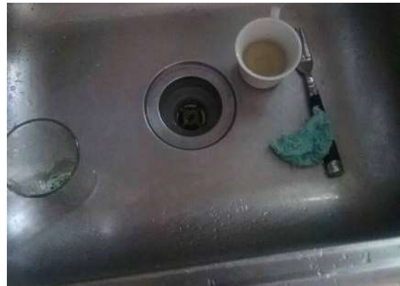
Ilustración 379. Lavaplatos en mal estado. Fuente. Equipo de diagnóstico
