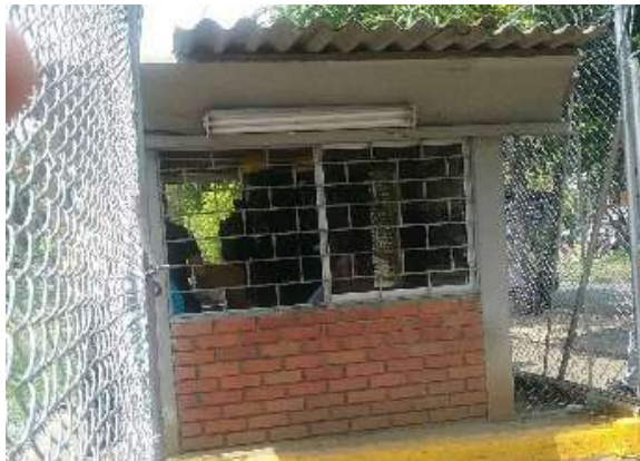
Ilustración 299. luminarias Fuente. Equipo de diagnóstico
