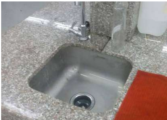
Ilustración 334. Lavamanos del laboratorio de química. Fuente. Equipo de diagnóstico
