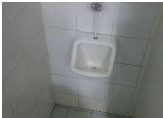
Ilustración 370 Retrete tipo fluxómetro. Fuente. Equipo de diagnóstico
