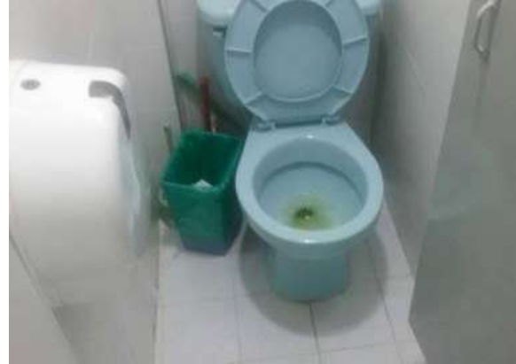
Ilustración 374. Punto hidráulico en PVCP en 1/2". Fuente. Equipo de diagnóstico
