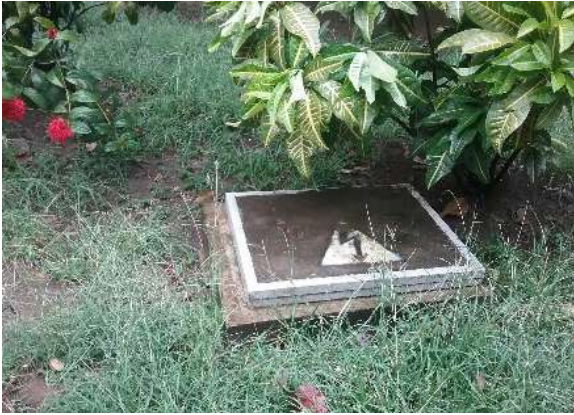
Ilustración 294. caja de inspección Fuente. Equipo de diagnóstico
