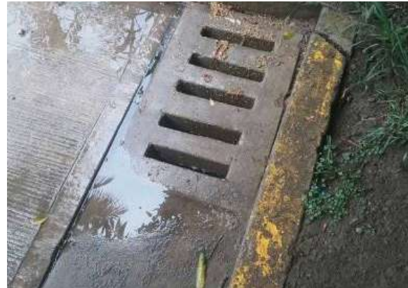
Ilustración 321. Sumidero lateral con rejilla en concreto. Fuente. Equipo de diagnóstico
