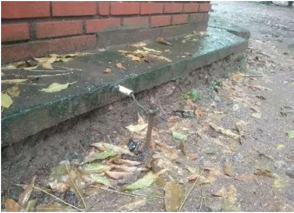
Ilustración 296. electrodo de puesta a tierra Fuente. Equipo de diagnóstico
