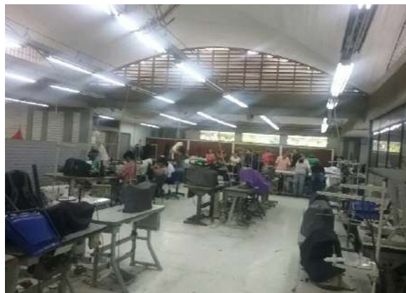
Ilustración 217. tomacorriente para máquinas de confección. Fuente: Equipo diagnóstico.
