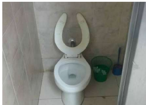
Ilustración 411. Retrete tipo fluxómetro. Fuente. Equipo de diagnóstico
