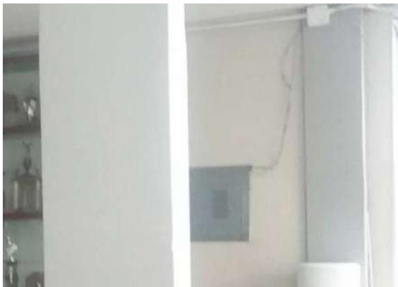
Ilustración 301. Tablero Fuente. Equipo de diagnóstico
