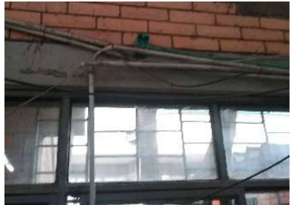
Ilustración 187. tubería PVC Fuente. Equipo de diagnóstico
