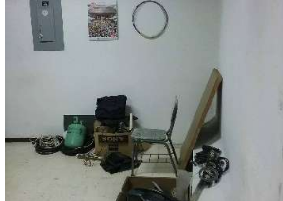
Ilustración 198. tablero Fuente. Equipo de diagnóstico
