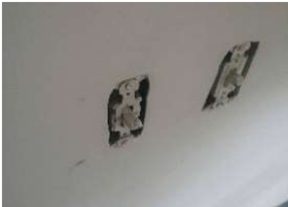
Ilustración 226. luminarias Fuente. Equipo de diagnóstico
