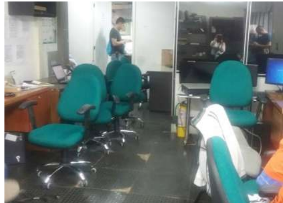
Ilustración 425. Extintor tipo multipropósito en el suelo. Fuente. Equipo de diagnóstico
