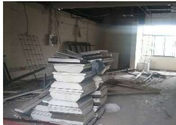
Ilustración 190. tablero Fuente. Equipo de diagnóstico
