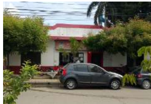
Vista actual del predio Montería
